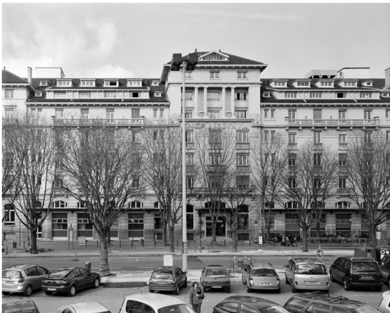
Elévation antérieure : vue partielle
