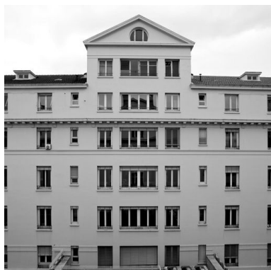
Elévation sur cour Phot. Eric Dessert IVR82_20066900441NUC
