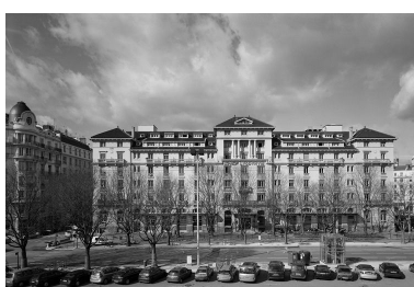
L'élévation antérieure depuis le troisième étage de l'aile sud de la gare des Brotteaux Phot. Eric Dessert IVR82_20066900409V
