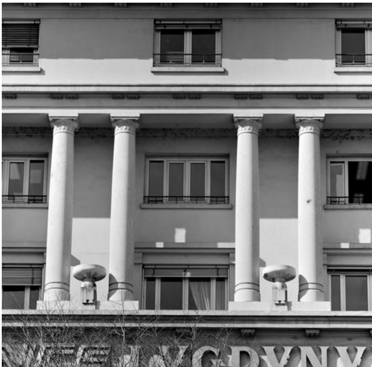
Elévation antérieure : loggia, vue partielle
