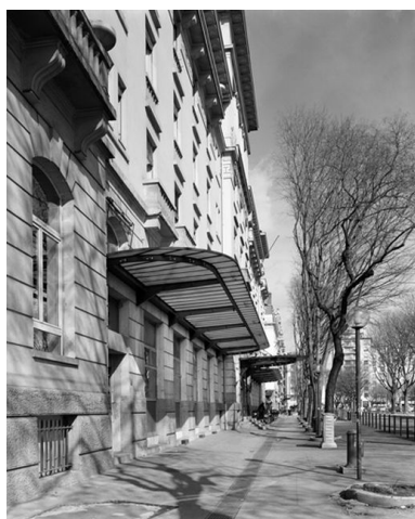
Elévation antérieure, les marquises depuis le sud vers le nord Phot. Eric Dessert IVR82_20066900414V
