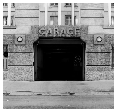
Elévation latérale sud : entrée du garage intégré Phot. Eric Dessert IVR82_20066900420X
