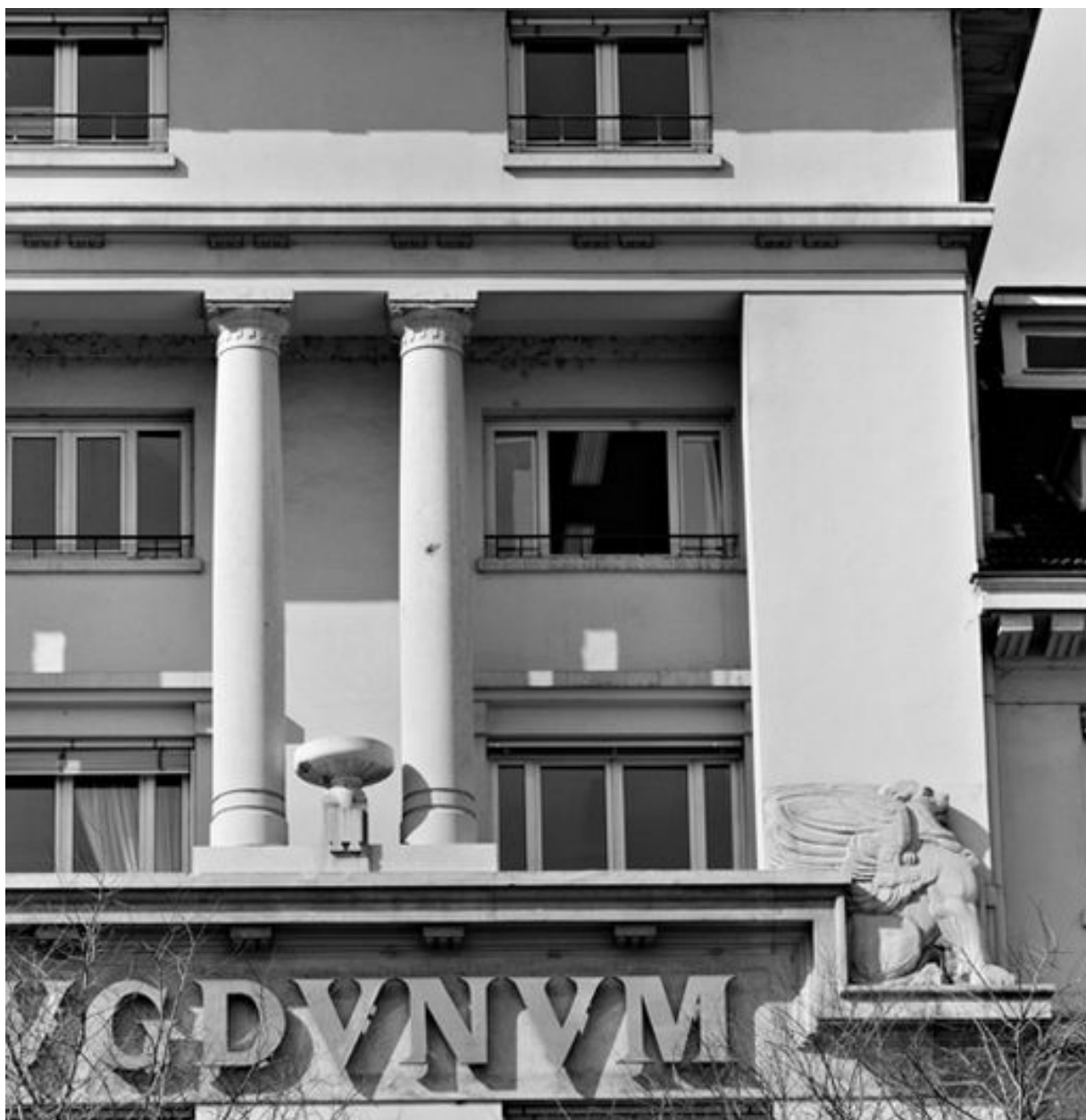
Elévation antérieure : loggia, colonnes et lion ailé
