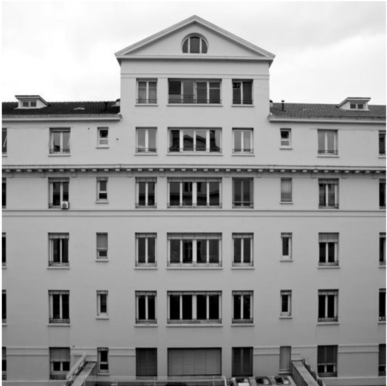
Elévation sur cour
