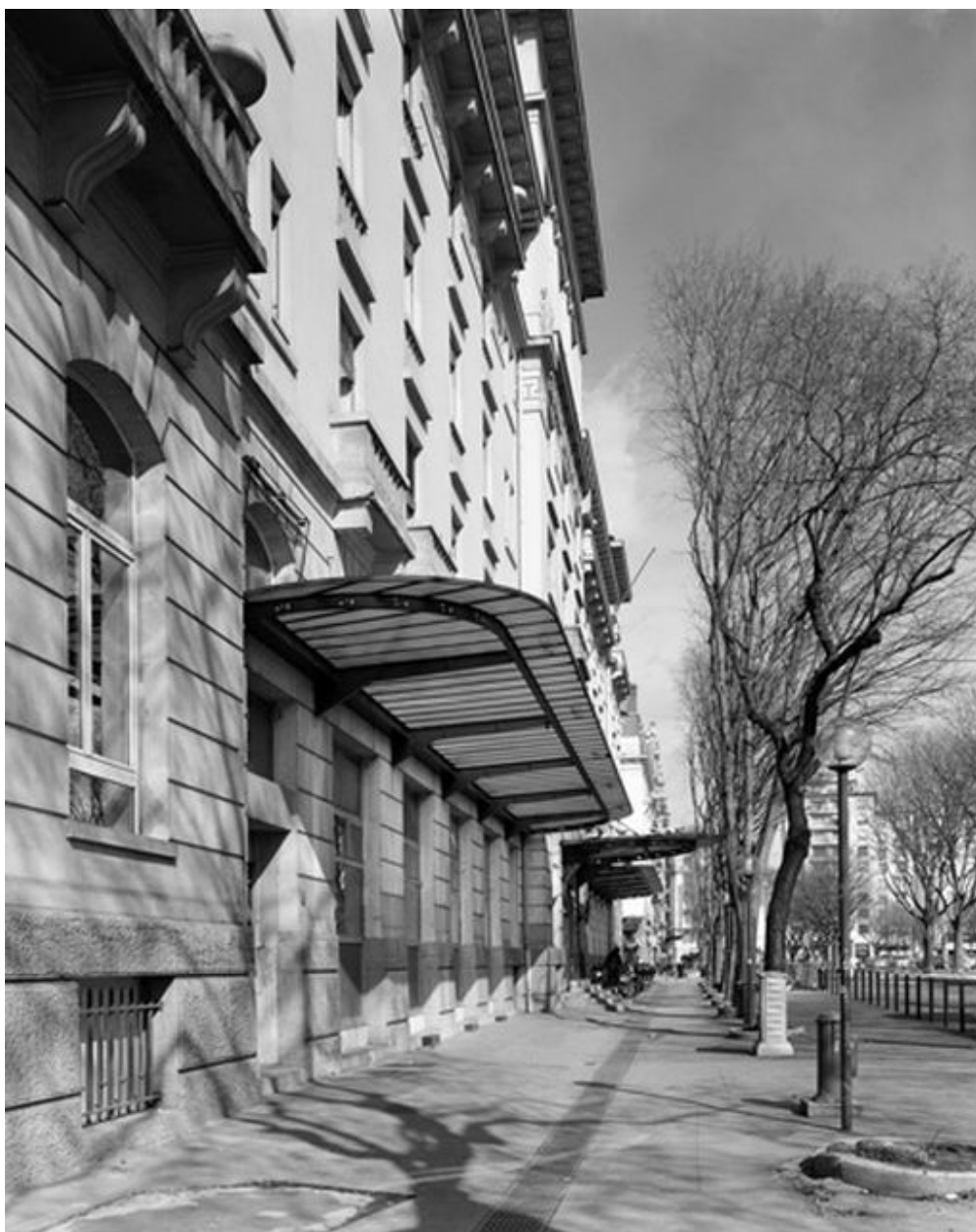
Elévation antérieure, les marquises depuis le sud vers le nord
