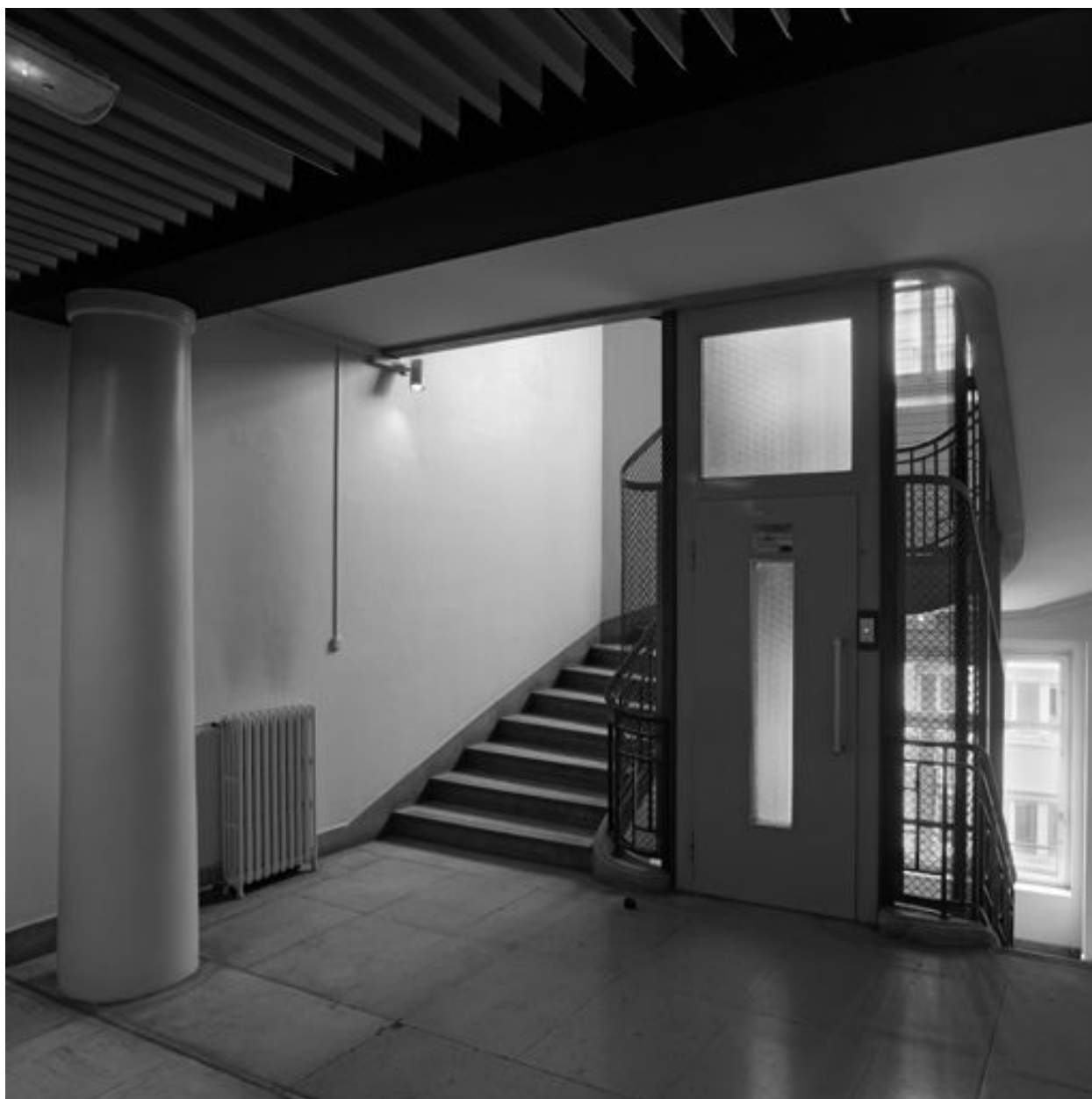
Escalier principal et ascenseur
