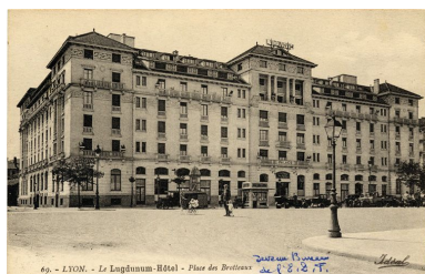
Elévations sur la place Jules- Ferry et sur la rue Vauban IVR82_20056901110NUCB
