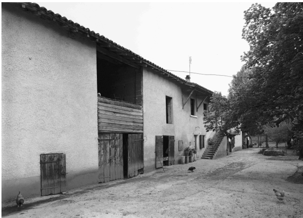
Vue d'ensemble, élévation sur cour.
