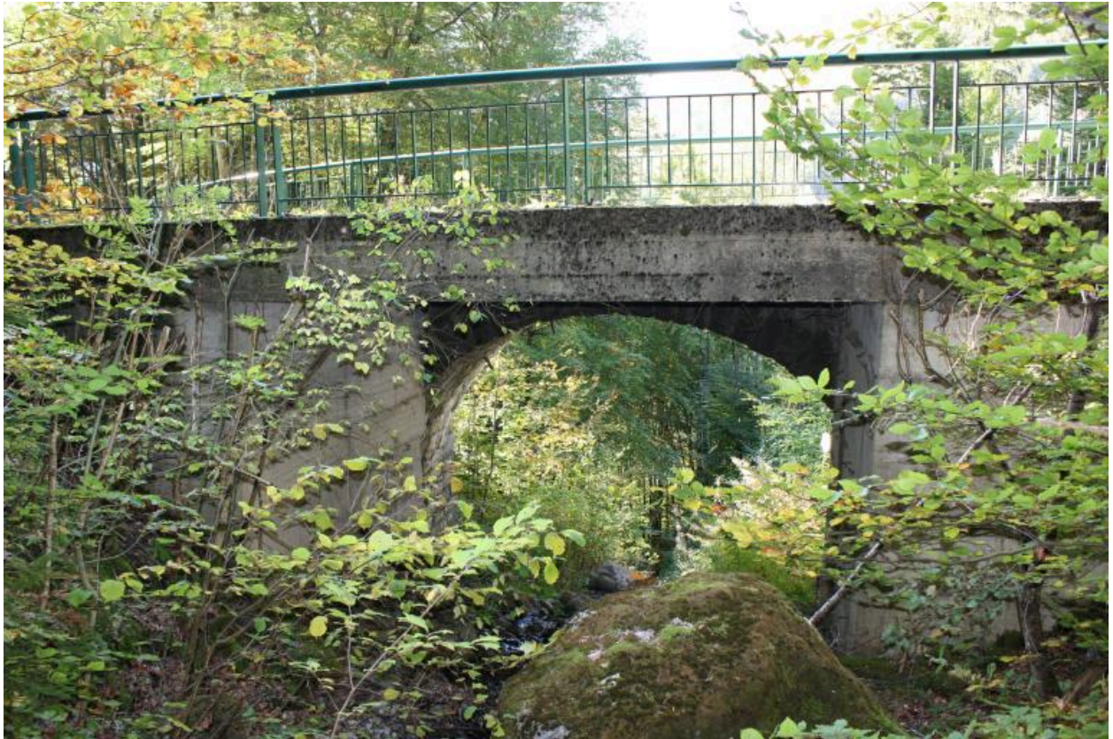
Pont de Bellecombe, face amont
