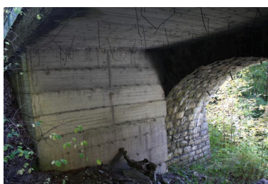
Pont de Bellecombe, détails voute, culée et béton armé Phot. Benoît Huraut IVR84_20207401086NUCA
