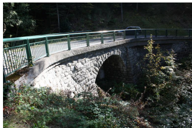
Pont de Bellecombe, face aval IVR84_20197401274NUCA
