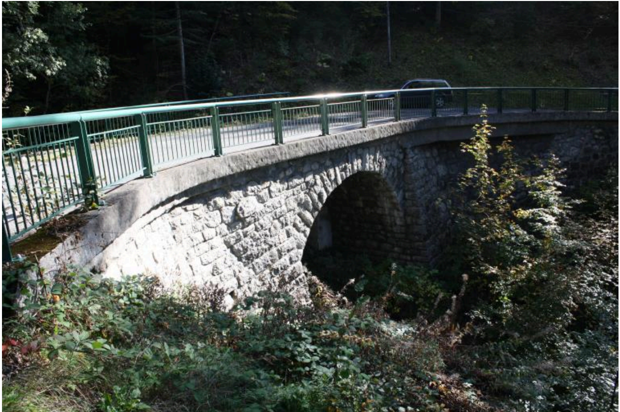
Pont de Bellecombe, face aval
