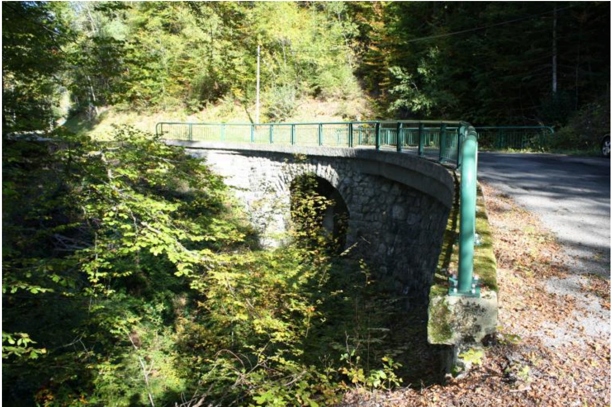
Pont de Bellecombe, contexte chaussée et garde corps
