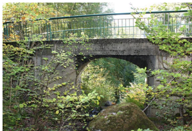
Pont de Bellecombe, face amont Phot. Benoît Huraut IVR84_20207401083NUCA
