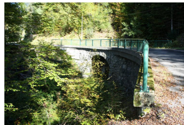
Pont de Bellecombe, contexte chaussée et garde corps Phot. Benoît Huraut IVR84_20207401084NUCA
