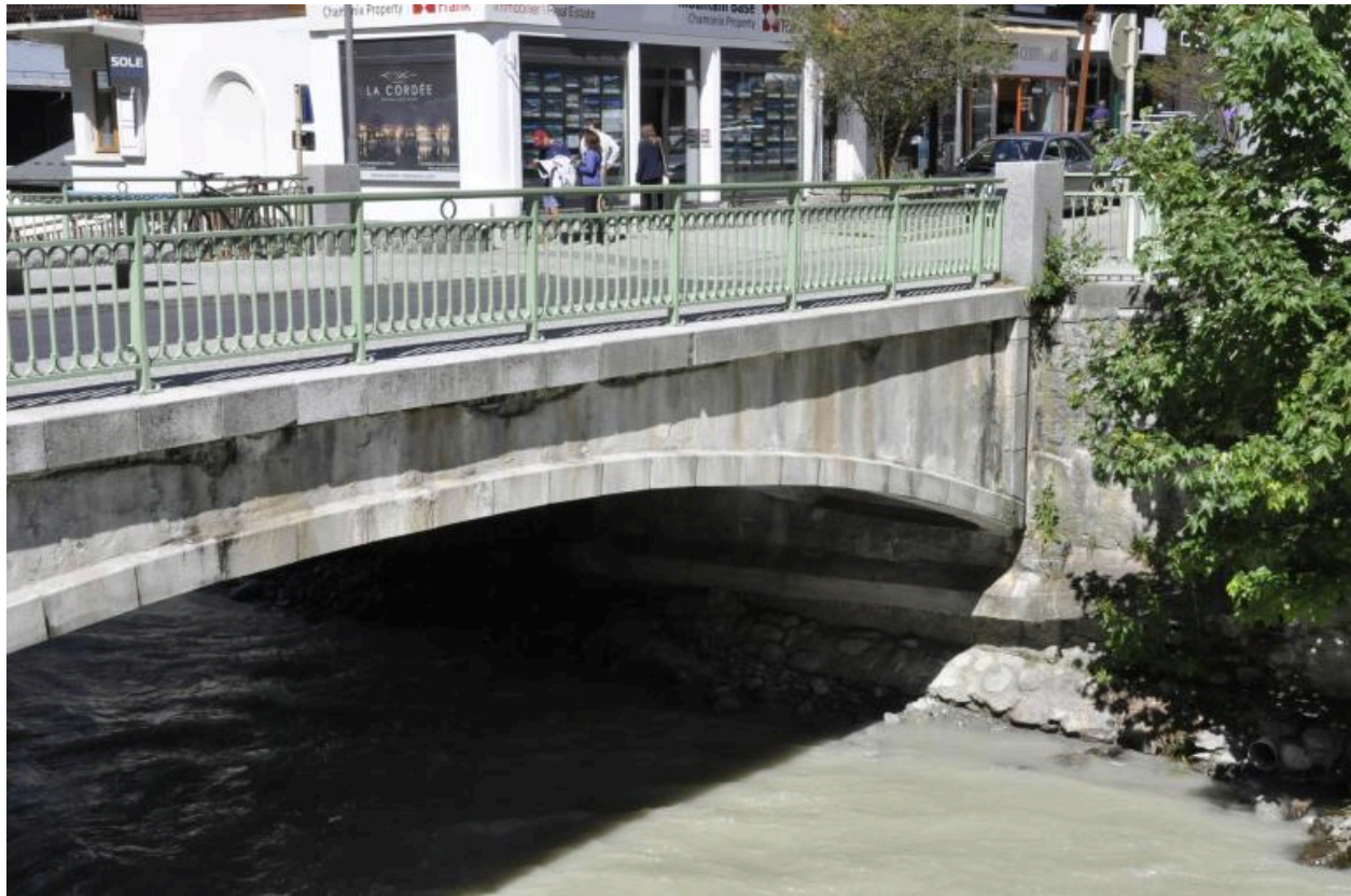
Vue de la face aval du pont prise depuis la rive gauche
