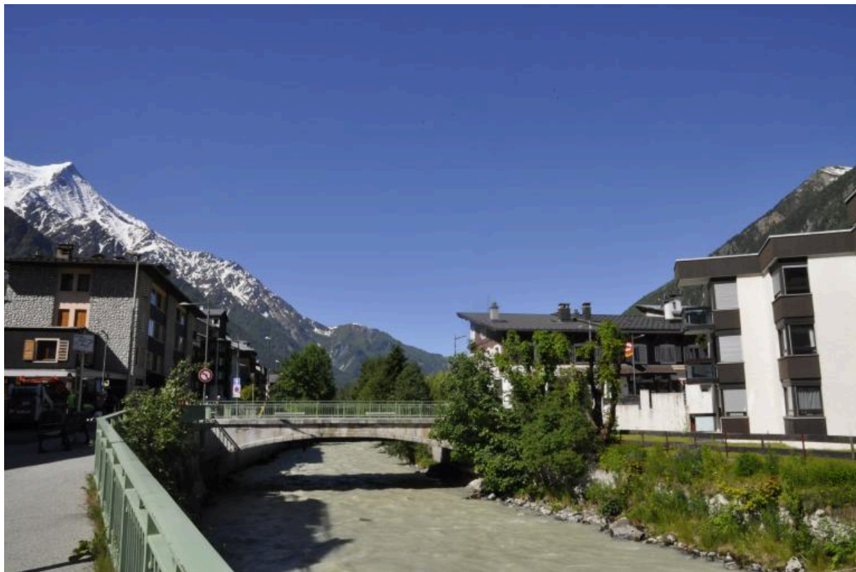
Vue générale du pont enjambant le torrent de l'Arve
