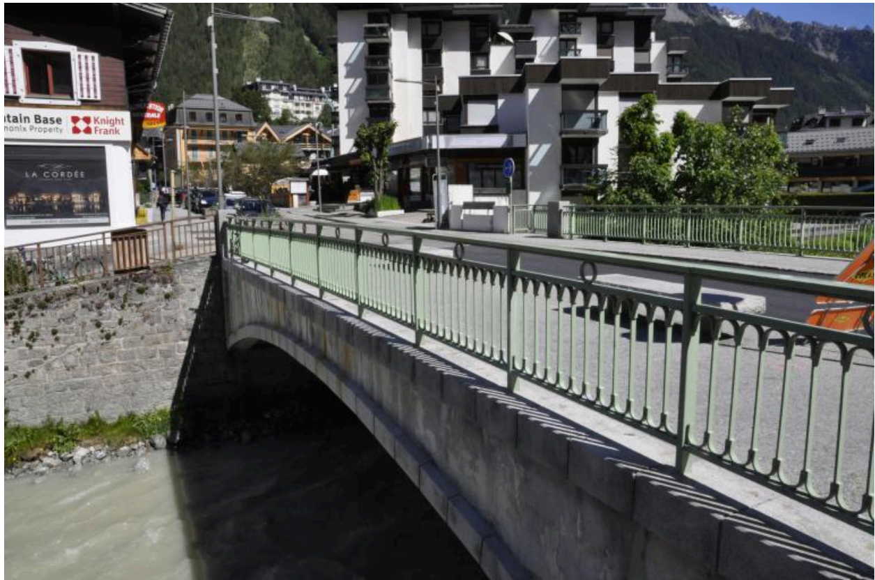
Vue de la face amont du pont
