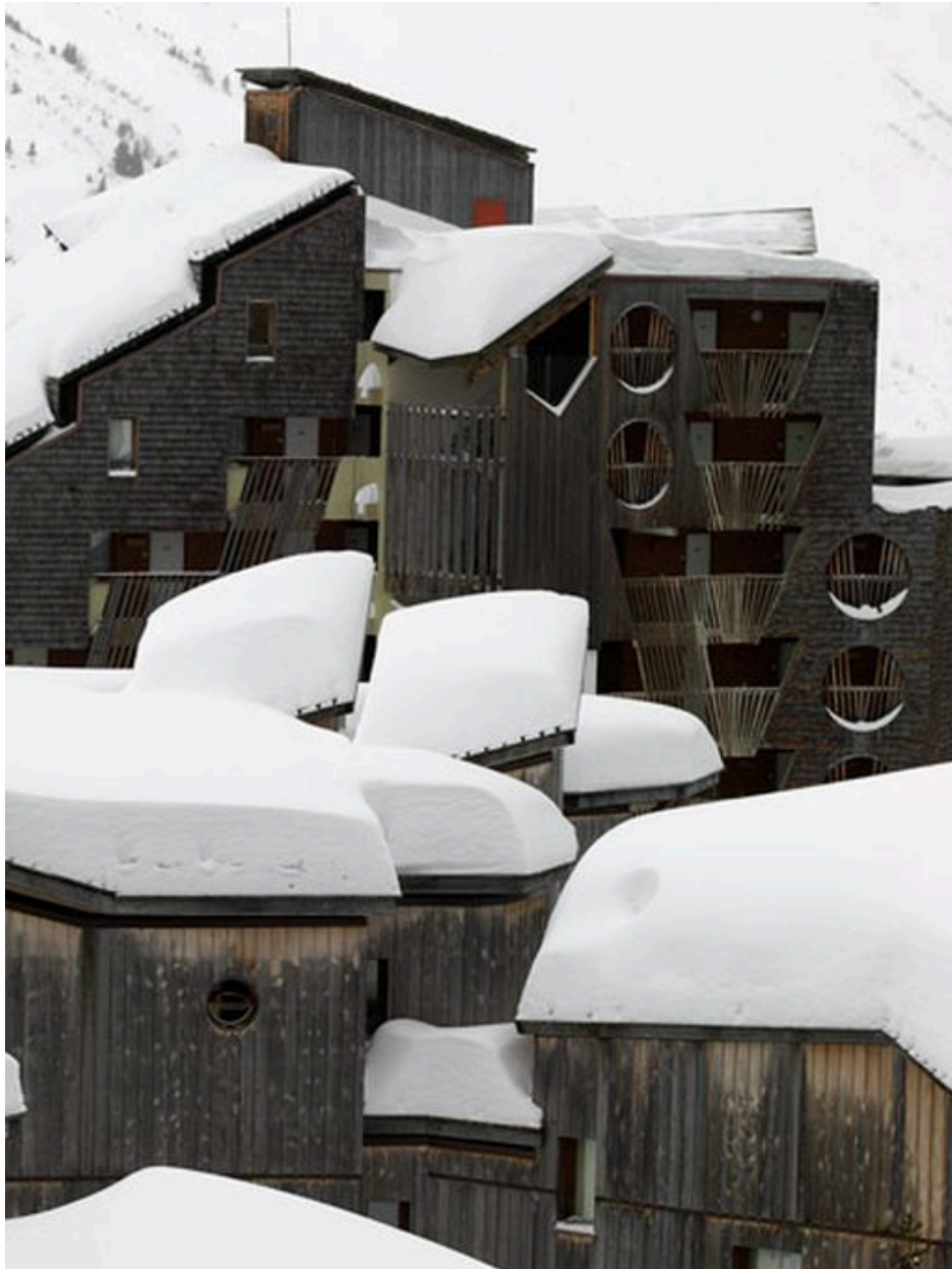
La station sous la neige
