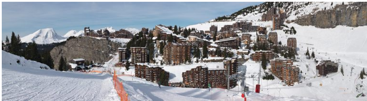
La station vue depuis le sud
