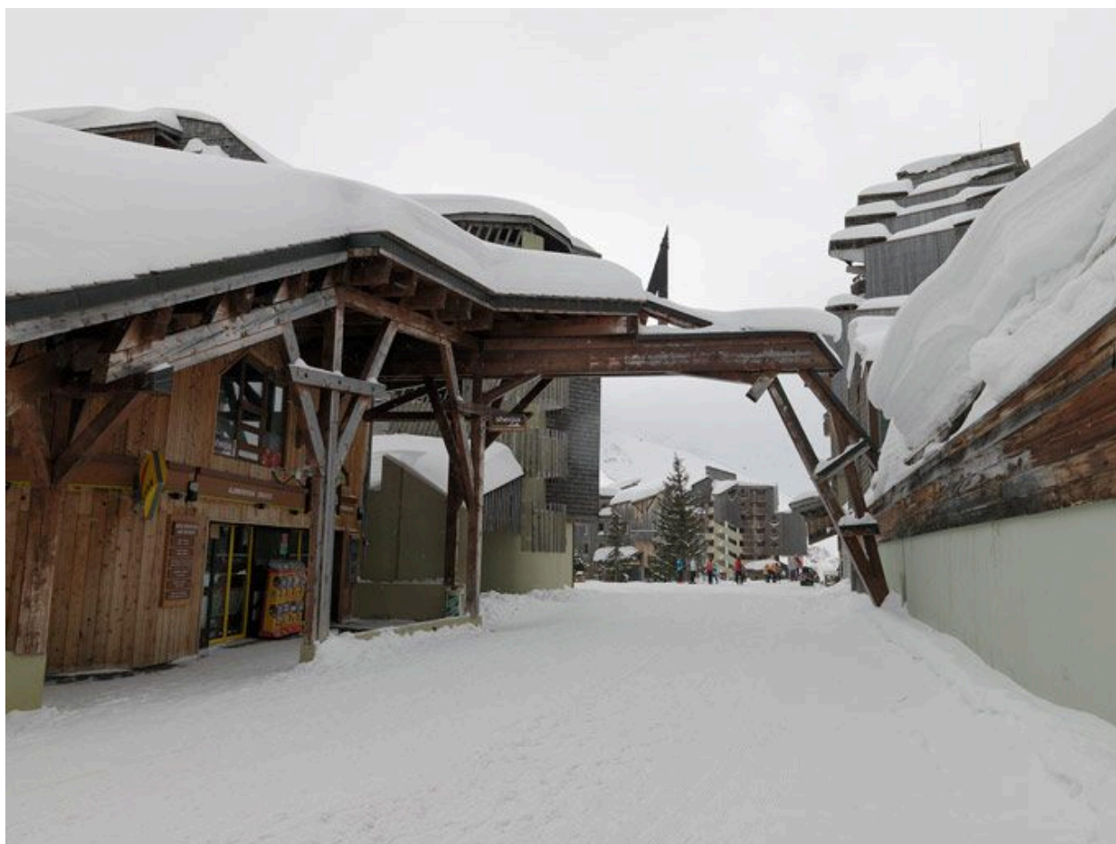
La station sous la neige
