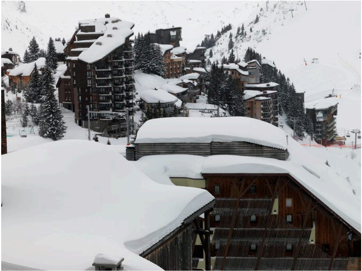
La station sous la neige
