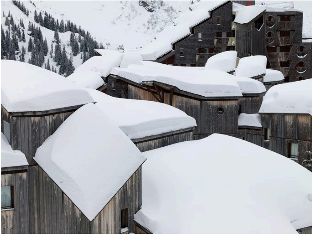
La station sous la neige
