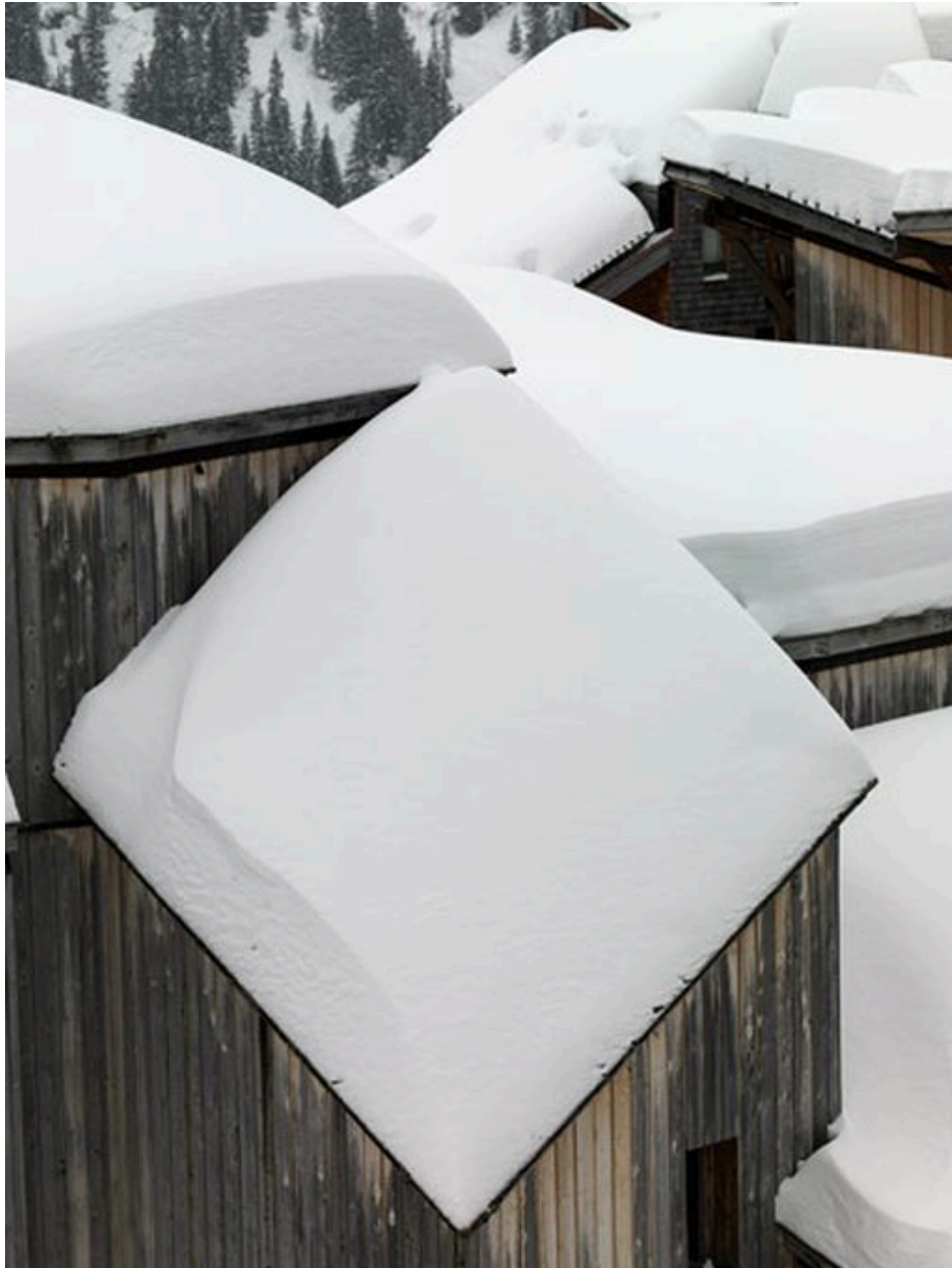
La station sous la neige
