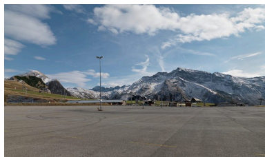
Le parc de stationnement nord Phot. Eric Dessert IVR82_20097400463NUCA
