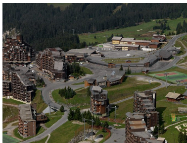
Entrée de la station : parcs de stationnement, quais de déchargement, accueil Phot. Eric Dessert IVR82_20097400619NUCA
