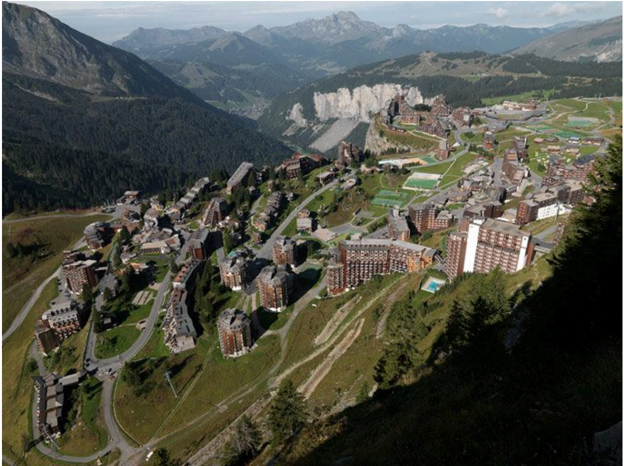
La station depuis le sud
