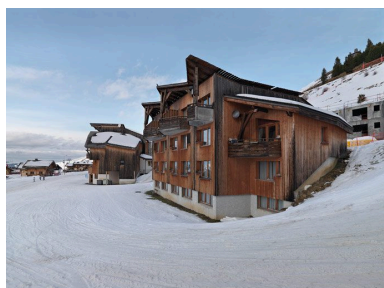
Le nouvel Avoriaz. Logements de saisonniers Phot. Eric Dessert IVR82_20107403411NUCA
