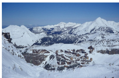
Hiver 2000-2001, vue d'ensemble de la station Phot. Jean-François Lyon- Caen, Phot. C. Salomon-Pelen IVR82_20087400867NUCA
