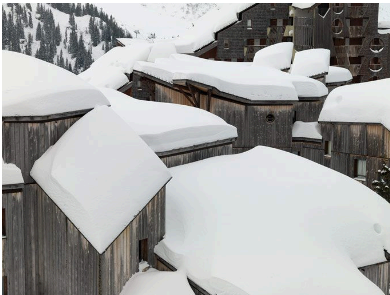
La station sous la neige
