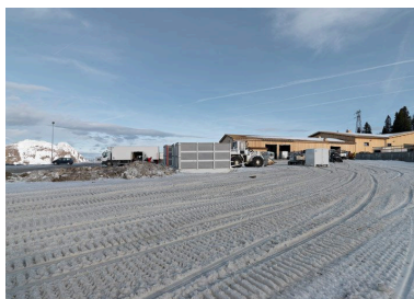
Containers et entrepôts Phot. Eric Dessert IVR82_20107401999NUCA
