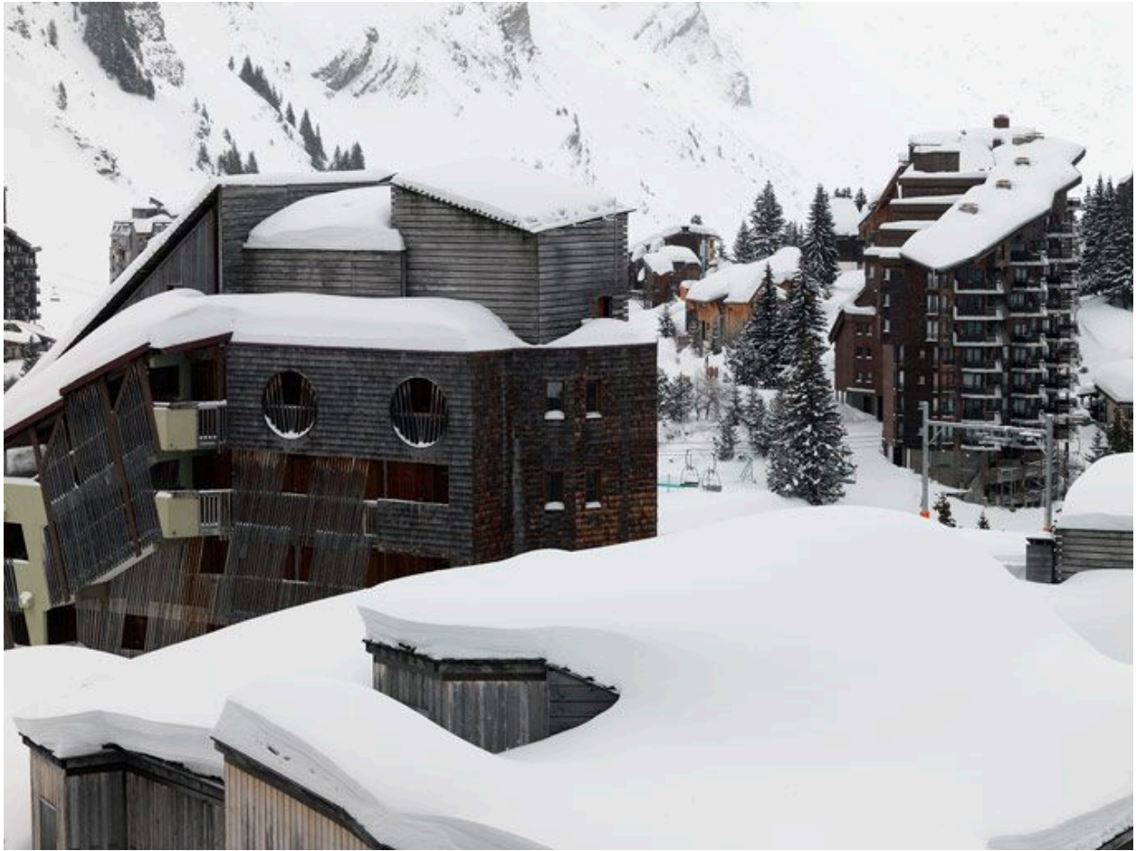
La station sous la neige
