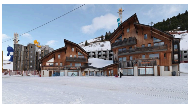
Le nouvel Avoriaz. Logements de saisonniers Phot. Eric Dessert IVR82_20107403413NUCA
