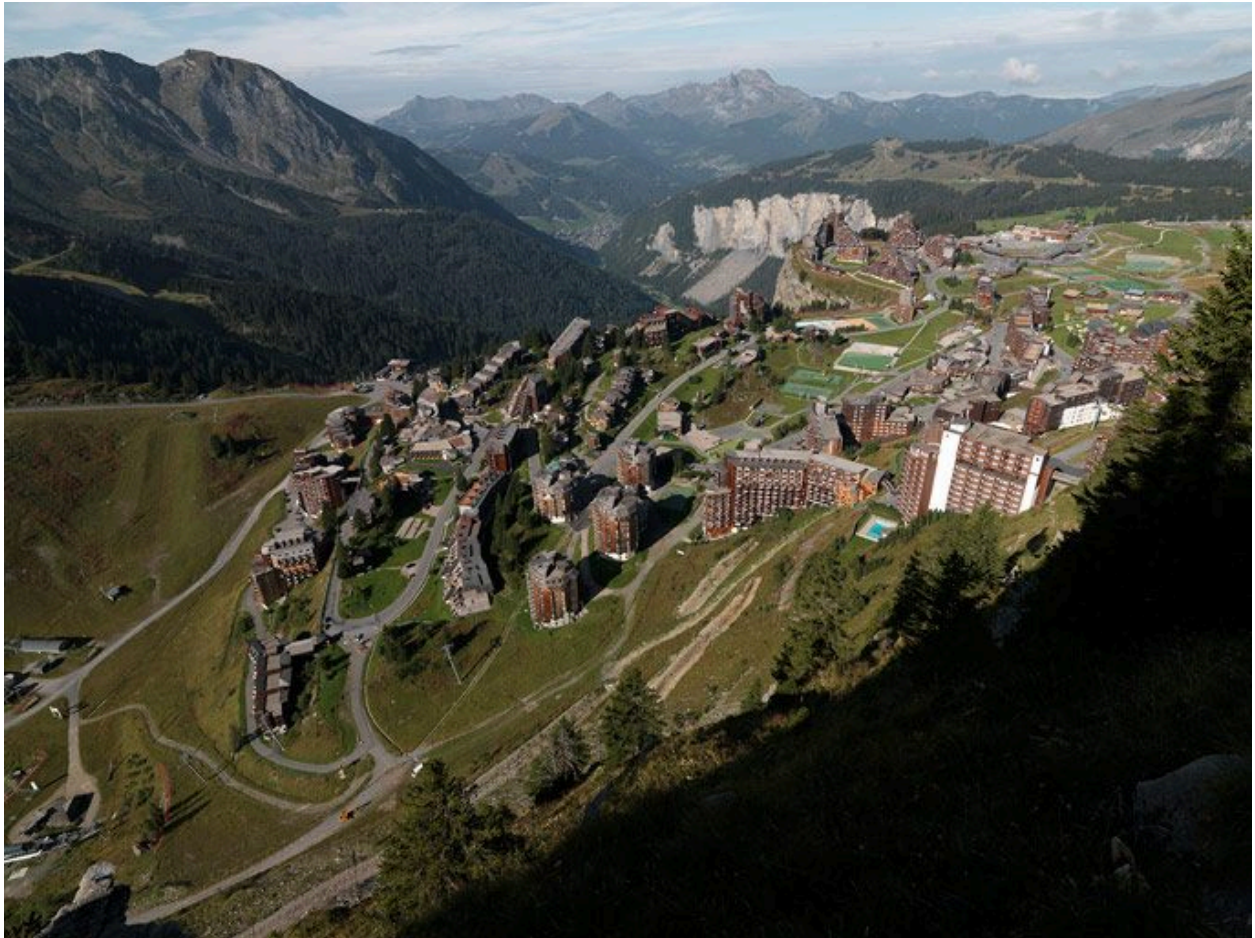
La station depuis le sud
