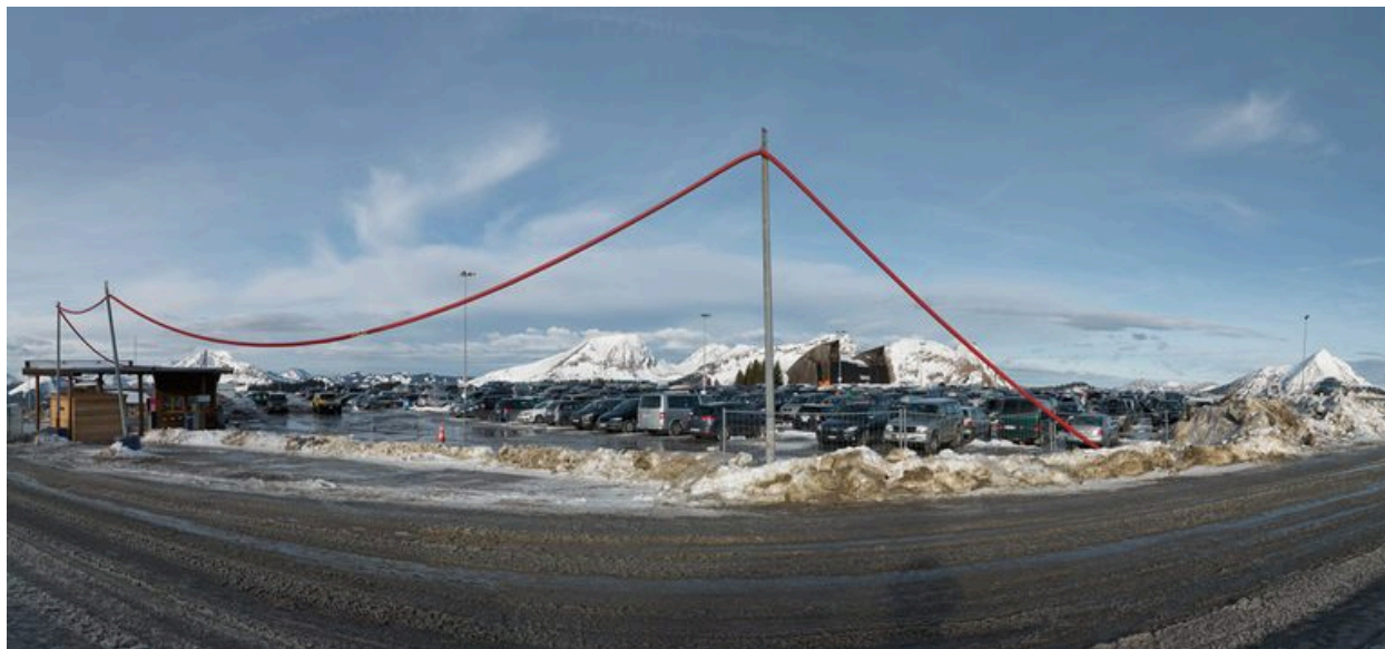
Parc de stationnement
