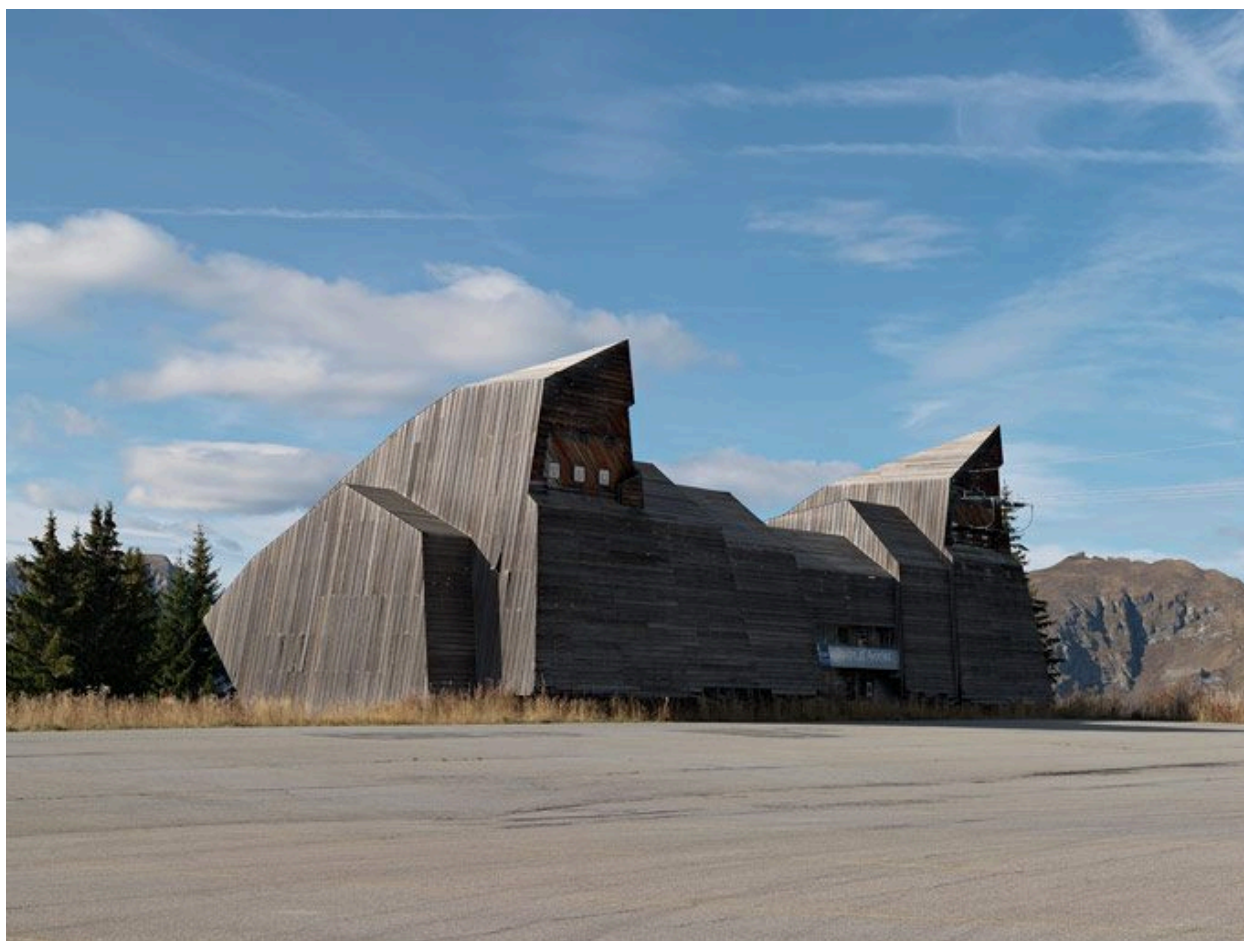
La centrale électrique, architectes Daniel Vibert et Xavier Chambre. Elévation est sur le parc de stationnement
