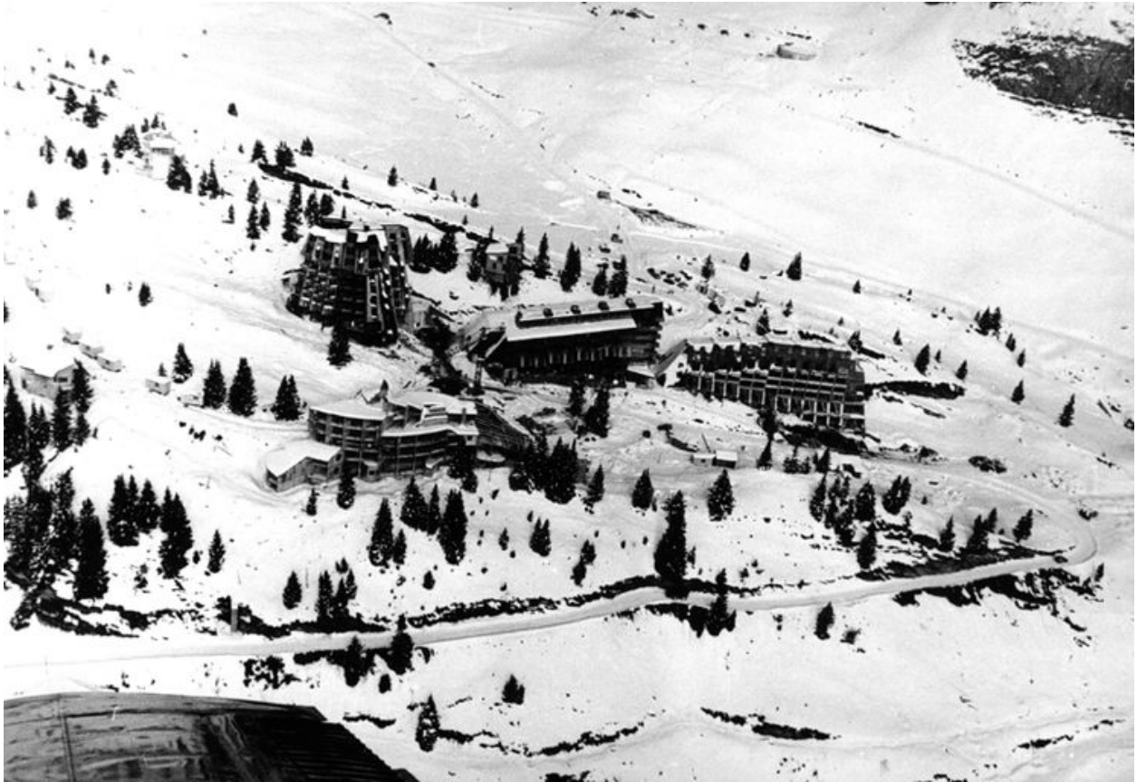
Hiver 1967-1968, chantier des Mélèzes I et de l'hôtel des Hauts-Forts
