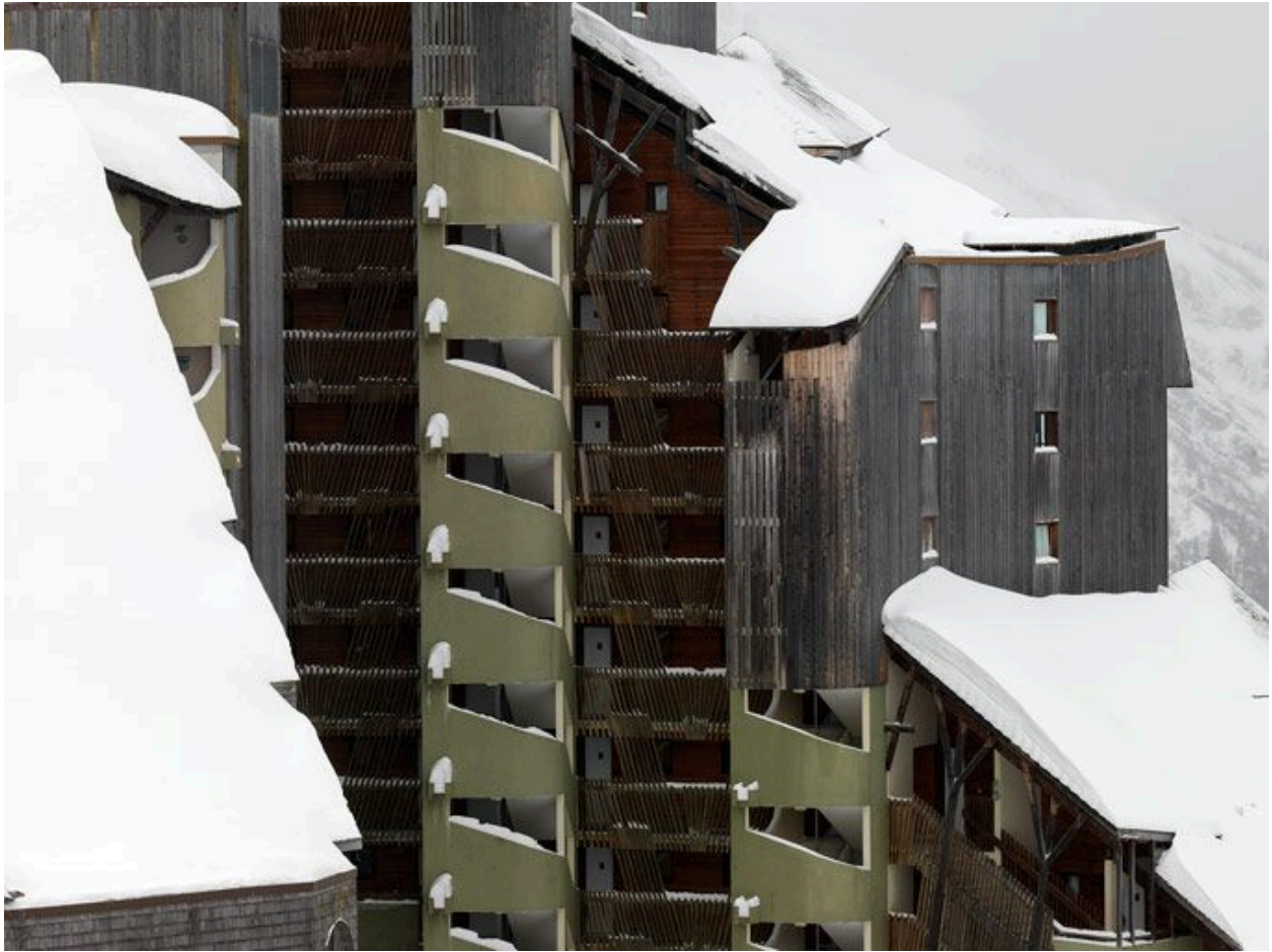
La station sous la neige
