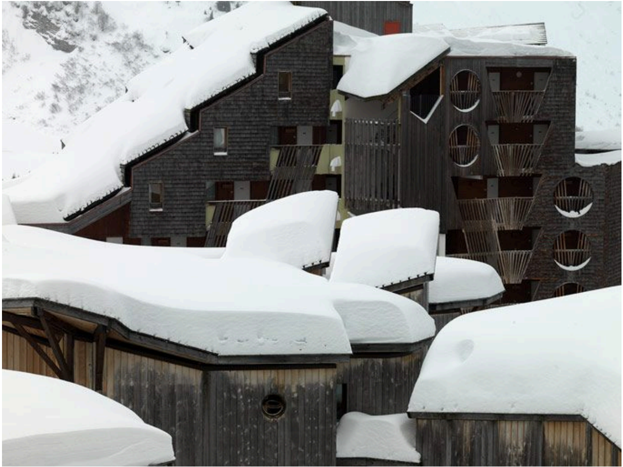
La station sous la neige
