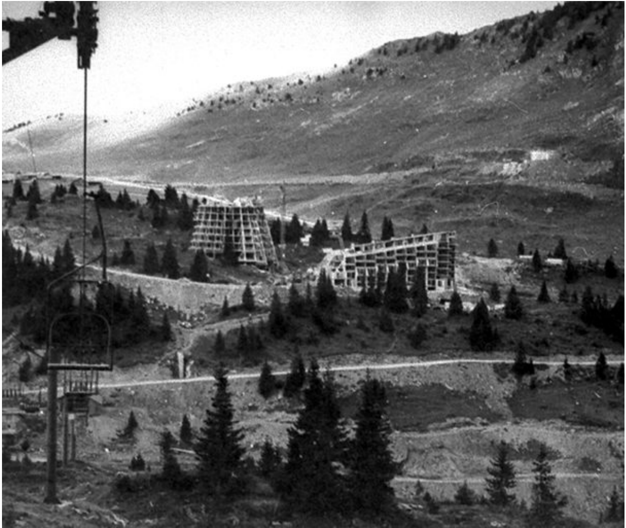
Été 1966, chantier de l'hôtel des Dromonts et du Séquoïa
