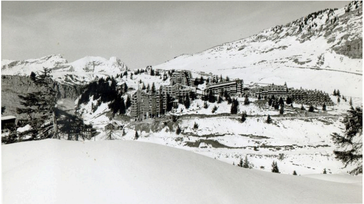
Hiver 1968-1969, chantier de la résidence des Hauts-Forts et des Mélèzes II
