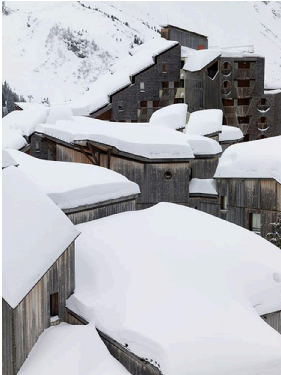
La station sous la neige
