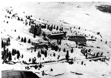
Hiver 1967-1968, chantier des Mélèzes I et de l'hôtel des Hauts-Forts Phot. Jean-François Lyon- Caen, Phot. C. Salomon-Pelen IVR82_20087400854NUCB
