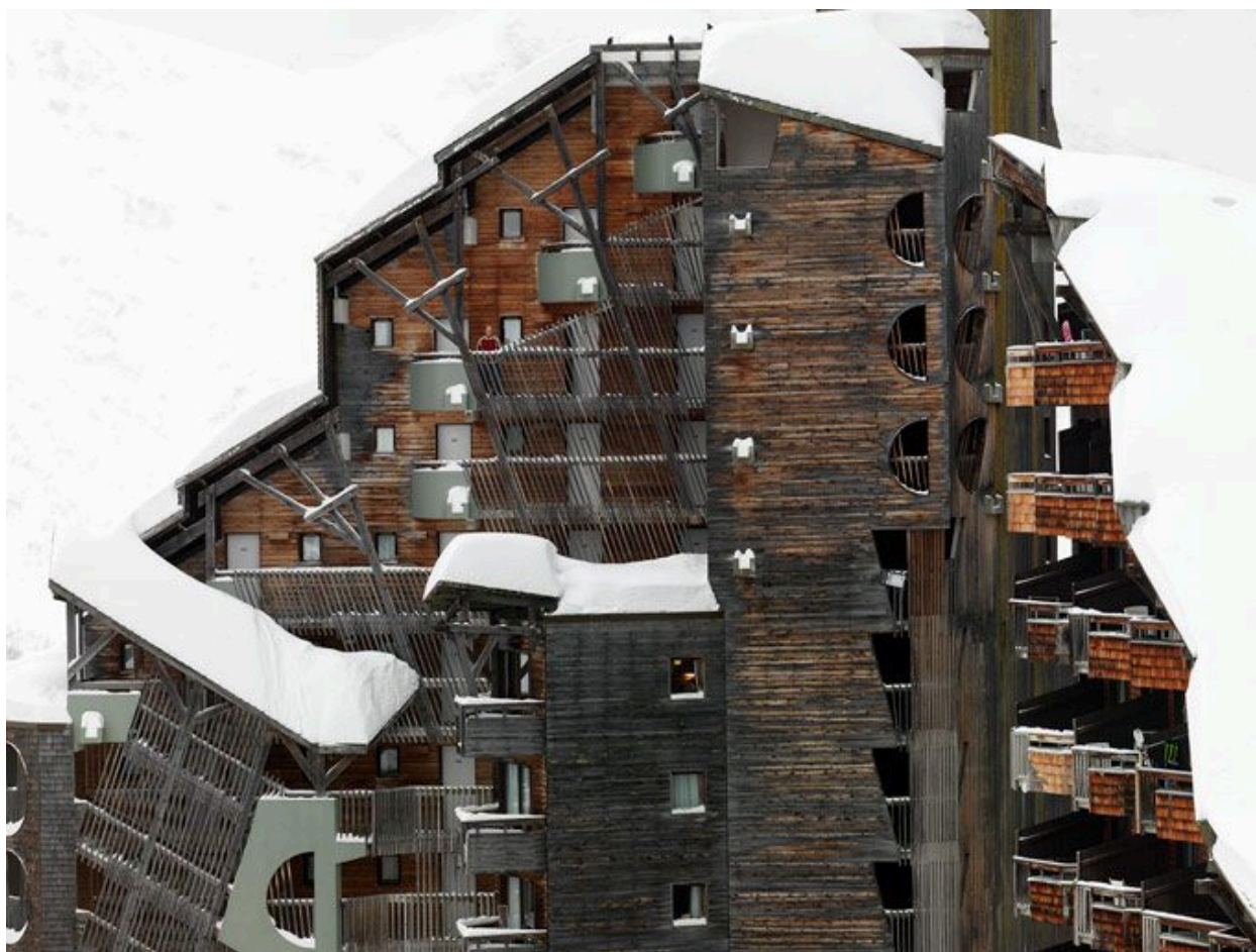
La station sous la neige
