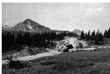
Chantier de la route depuis les chalets d'alpage vers le col d'Avoriaz, 1958-1961 Phot. Jean-François Lyon- Caen, Phot. C. Salomon-Pelen IVR82_20087400847NUCB
