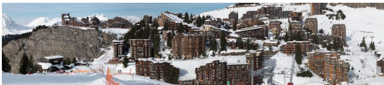
Vue d'ensemble de la station depuis le sud
