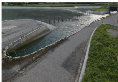
Raccordement du canal de fuite au bassin d'amortissement, et vanne de réglage du débit d'alerte
