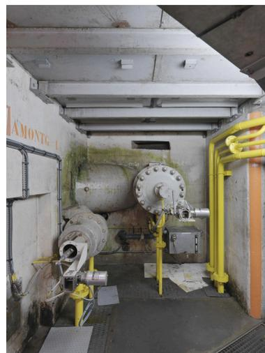
Etage de la turbine, détail des vérins actionnant les injecteurs et les déflecteurs
