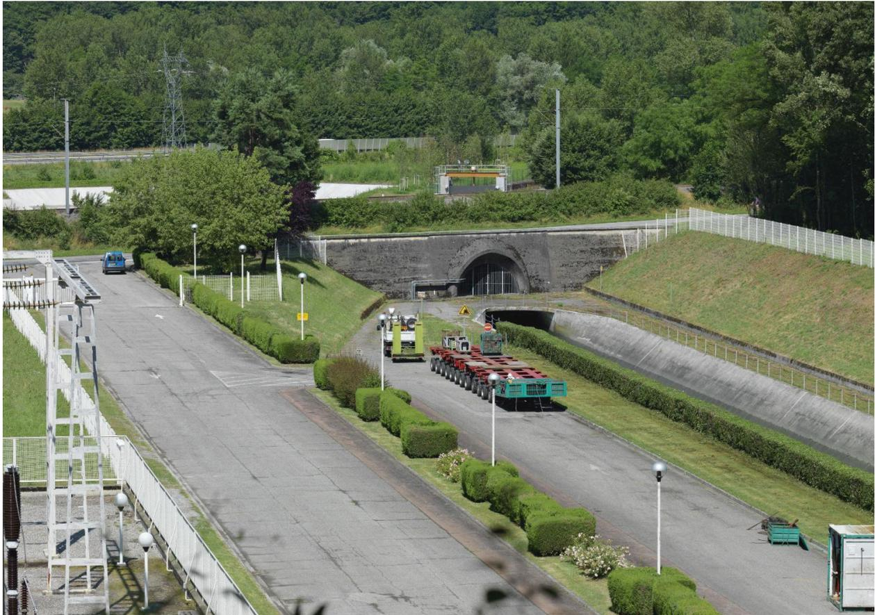
Canal de fuite et passage souterrain sous la RD et la voie ferrée
