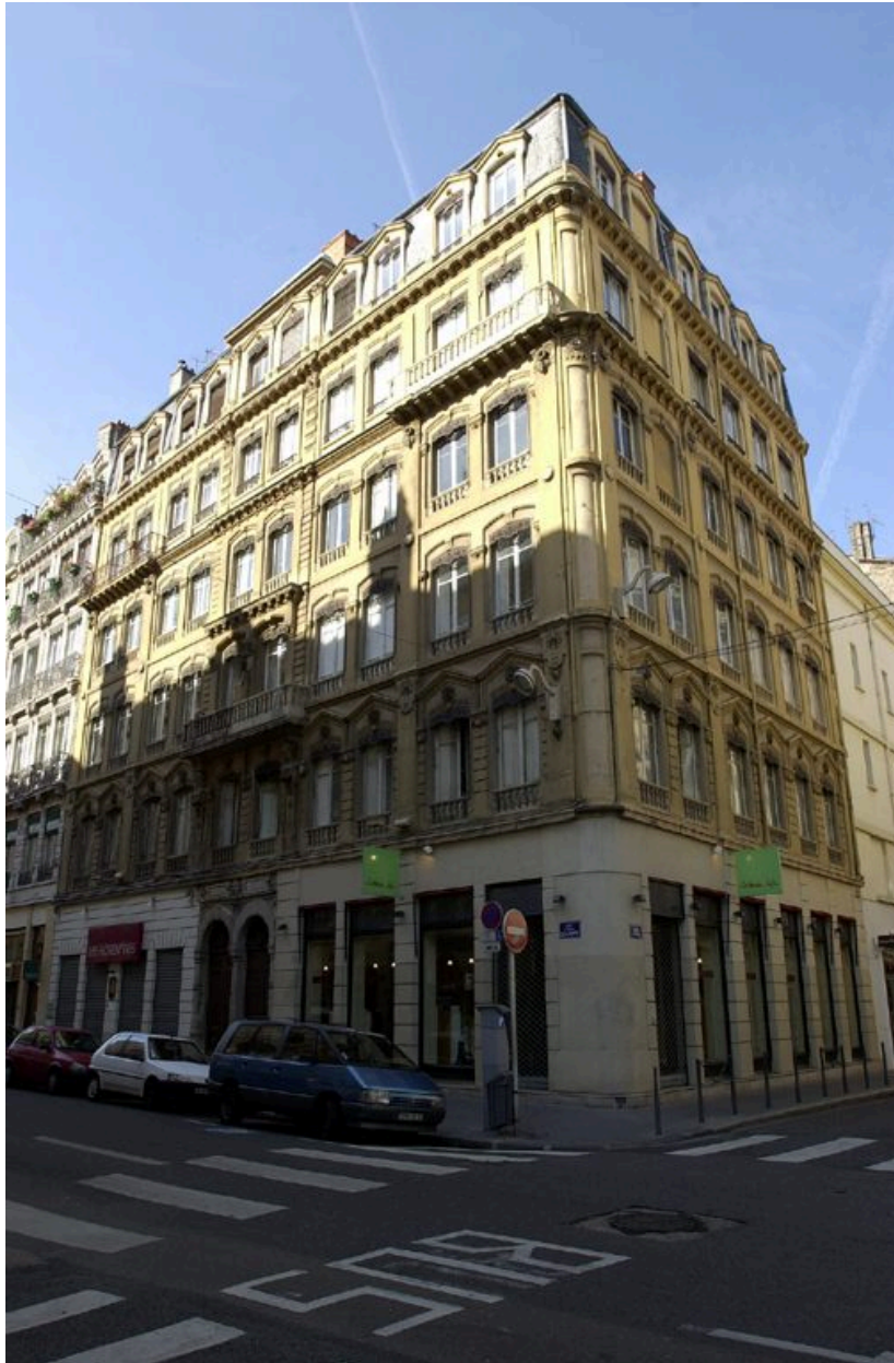
Vue de situation (2e immeuble à partir de la droite)
