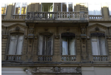
Elévation antérieure, premier étage carré : les travées centrales Phot. Bernard Ducouret IVR82_20046905304NUCA
