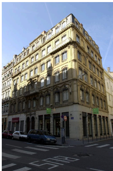
Vue de situation (2e immeuble à partir de la droite) Phot. Bernard Ducouret IVR82_20046905300NUCA
