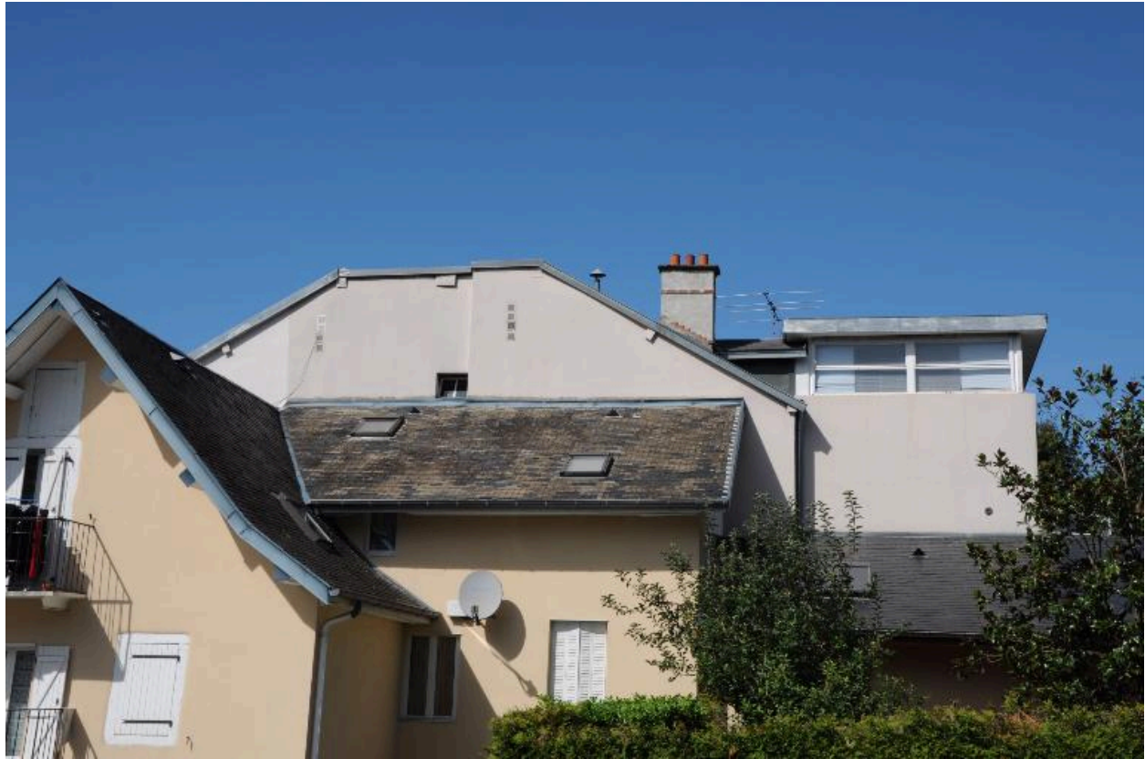
Vue depuis l'arrière
