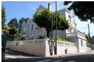
Vue d'ensemble depuis la rue Phot. Denys Harreau IVR82_20137300992NUCA
