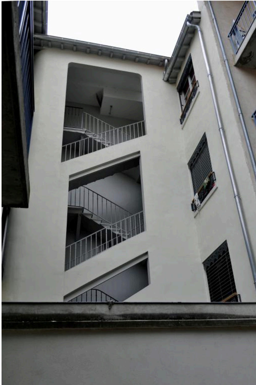
Escalier hors oeuvre reliant les bâtiments, mur de cage ajouré
