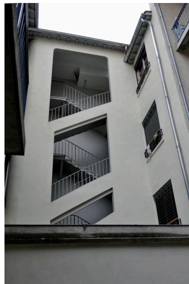
Escalier hors oeuvre reliant les bâtiments, mur de cage ajouré Phot. Magali Delavenne IVR84_20186900894NUCA
