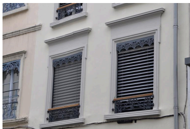
Elévation sur rue, détail du premier étage Phot. Magali Delavenne IVR84_20186900895NUCA
