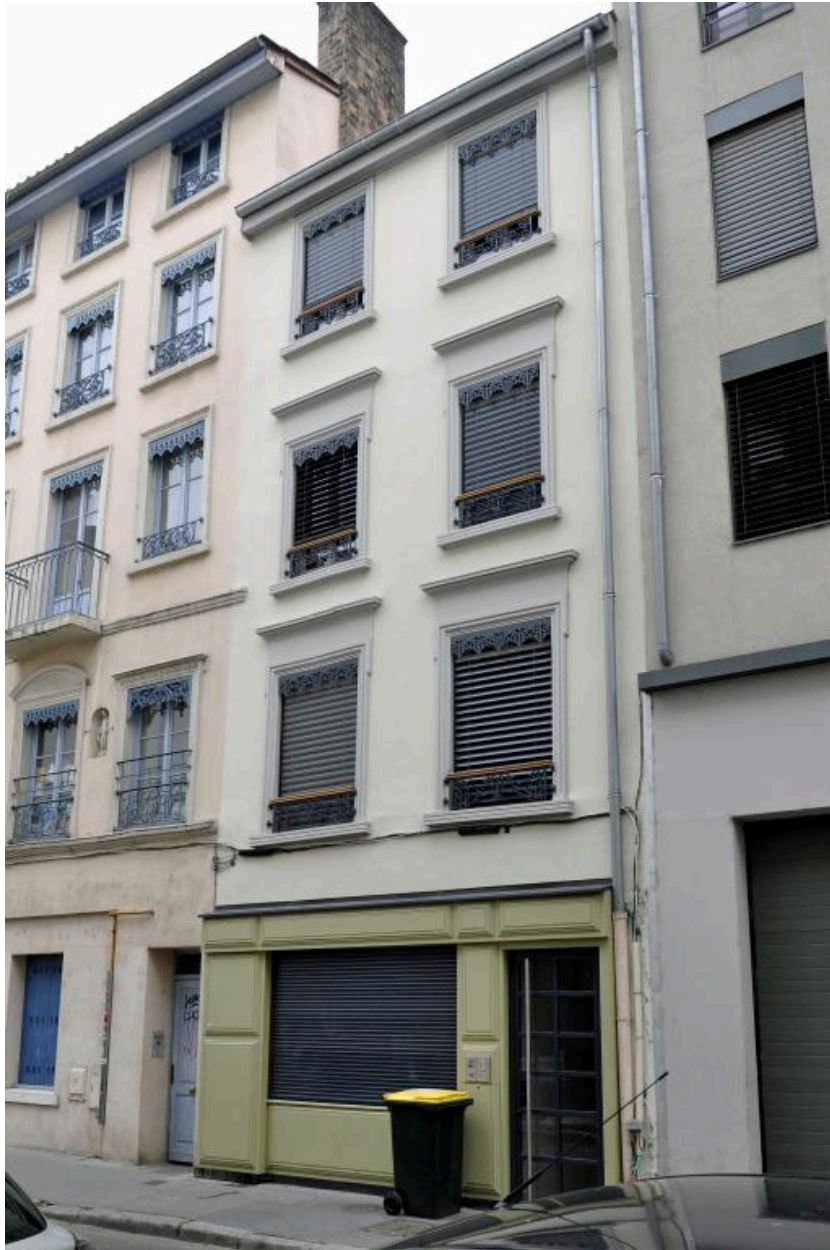
Immeuble sur rue, vue générale
