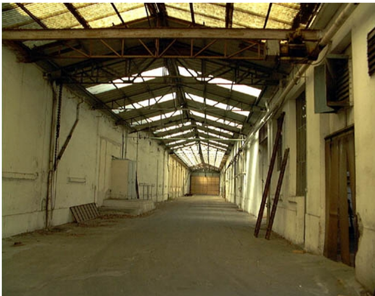
Vue du passage couvert nord-sud
