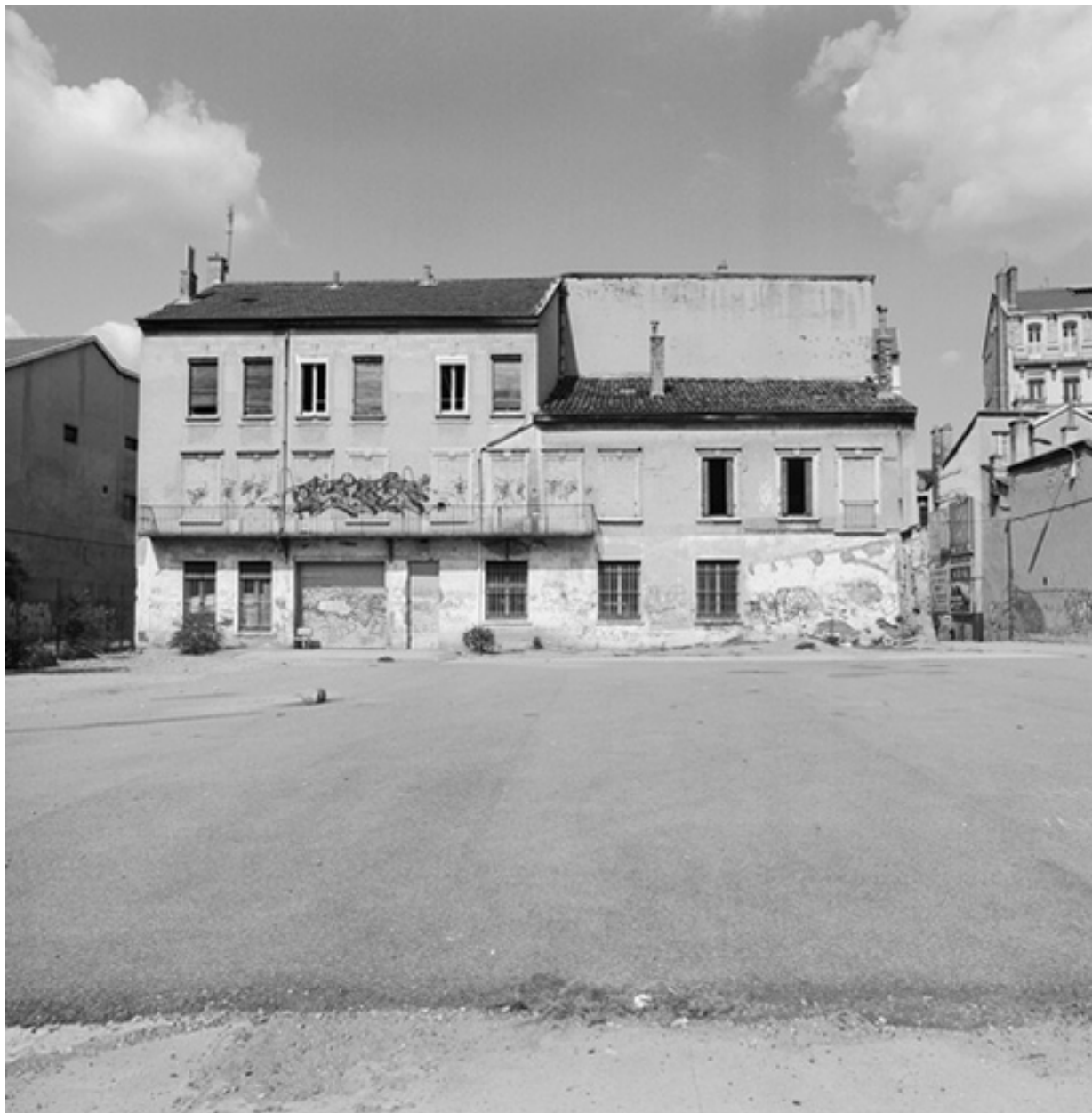
Vue arrière, sud
