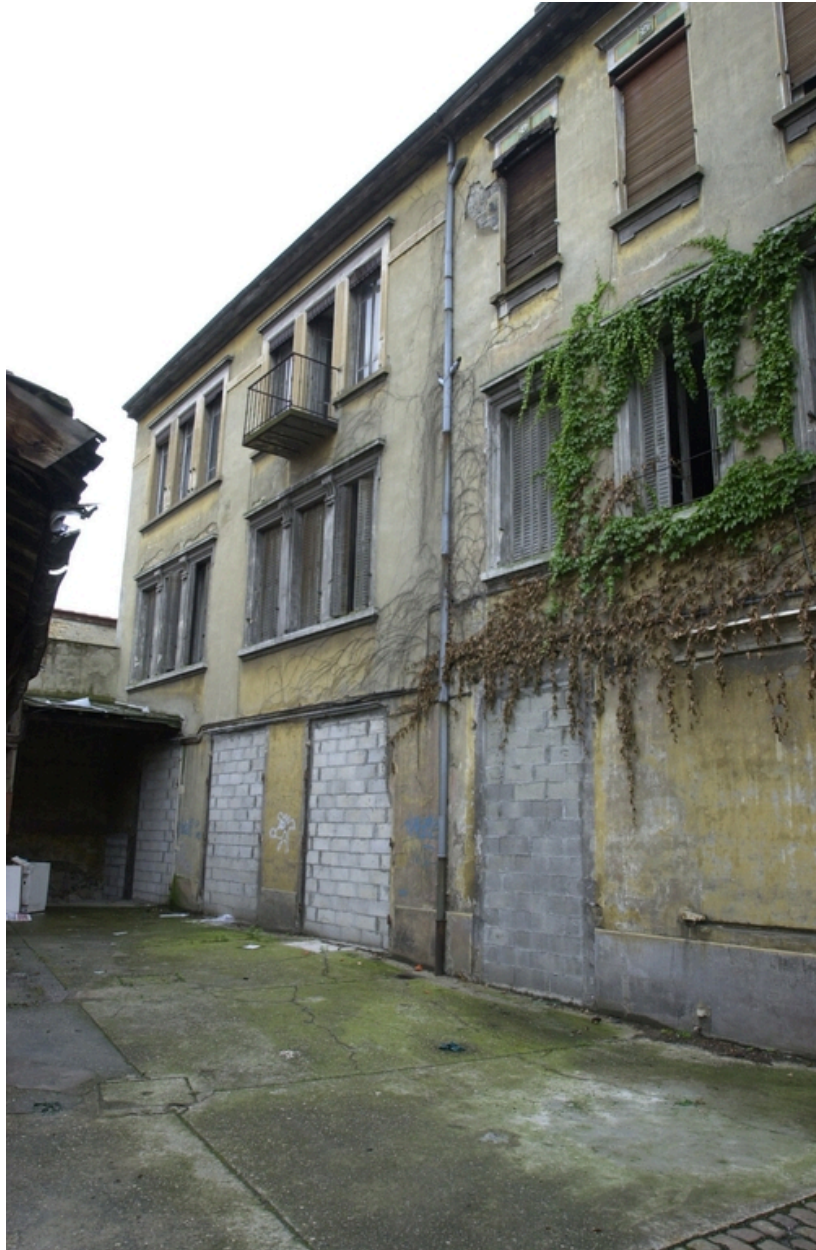
Vue de la façade du corps de bâtiment en fond de cour
