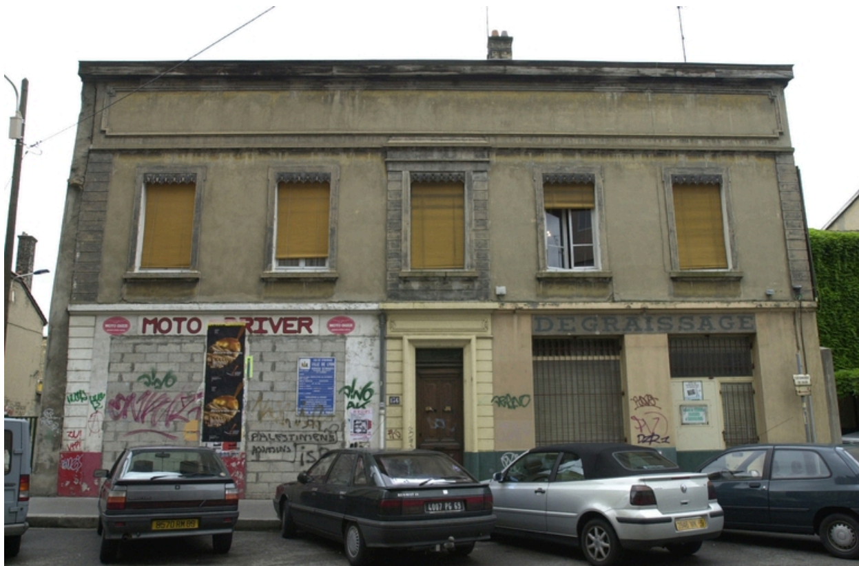
Vue du corps de bâtiment donnant sur la rue
