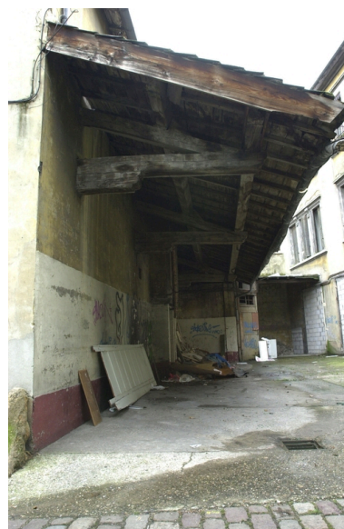
Vue de l'appenti de la cour Phot. François Blanchetière IVR82_20016901570NUCA
