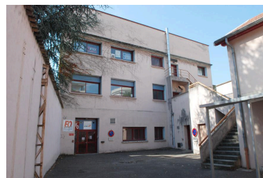
Vue sur cour des bâtiments administratifs Phot. Nadine Halitim-Dubois IVR82_20116900385NUCA
