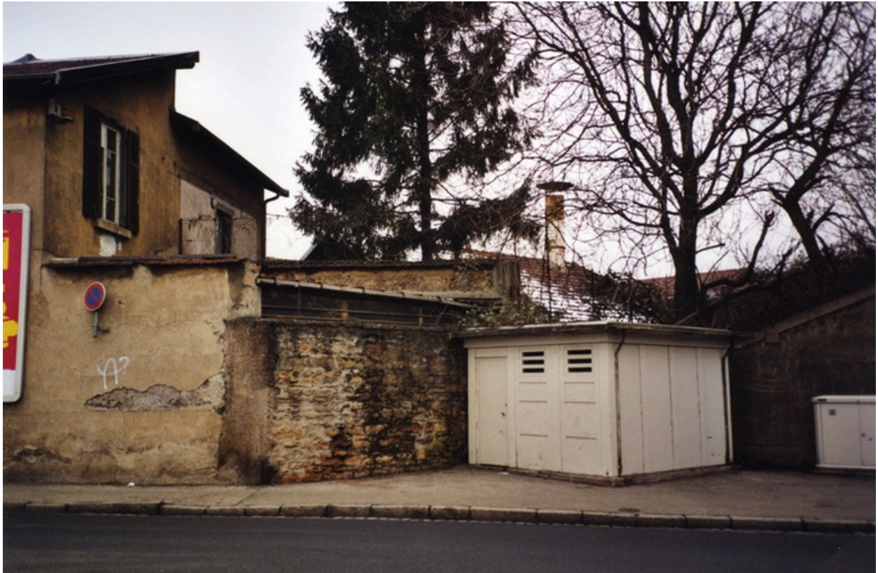
Détail cheminée métallique
