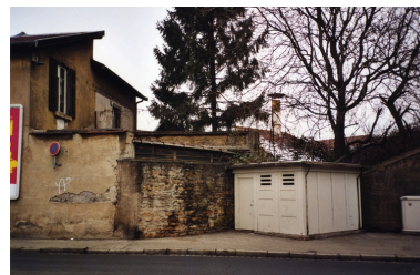
Détail cheminée métallique Phot. Nadine Halitim-Dubois IVR82_20066900170NUCA
