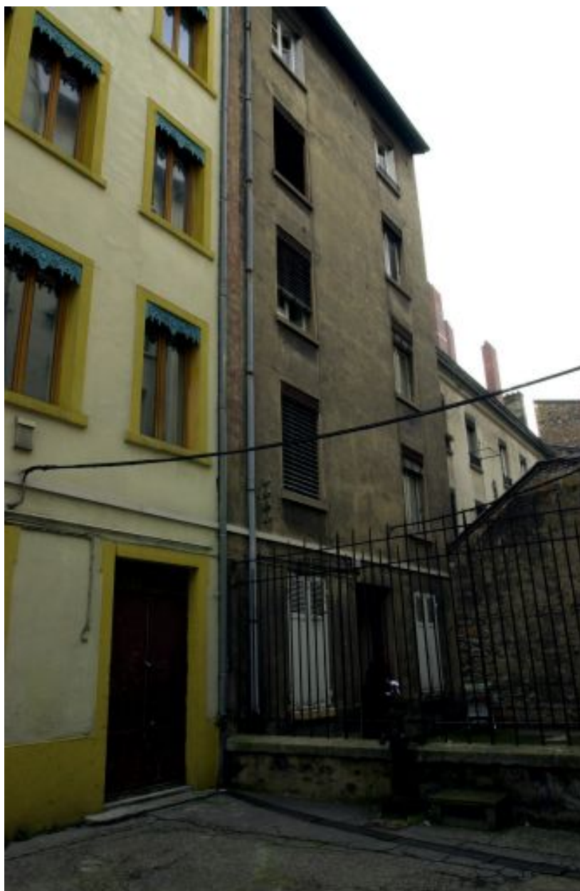
Vue de l'immeuble en fond de cour
