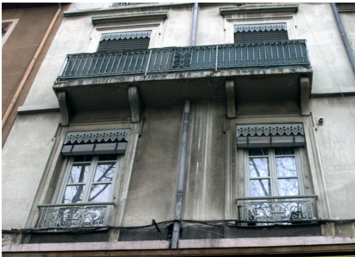
Détail des baies de l'élévation principale
