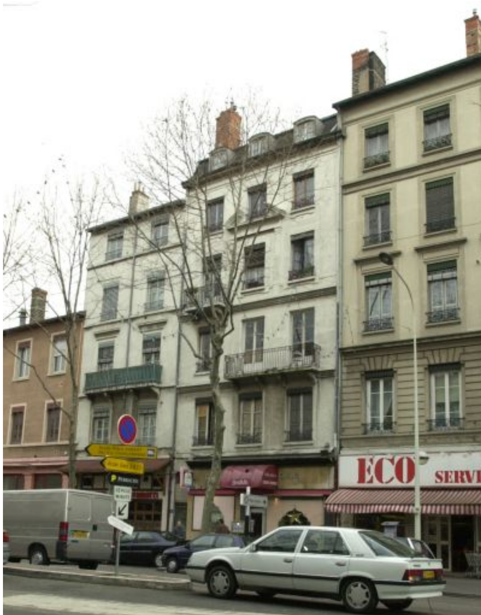
Elévation principale depuis le sud
