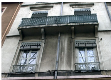
Détail des baies de l'élévation principale Phot. Maryannick Chalabi IVR82_20016901280NUCA
