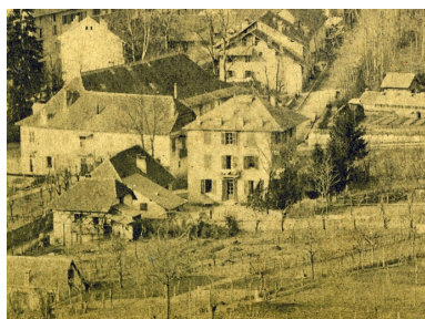
Vue prise du sud Repro. François Fouger IVR82_20097300991NUCB
