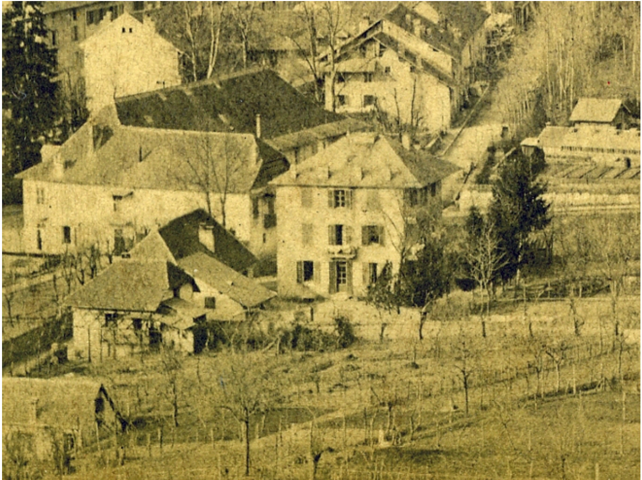
Vue prise du sud
