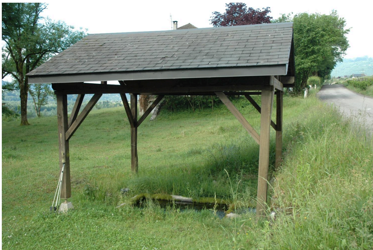
Vue de la fontaine (bassin, abreuvoir, lavoir couvert) de la Perrouse (2018 ZE 145), repérée.
