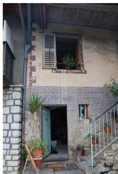
La Saussa, ferme isolée (2018 YH 240). Détail de l'enduit peint. Phot. Jérôme Daviet IVR84_20247301240NUCA
