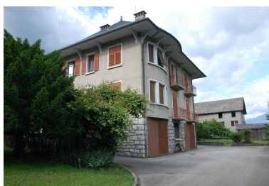
Derrière Chez Rosset (2018 YA 167). Scierie Pajean. Maison d'habitation. Phot. Caroline Guibaud IVR84_20247300711NUCA
