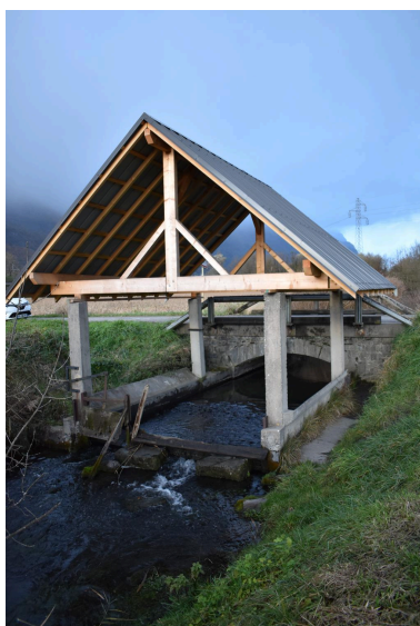
Vue du lavoir couvert de Pau (la Pépinière, 2018 ZM non cadastré), repéré. Phot. Caroline Guibaud IVR84_20247301760NUCA
