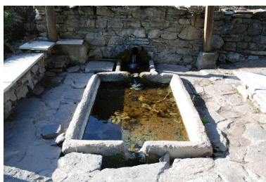
Vue de la fontaine (bassin, abreuvoir, lavoir couvert) de la Perrouse (2018 ZE 145), repérée. Etat en 2022. Phot. Thierry Monnet IVR84_20247301329NUCA
