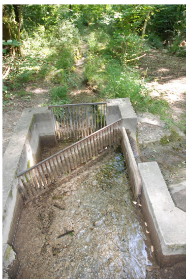
Bief du Gargot au sud des Jolis Coeurs. Phot. Caroline Guibaud IVR84_20247300998NUCA
