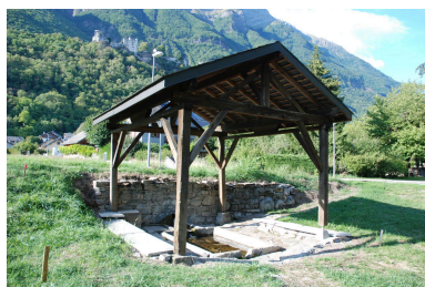
Vue de la fontaine (bassin, abreuvoir, lavoir couvert) de la Perrouse (2018 ZE 145), repérée. Etat en 2022. Phot. Thierry Monnet IVR84_20247301328NUCA
