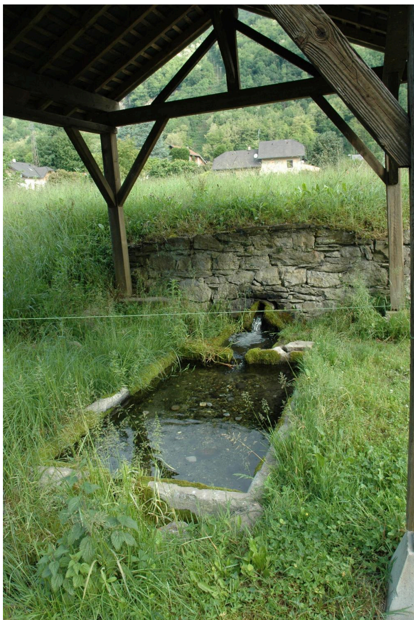
Vue de la fontaine (bassin, abreuvoir, lavoir couvert) de la Perrouse (2018 ZE 145), repérée.
