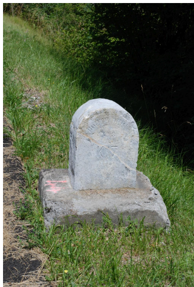
Plan Ravet, borne de la Route départementale n°8, K. 7 (vers 2018 F 449). Phot. Thierry Monnet IVR84_20247301270NUCA
