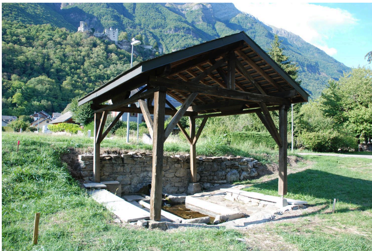
Vue de la fontaine (bassin, abreuvoir, lavoir couvert) de la Perrouse (2018 ZE 145), repérée. Etat en 2022.
