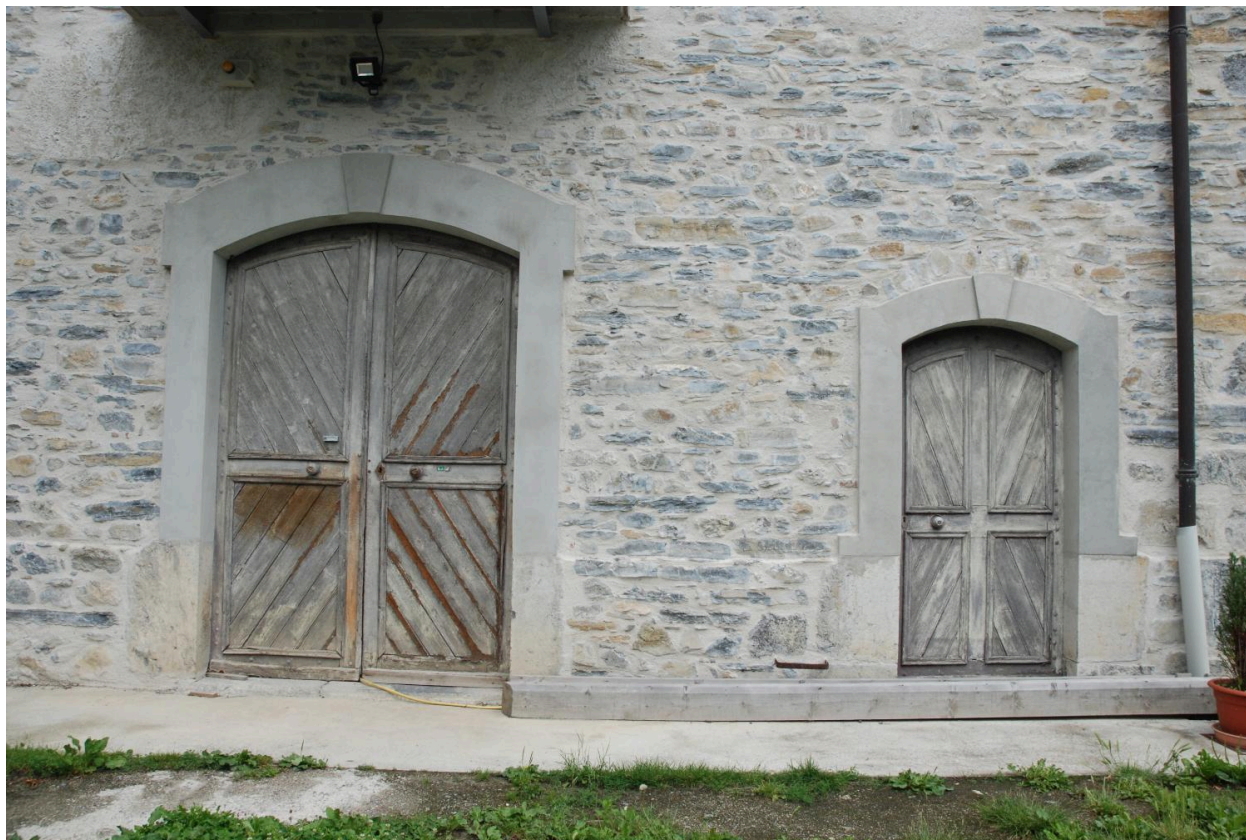
Pré Charroud (2018 YA 117), domaine viticole. Vue des portes (à droite, vers l'escalier ; à gauche, cuvage ?)
