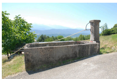
Roissarvaz (ou Boissarvaz), vue de la fontaine (bassin, abreuvoir) de (2018 YD 79), repérée. Phot. Thierry Monnet IVR84_20247300874NUCA
