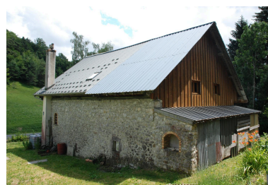
Le Col du Frêne, ferme à juxtaposition (2018 G 175, 176). Vue arrière. Phot. Thierry Monnet IVR84_20247301267NUCA
