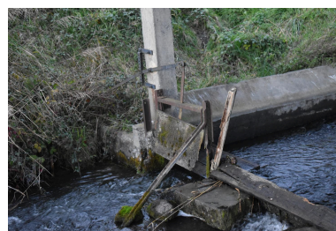
Vue du lavoir couvert de Pau (la Pépinière, 2018 ZM non cadastré), repéré. Détail de la vanne. Phot. Caroline Guibaud IVR84_20247301761NUCA
