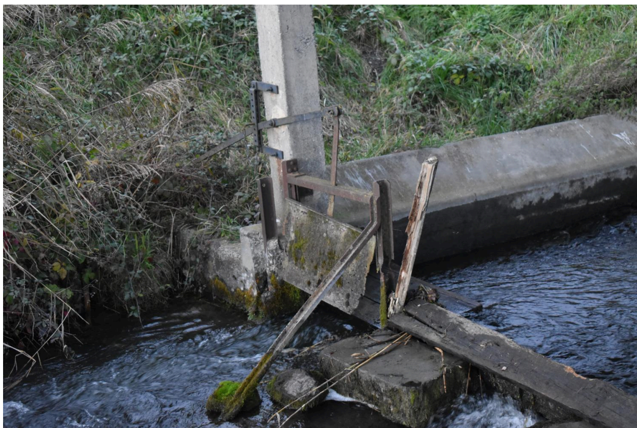
Vue du lavoir couvert de Pau (la Pépinière, 2018 ZM non cadastré), repéré. Détail de la vanne.
