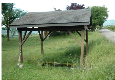
Vue de la fontaine (bassin, abreuvoir, lavoir couvert) de la Perrouse (2018 ZE 145), repérée. Phot. Caroline Guibaud IVR84_20247300217NUCA
