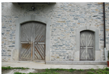
Pré Charroud (2018 YA 117), domaine viticole. Vue des portes (à droite, vers l'escalier ; à gauche, cuvage ?) Phot. Caroline Guibaud IVR84_20247300607NUCA
