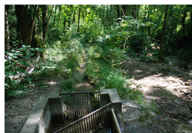
Bief du Gargot au sud des Jolis Coeurs. Phot. Caroline Guibaud IVR84_20247300999NUCA
