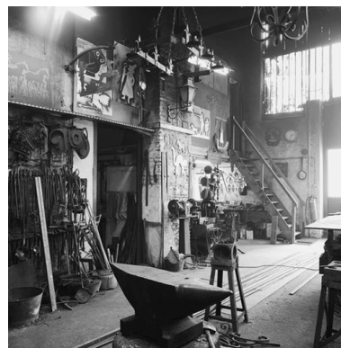
Vue intérieure de la forge vers l'entrée Phot. Eric Dessert IVR82_20006900230X
