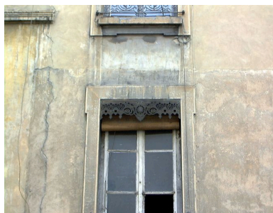
Immeuble adressé 72 rue Chaponnay : détail d'un lambrequin Phot. Véronique Belle IVR82_20006900498NUCA
