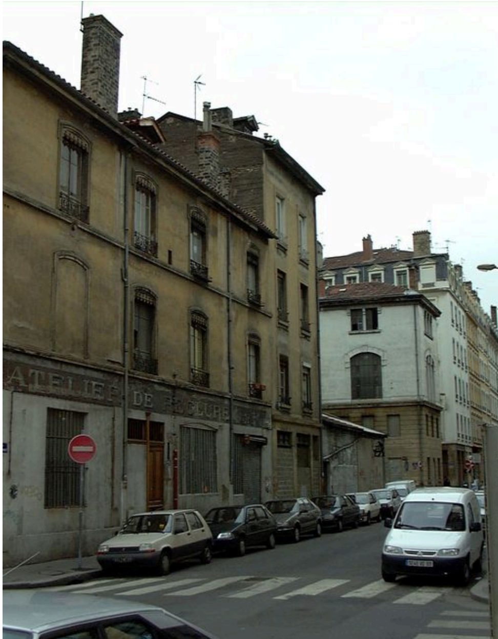
Vue de situation de l'immeuble adressé 72 rue Chaponnay
