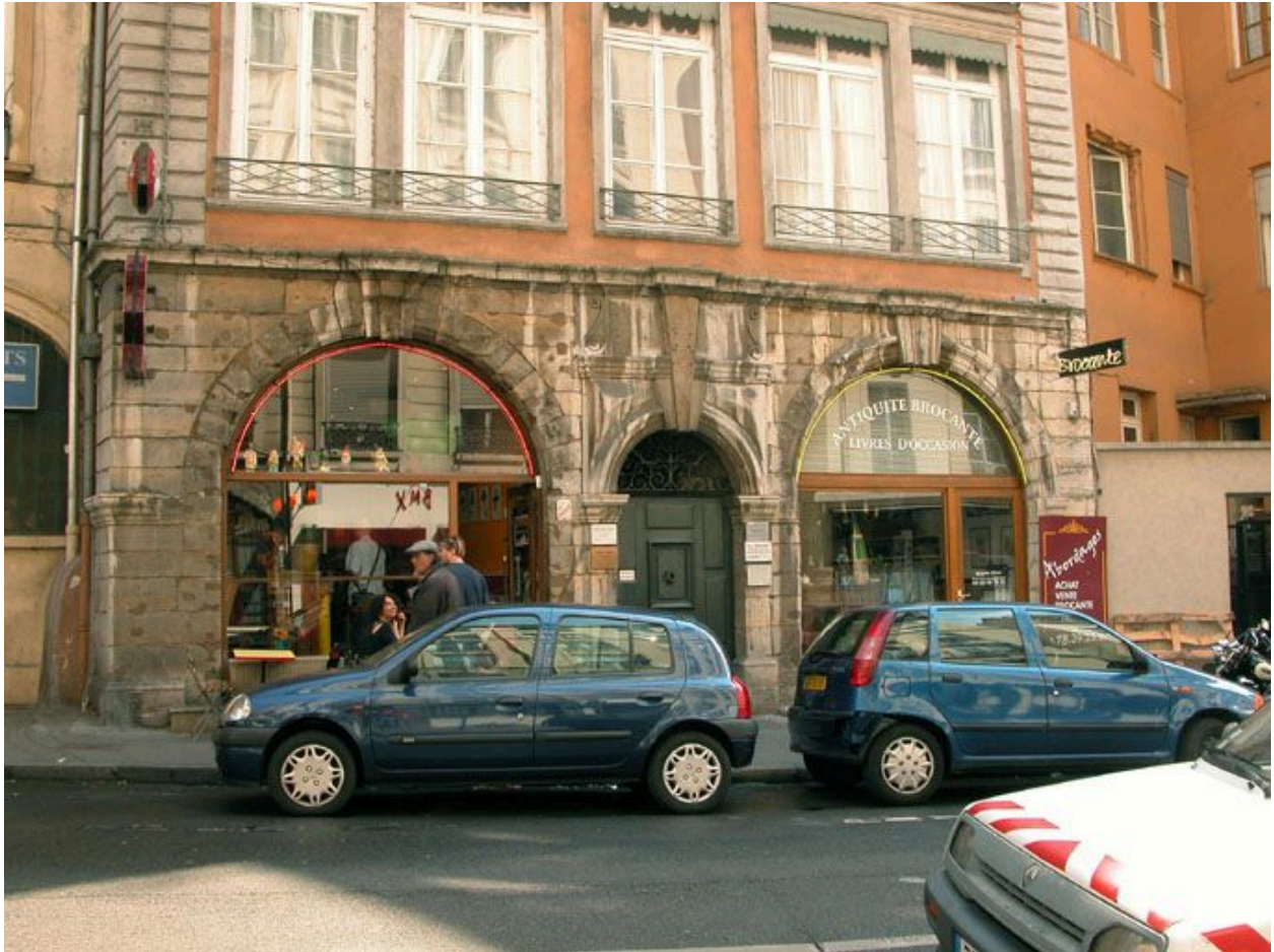
Façade sur rue, rez-de-chaussée
