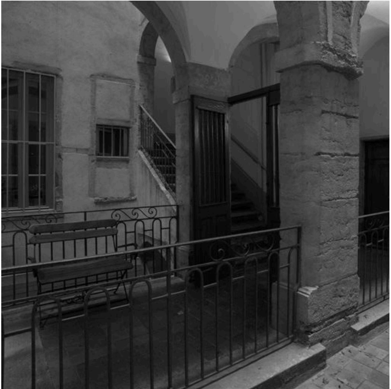
1ère cour et escalier vus depuis la 2e cour, à hauteur du 1er étage
