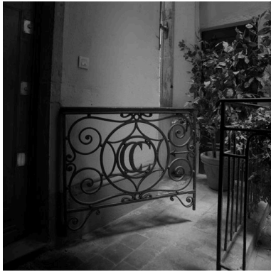
Galerie du 1er étage, portillon du 18e siècle en emploi Phot. Eric Dessert IVR82_20046905867NUC
