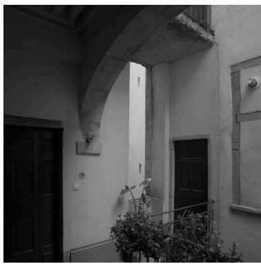
3e étage, vue de la coursière conduisant aux anciennes latrines Phot. Eric Dessert IVR82_20046905861NUC
