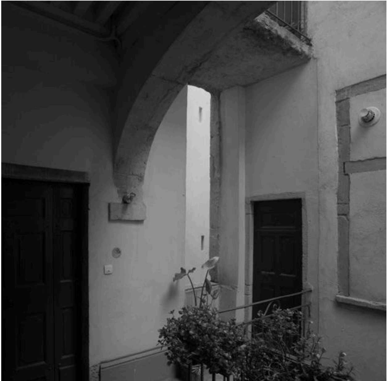
3e étage, vue de la coursière conduisant aux anciennes latrines
