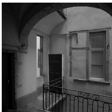
2e cour, coursière conduisant aux anciens lieux d'aisance, vue à hauteur du 2e étage Phot. Eric Dessert IVR82_20046905865NUC
