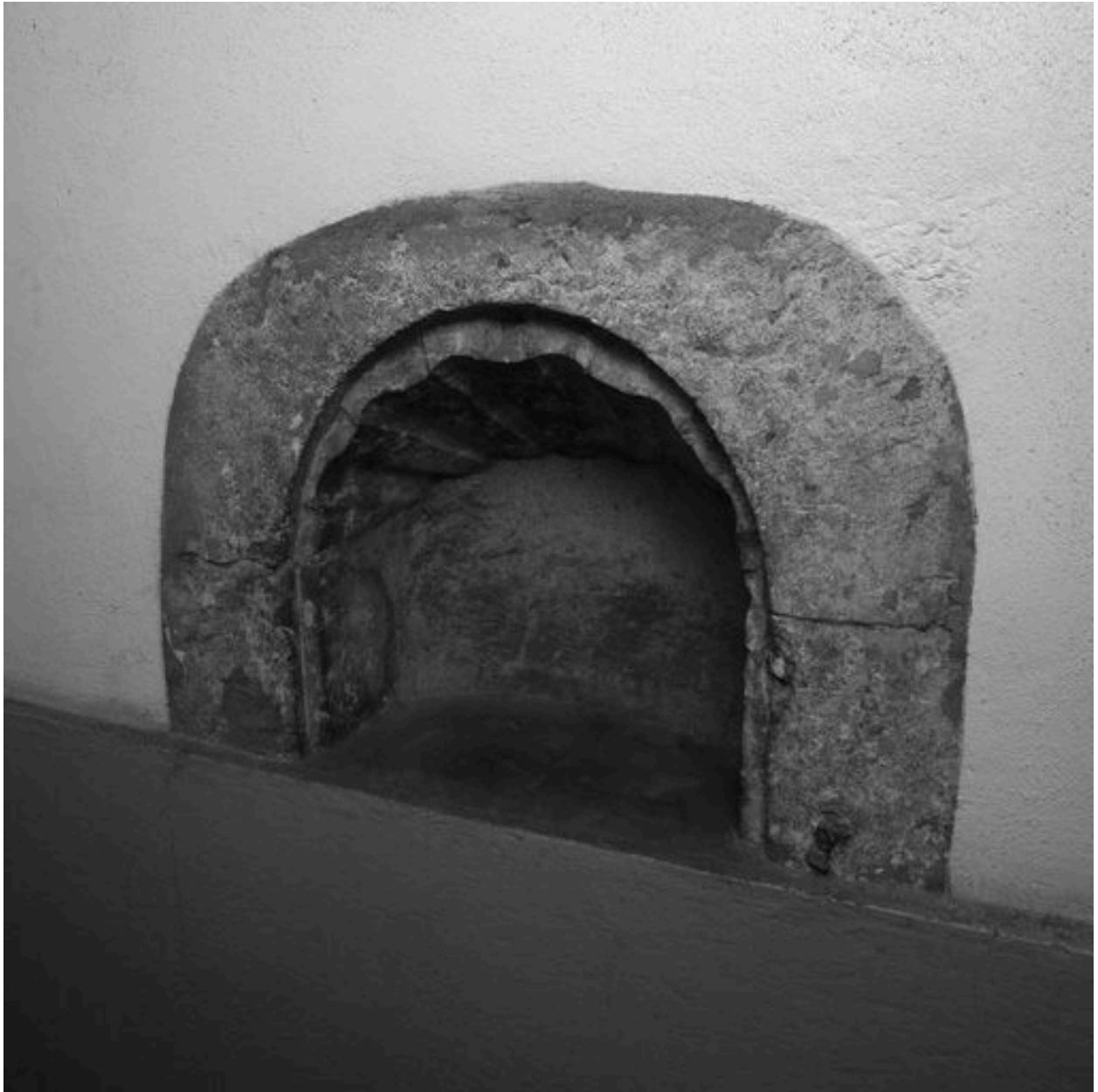
Allée, vestige de l'ancienne niche du puits
