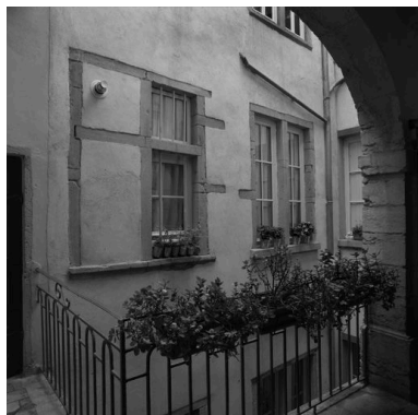
2e cour, élévation du 3e étage étage de l'aile ouest Phot. Eric Dessert IVR82_20046905860NUC
