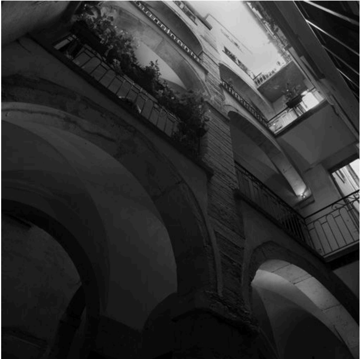
2e cour, élévations des galeries et coursières
