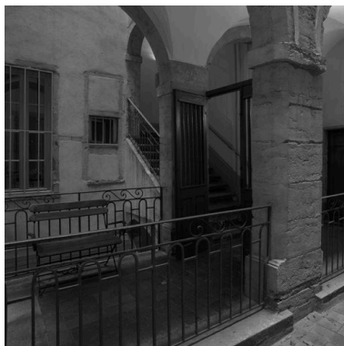
1ère cour et escalier vus depuis la 2e cour, à hauteur du 1er étage Phot. Eric Dessert IVR82_20046905869NUC
