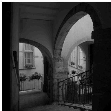
Galerie entre les cours 1 et 2, vue depuis le repos du 3e étage de l'escalier Phot. Eric Dessert IVR82_20046905862NUC
