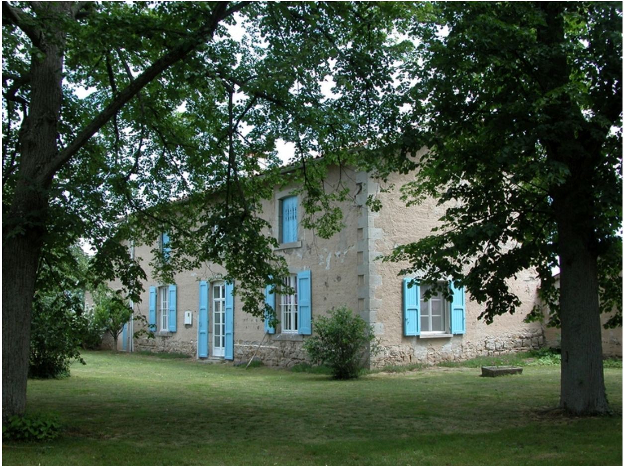
Vue d'ensemble du logis depuis le sud-ouest.
