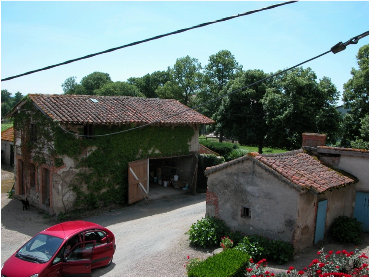
Vue d'ensemble de la cour depuis l'escalier du logis, à l'est : logement d'ouvriers agricoles et remise, fournil.
