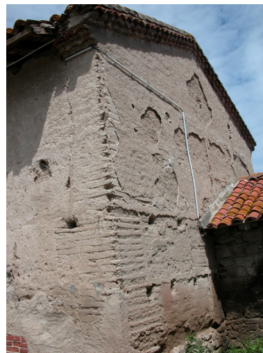
Détail de pisé. Phot. Thierry Monnet IVR82_20134201870NUCA
