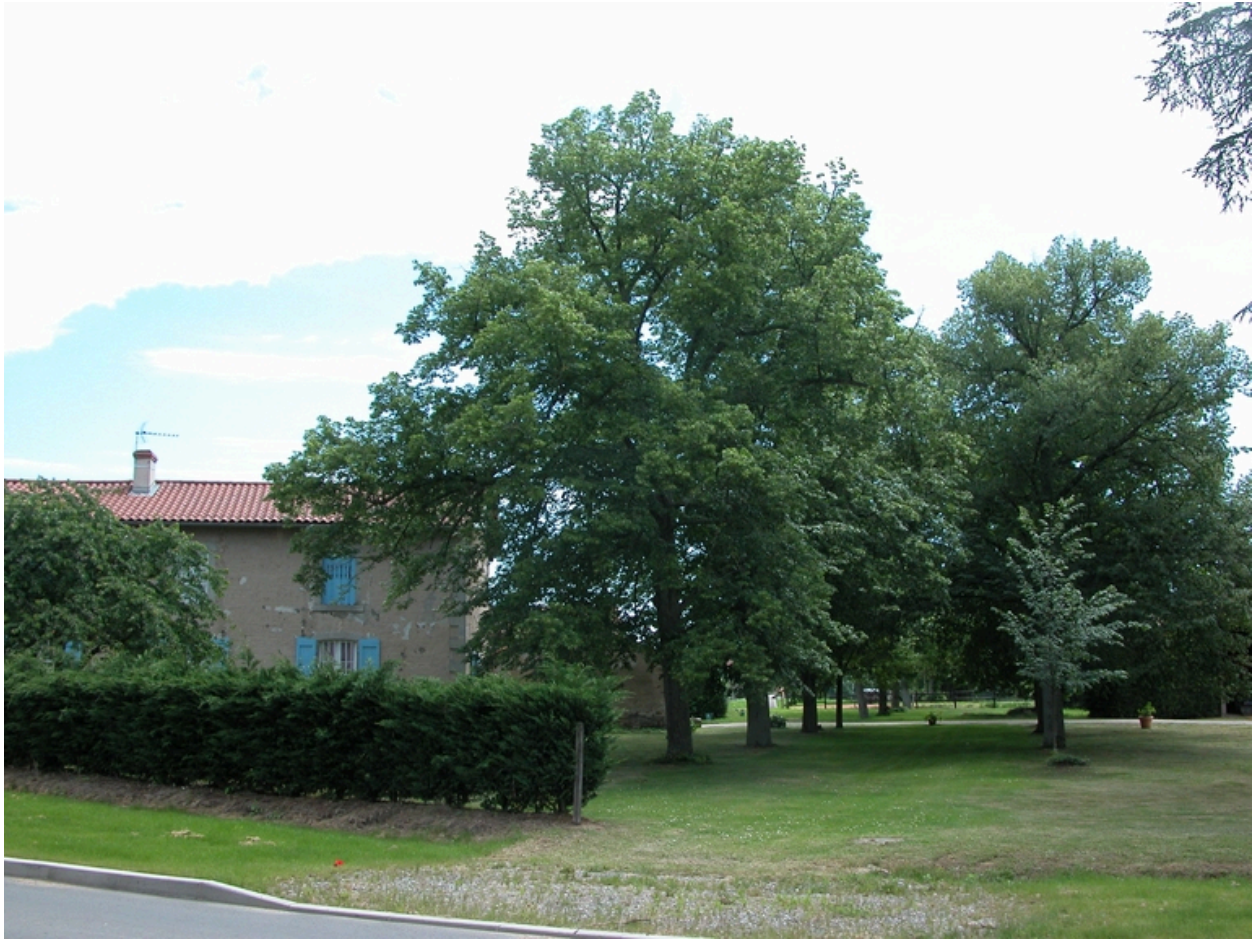
Vue d'ensemble depuis l'ouest : logis.
