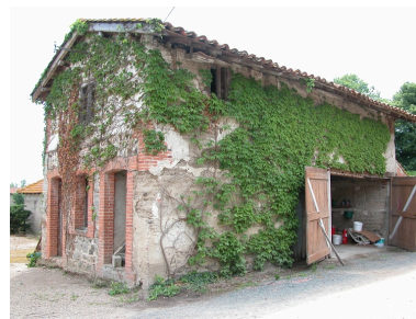
Vue d'ensemble du logement d'ouvriers agricoles. Phot. Thierry Monnet IVR82_20134201874NUCA
