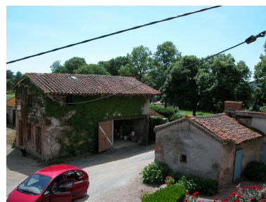
Vue d'ensemble de la cour depuis l'escalier du logis, à l'est : logement d'ouvriers agricoles et remise, fournil. Phot. Thierry Monnet IVR82_20134201869NUCA
