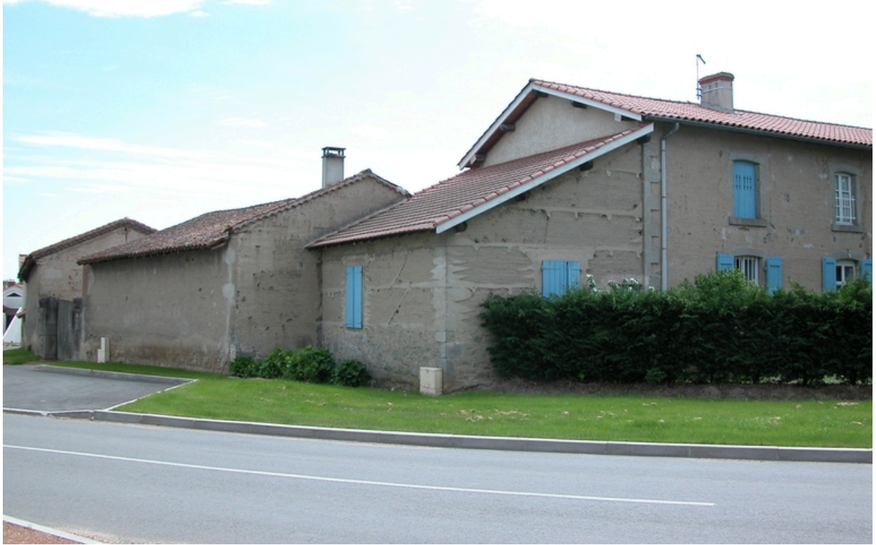
Vue d'ensemble depuis le nord-ouest : logis, logement adossé, hangar, étable.
