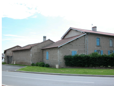
Vue d'ensemble depuis le nord-ouest : logis, logement adossé, hangar, étable. Phot. Thierry Monnet IVR82_20134201879NUCA
