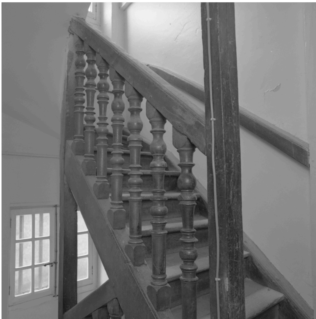
Escalier, détail balustrade.
