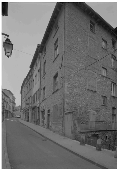
Elévation sur la rue de l'Herberie et la rue Brûlée. Phot. Eric Dessert IVR82_19900100390P
