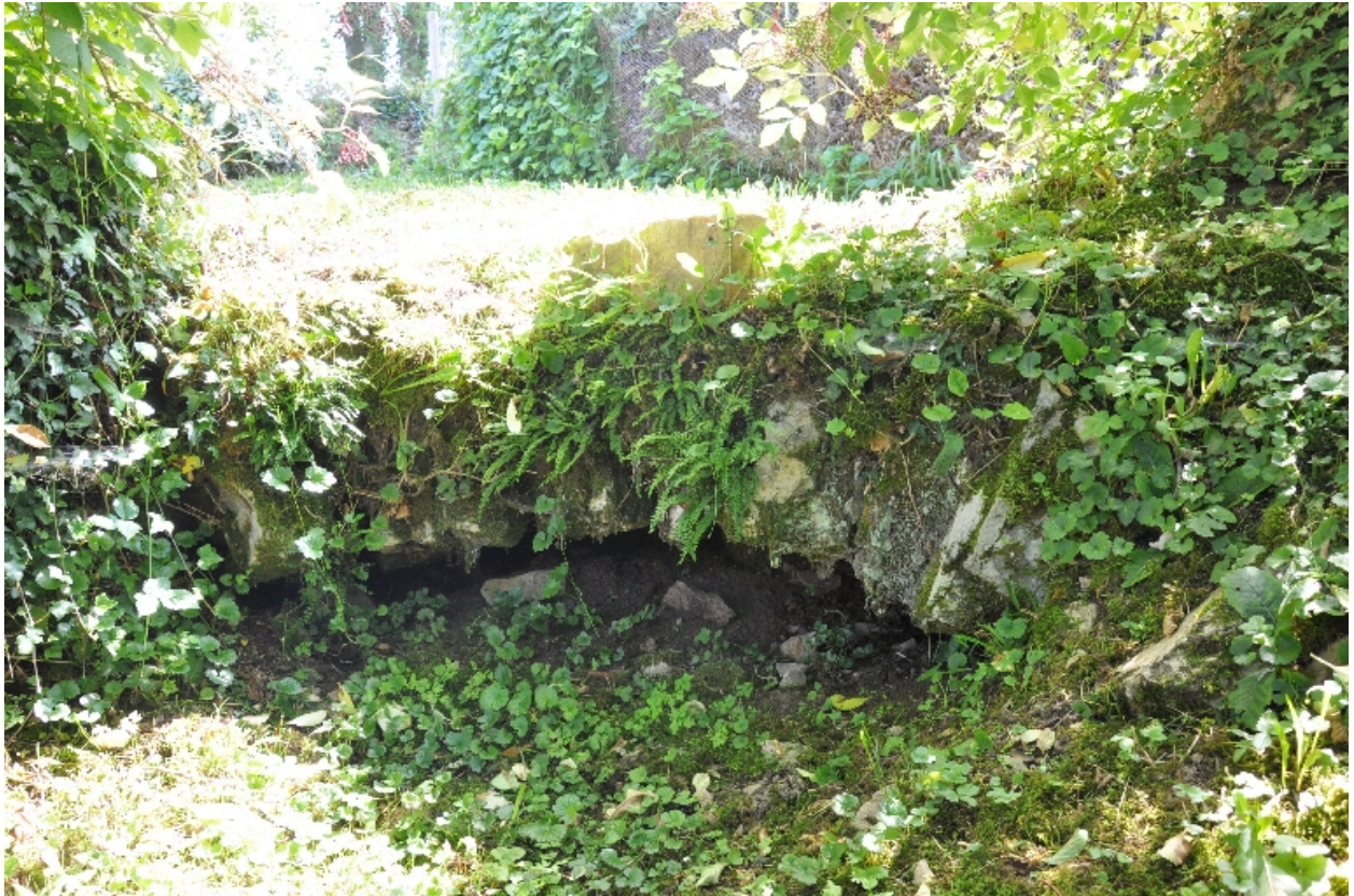
Elément d'arc en anse de panier, vestige du moulin de Lachat
