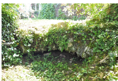
Elément d'arc en anse de panier, vestige du moulin de Lachat Phot. Yannick Milleret IVR82_20127301830NUCA
