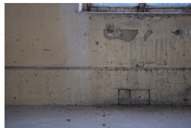
Second étage, salle désaffectée, détail d'une trappe Phot. Catherine Guégan IVR82_20096904417NUCA
