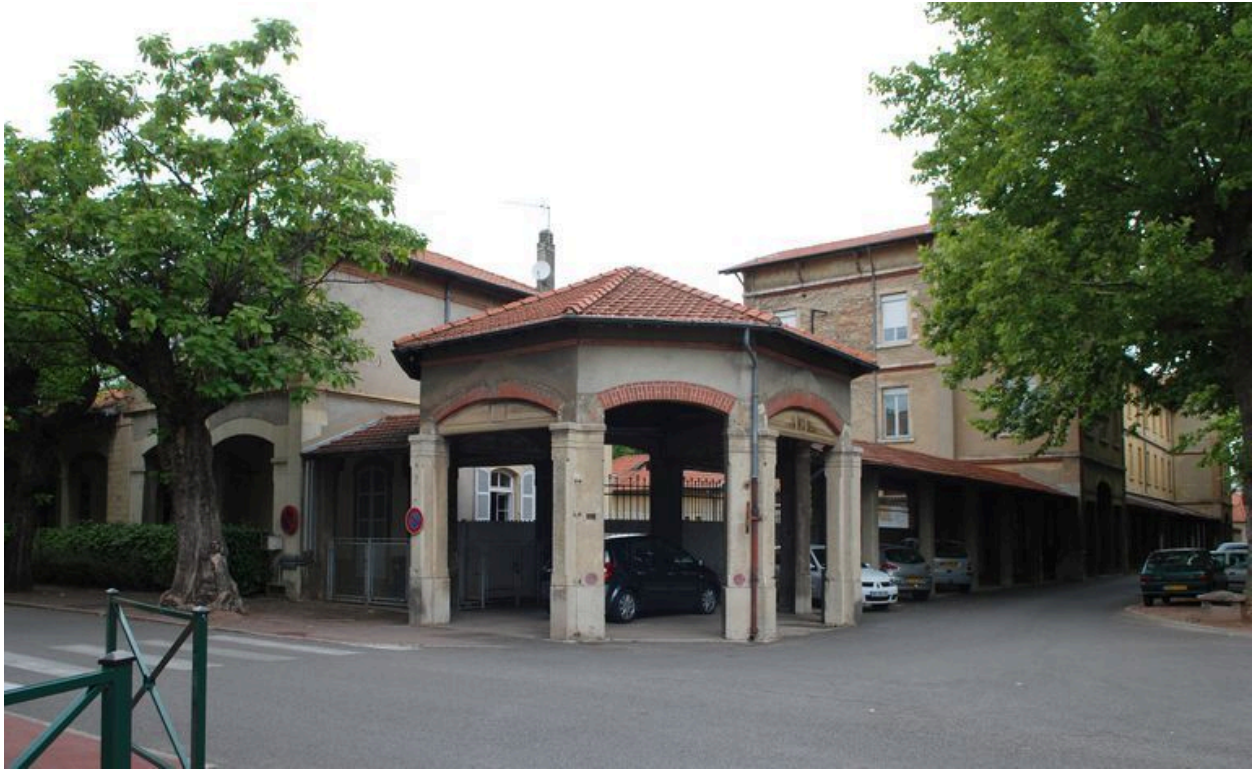
Façade principale (est), avant-corps sud relié à un portique
