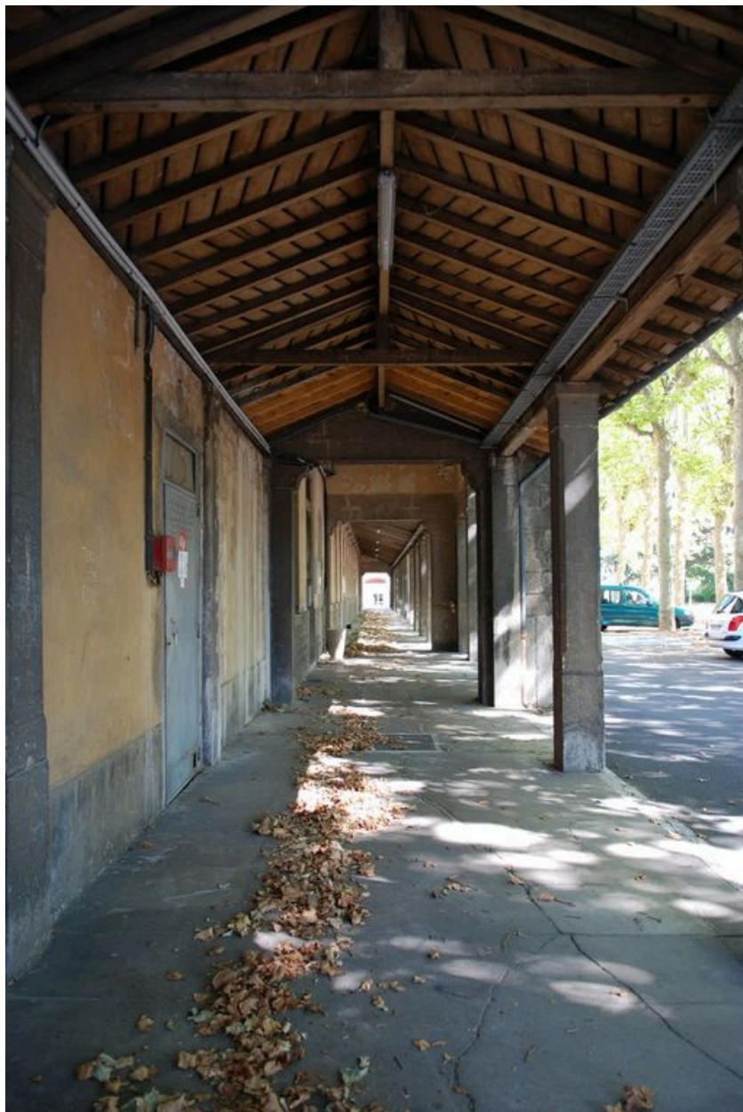
Façade principale (est), galerie centrale
