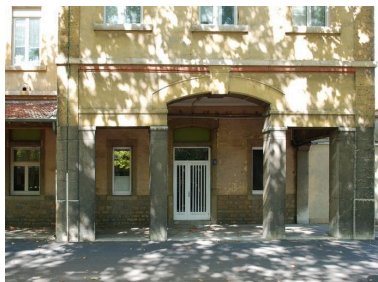
Façade principale (est), avant-corps nord, serlienne Phot. Catherine Guégan IVR82_20096904402NUCA
