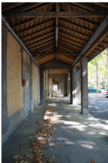
Façade principale (est), galerie centrale
