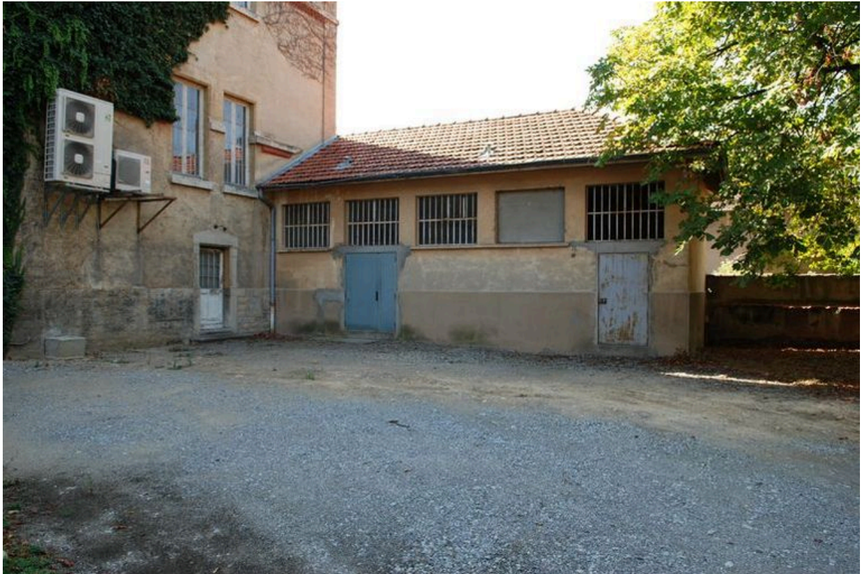
Détail de l'adjonction accolée à l'avant-corps sud, façade postérieure (ouest)
