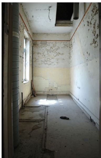
Second étage, sanitaires désaffectés Phot. Catherine Guégan IVR82_20096904418NUCA
