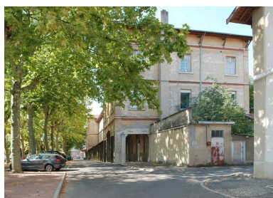
Façade nord avec son adjonction Phot. Catherine Guégan IVR82_20096904404NUCA
