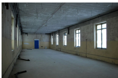
Premier étage, ancien dortoir, salle désaffectée Phot. Catherine Guégan IVR82_20096904412NUCA
