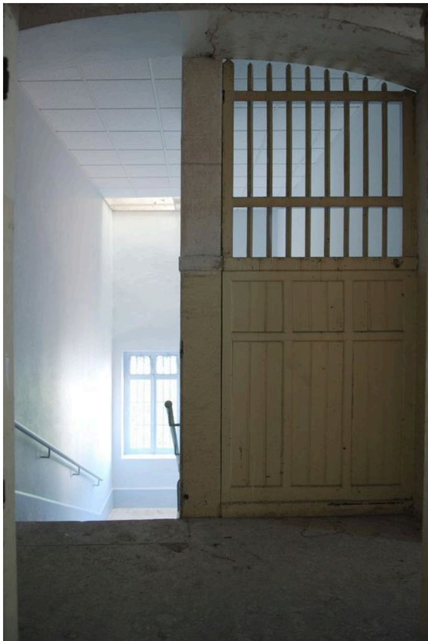
Palier du second étage de l'escalier nord
