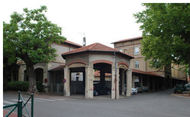
Façade principale (est), avant- corps sud relié à un portique Phot. Catherine Guégan IVR82_20096904400NUCA
