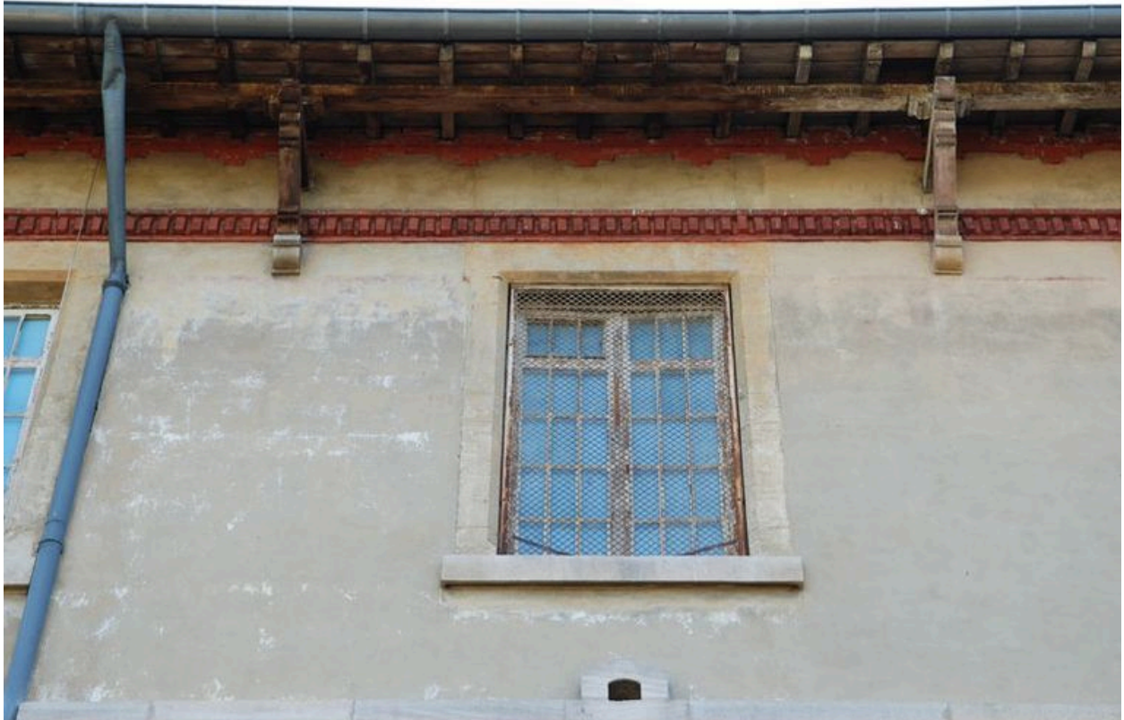
Façade postérieure (ouest), détail de la saillie du toit, corbeaux et bandeaux de briques
