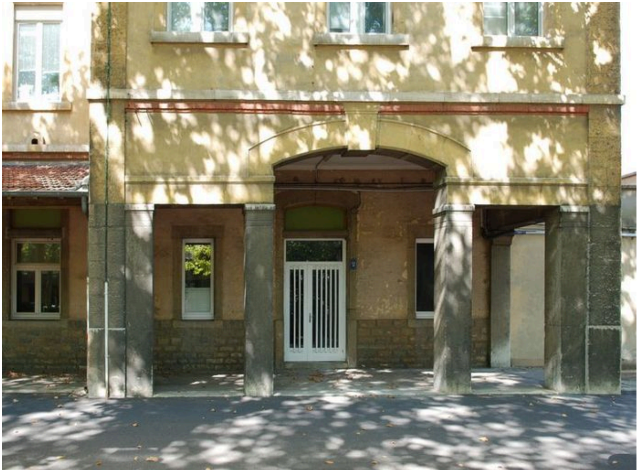
Façade principale (est), avant-corps nord, serlienne
