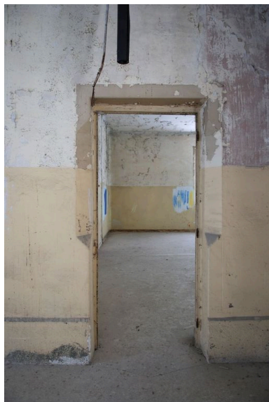
Encadrement de porte, second étage, salles désaffectées Phot. Catherine Guégan IVR82_20096904414NUCA
