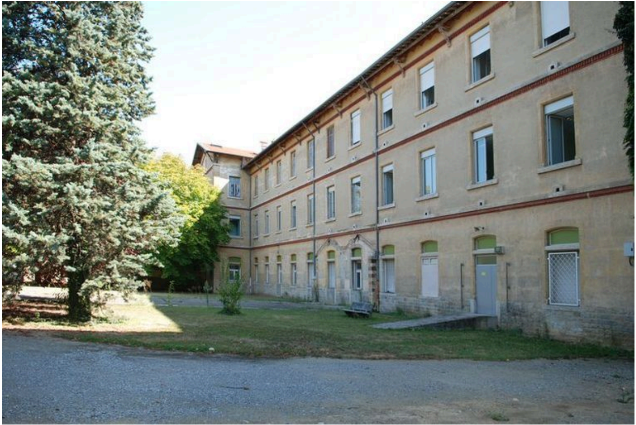
Façade postérieure (ouest) depuis le sud-ouest
