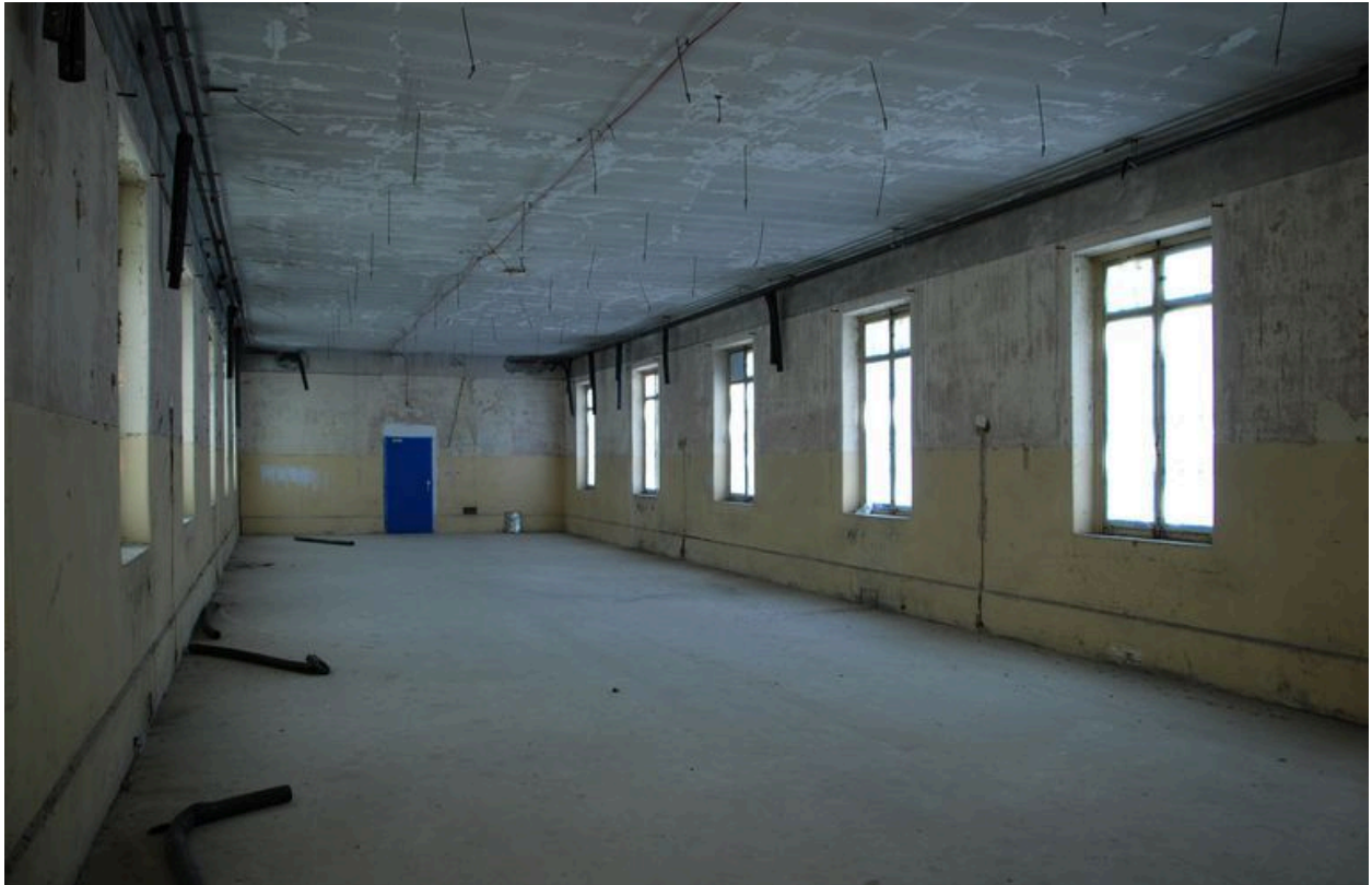
Premier étage, ancien dortoir, salle désaffectée
