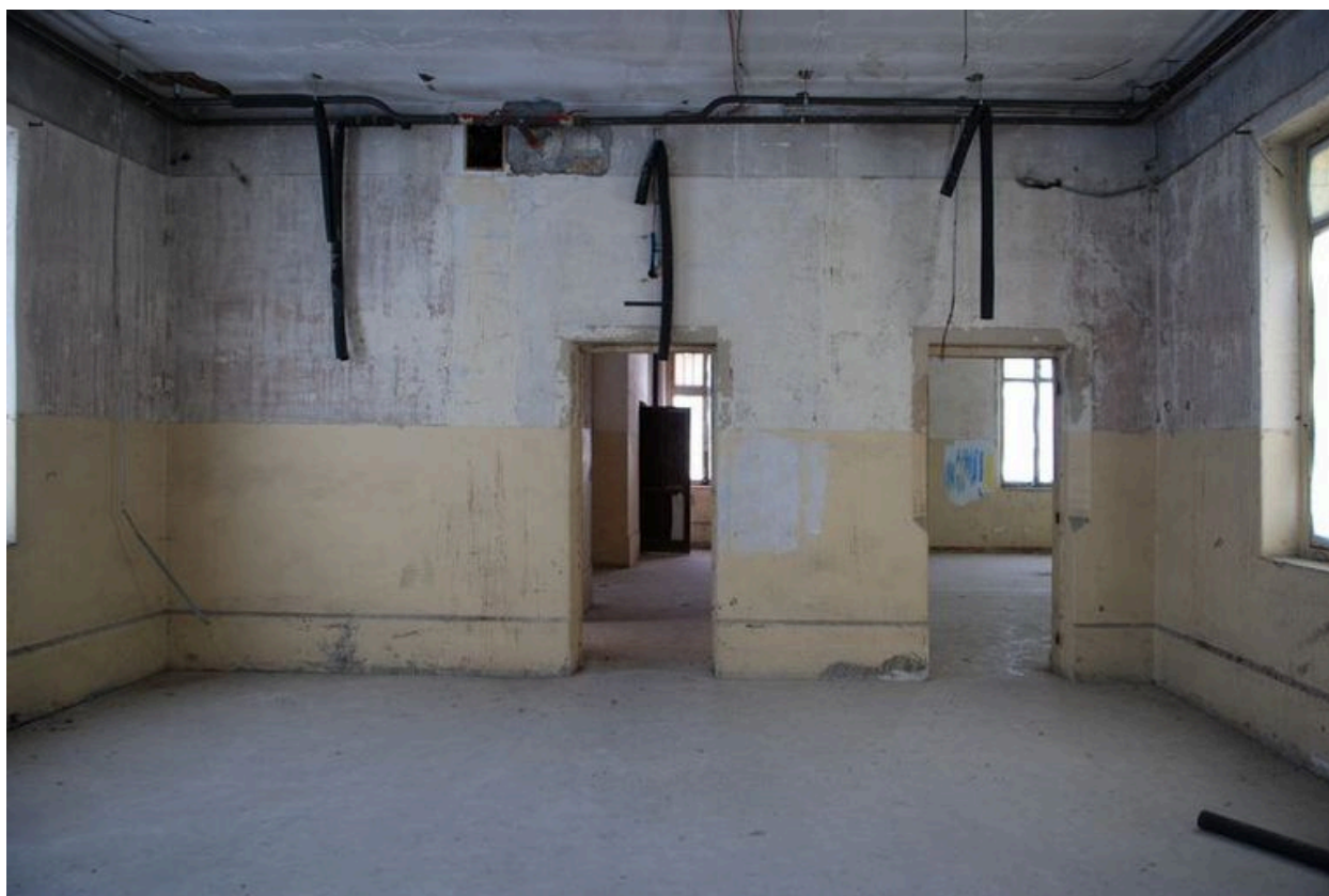
Second étage, salles désaffectées
