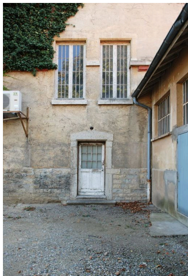
Façade postérieure (ouest), avant-corps sud, détail de la porte Phot. Catherine Guégan IVR82_20096904409NUCA
