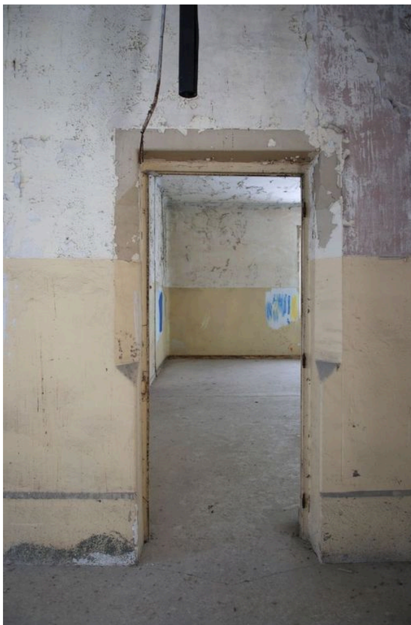
Encadrement de porte, second étage, salles désaffectées
