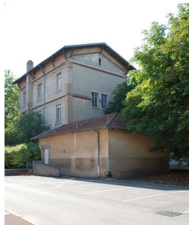
Vue d'ensemble du bâtiment des tranquilles et semi-tranquilles et de son adjonction, depuis le nord-est Phot. Catherine Guégan IVR82_20096904403NUCA
