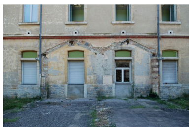
Détail de la façade postérieure (ouest) : traces du promenoir menant aux sanitaires Phot. Catherine Guégan IVR82_20096904406NUCA
