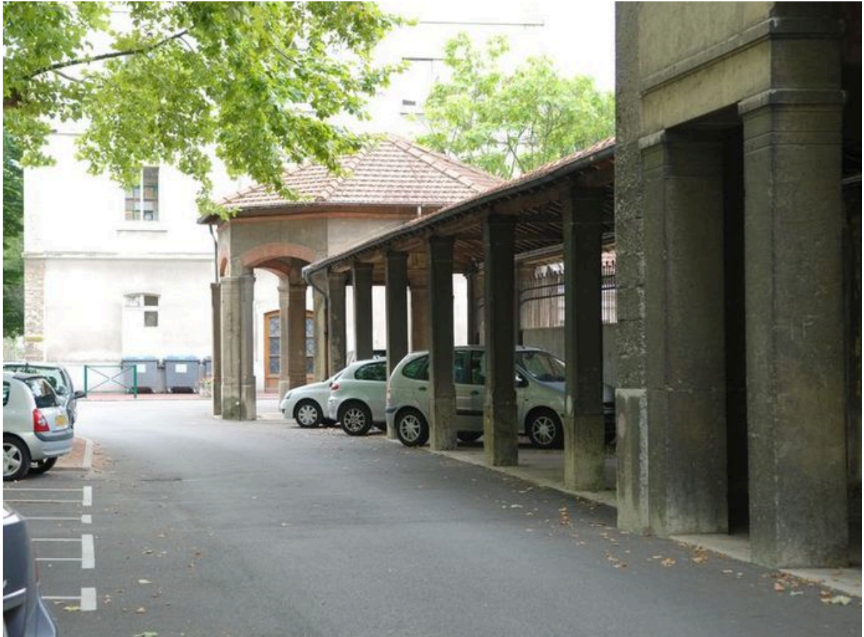
Vue d'ensemble de l'avant-corps sud, du portique et du pavillon d'angle, façade principale (est)
