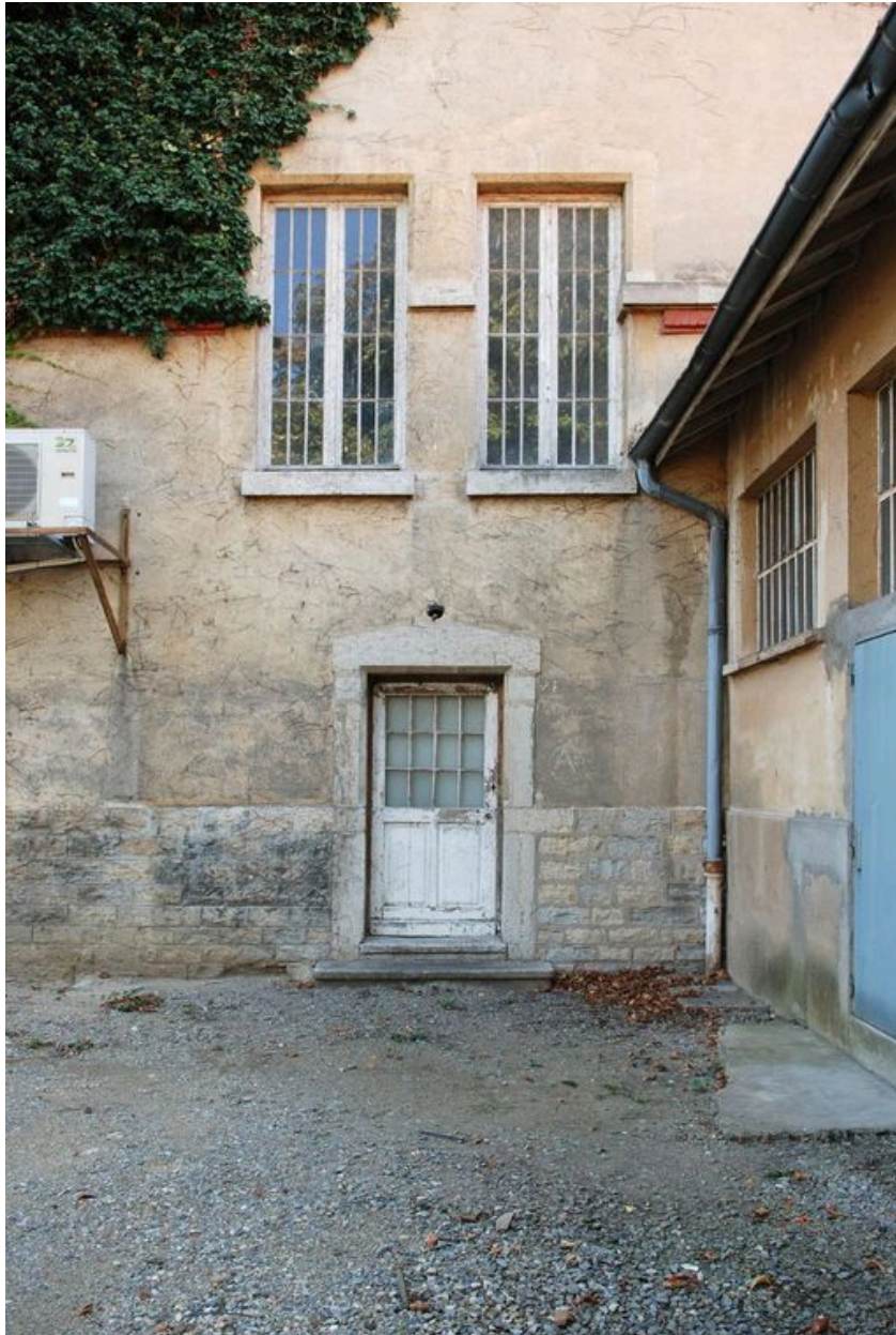
Façade postérieure (ouest), avant-corps sud, détail de la porte
