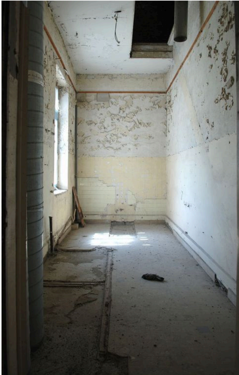
Second étage, sanitaires désaffectés
