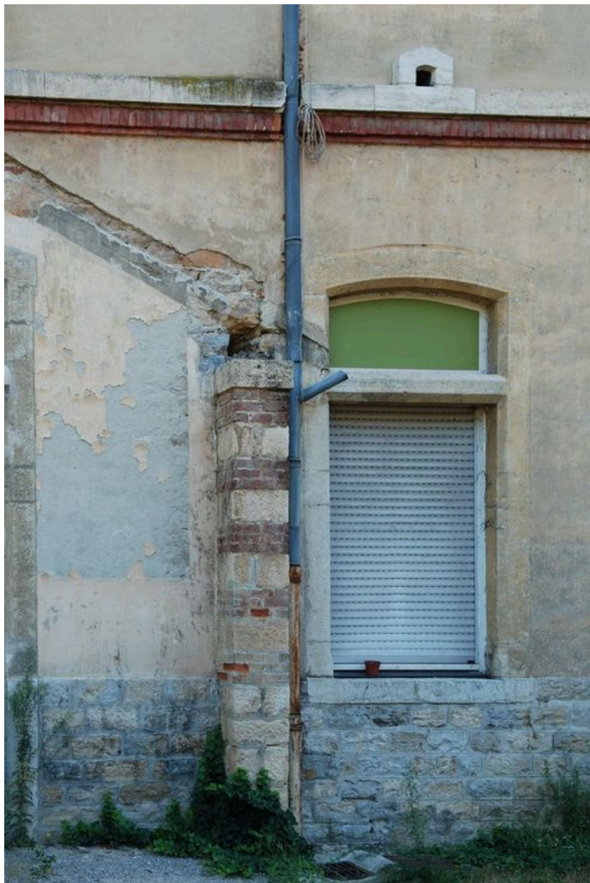
Façade postérieure (ouest), détail du pilier du promenoir en brique et pierre
