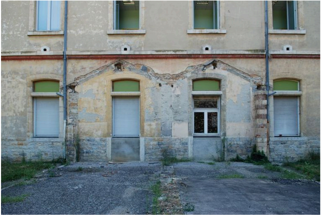
Détail de la façade postérieure (ouest) : traces du promenoir menant aux sanitaires
