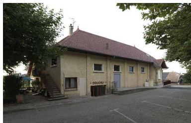
Vue du foyer de la campagne, façade orientale : entrée des douches.
