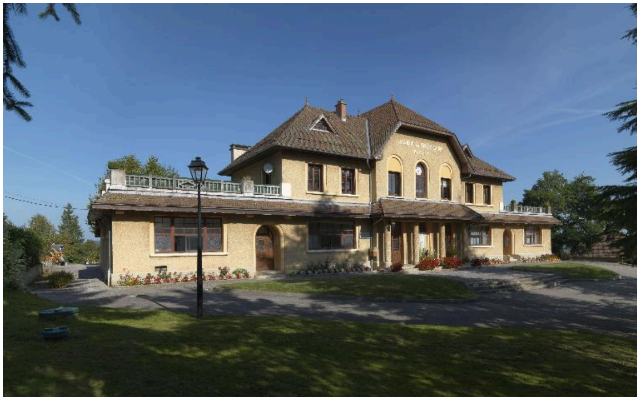
Vue d'ensemble de la mairie-écoles, depuis le sud-est.
