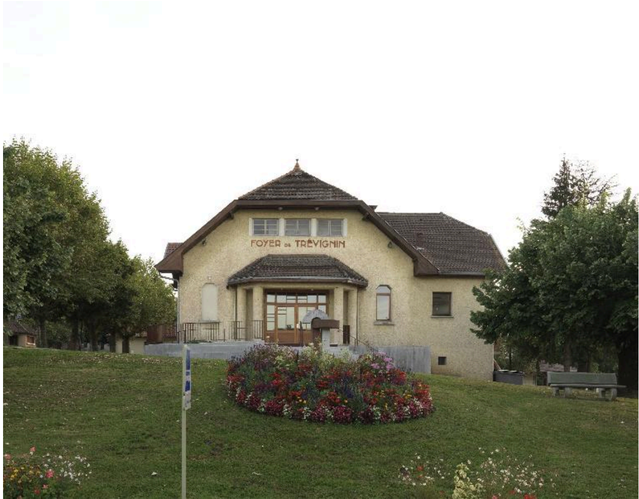
Vue du foyer de la campagne, façade nord.
