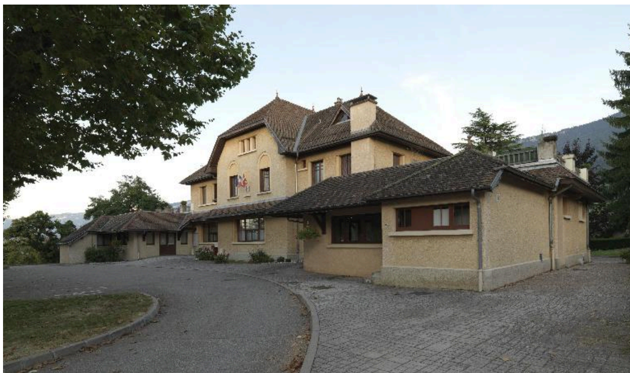
Vue d'ensemble du foyer de la campagne, depuis le sud.
