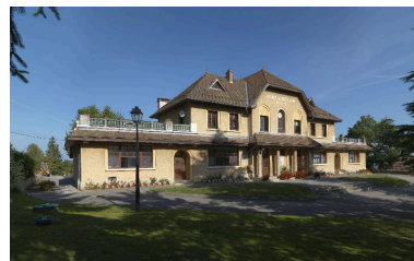
Vue d'ensemble de la mairie-écoles, depuis le sud-est. Phot. Eric Dessert IVR82_20147304303NUCA
