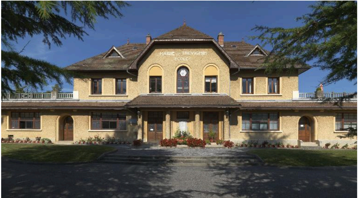
Vue d'ensemble de la mairie-écoles, façade orientale.
