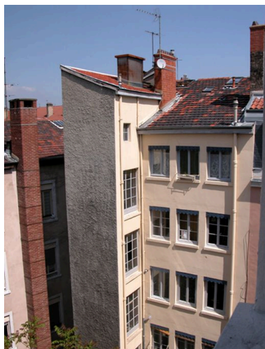
Elévation postérieure depuis le 4 avenue Jean-Jaurès Phot. Maryannick Chalabi IVR82_20046904542NUCA
