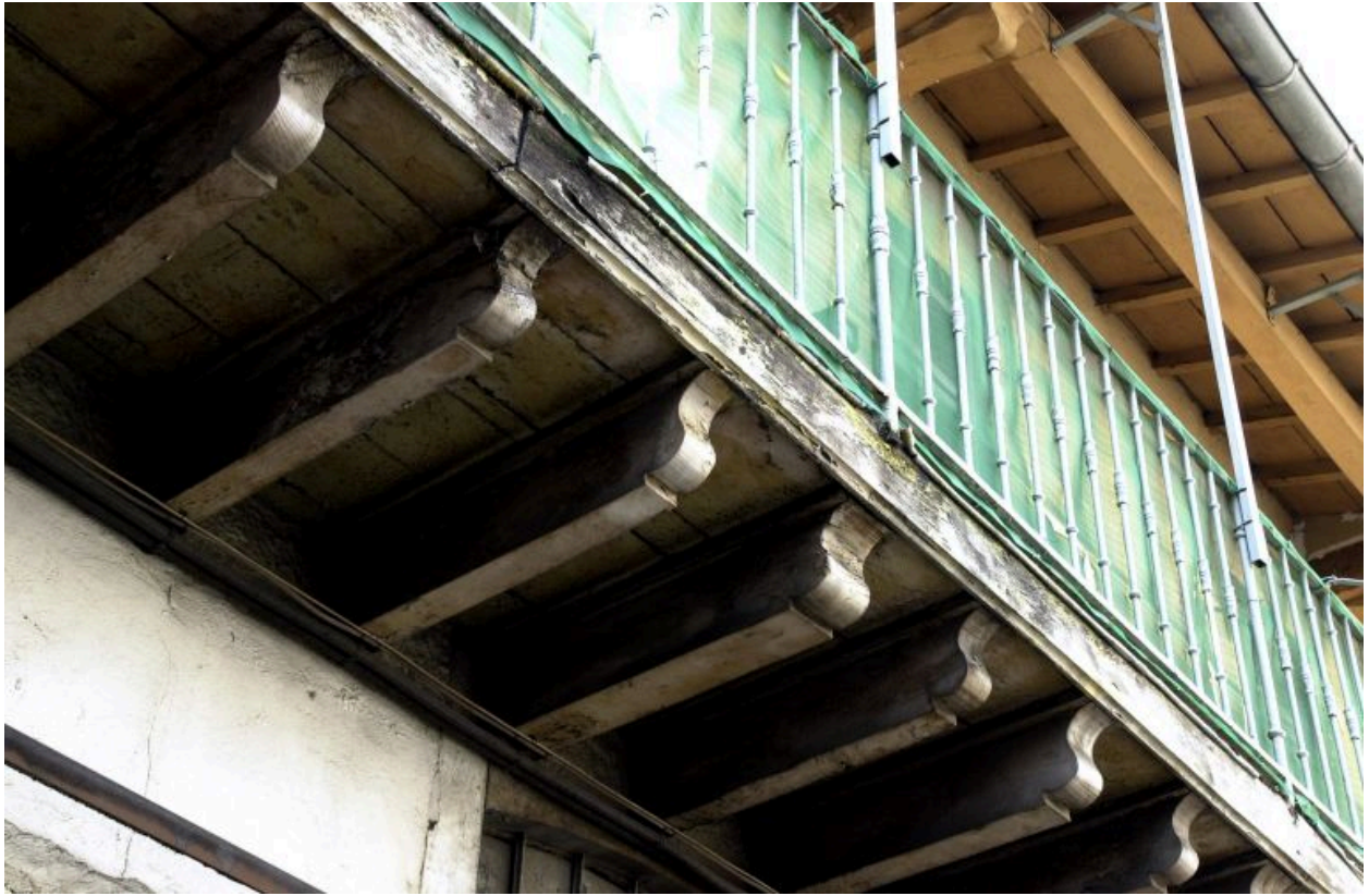
Détail de la coursière
