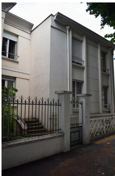
Façade sur le boulevard Cote-Blatin Phot. Félicie Fougère IVR84_20246301673NUCA
