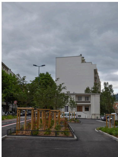
Façade de la maison à l'angle du boulevard Cote-Blatin et de la rue des Prés-Bas. Au premier plan, la place réaménagée. Phot. Félicie Fougère IVR84_20246301291NUCA
