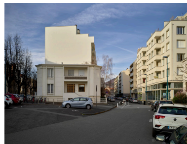
Elévation sur le carrefour de la rue des Prés-Bas et du boulevard Cote-Blatin Phot. Christian Parisey IVR84_20236300304NUC4A
