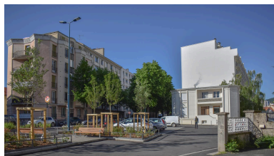
La place du carrefour de la rue des Prés-Bas et du boulevard Cote-Blatin réaménagée. Façade de l'immeuble (à gauche) et de la maison Vigneron (à droite) Phot. Félicie Fougère IVR84_20246301292NUCA
