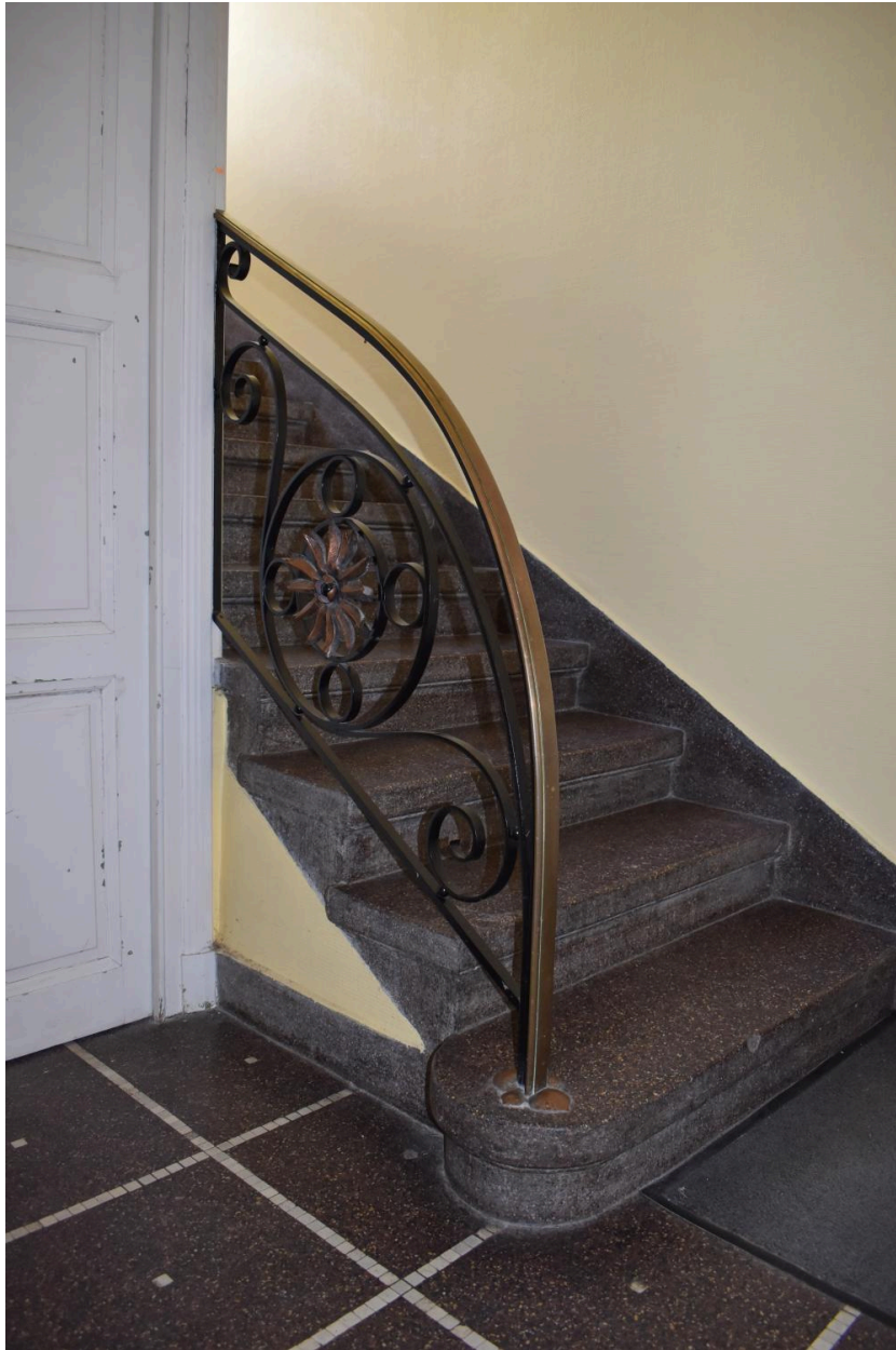
Départ de l'escalier et main-courante en fer forgé
