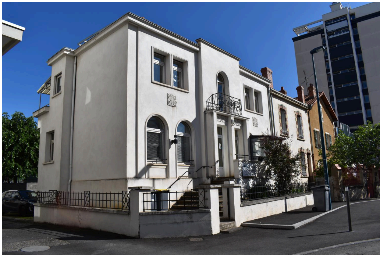
Façade sur le boulevard Cote-Blatin et élévation aveugle latérale
