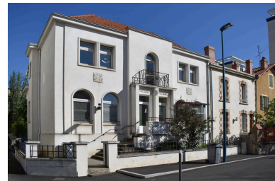
Façade sur le boulevard Cote-Blatin Phot. Félicie Fougère IVR84_20246301285NUCA
