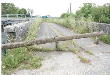
Ancien pont des Annonciades, vue de la chaussée et des parapets Phot. Pascale Renard IVR84_20207403175NUCA
