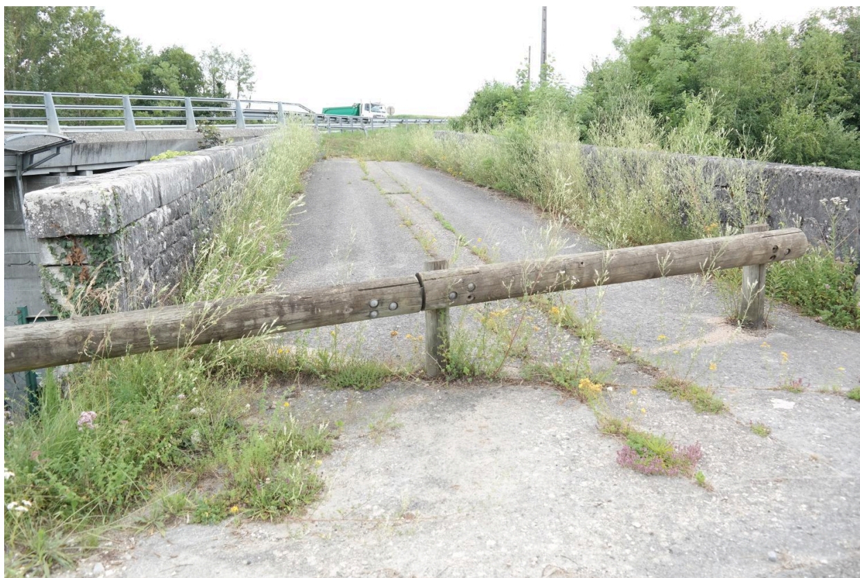
Ancien pont des Annonciades, vue de la chaussée et des parapets
