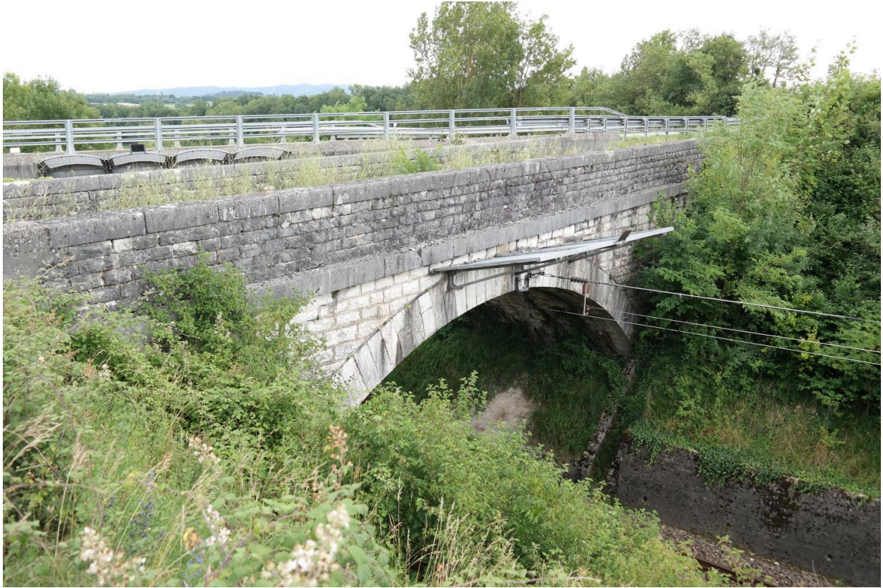
Ancien pont de Annonciades, vue de la face est
