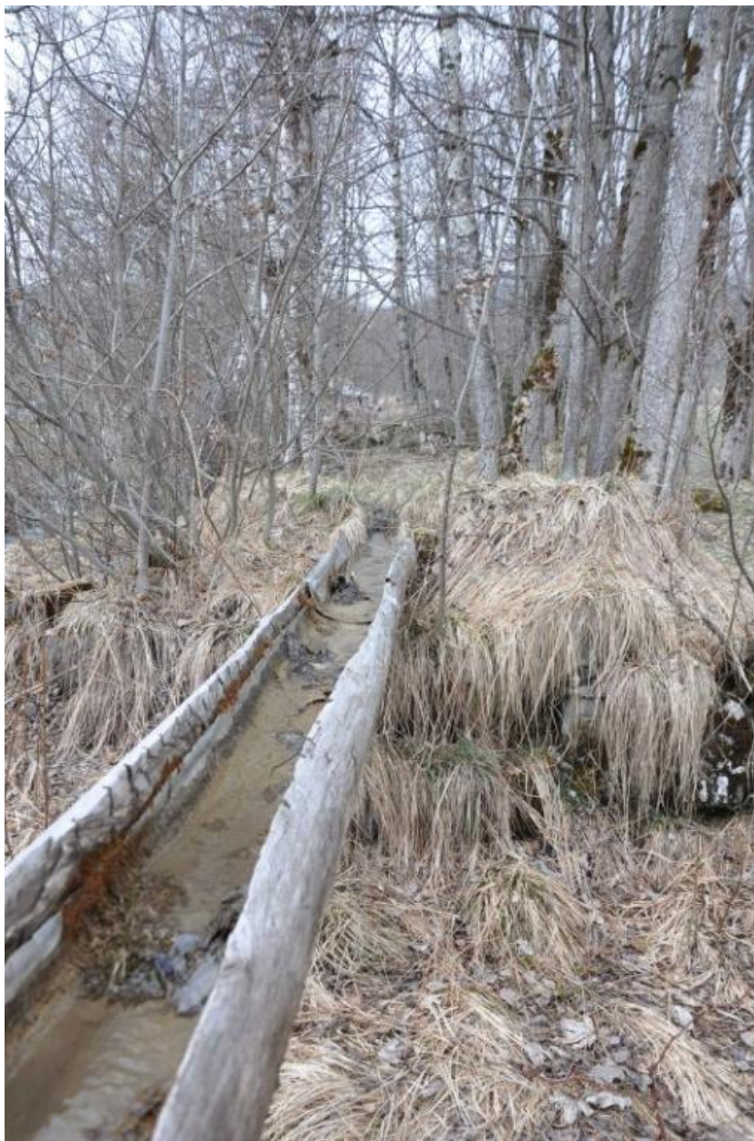
Canal d'amenée du moulin taillé dans un tronc soutenu par un muret de pierre.
