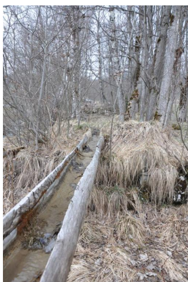
Canal d'amenée du moulin taillé dans un tronc soutenu par un muret de pierre. Phot. Clara Bérelle IVR84_20197300109NUCA
