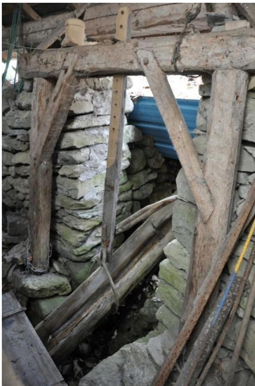
Arrivée de la dérivation alimentant la roue située sous le bâtiment.
