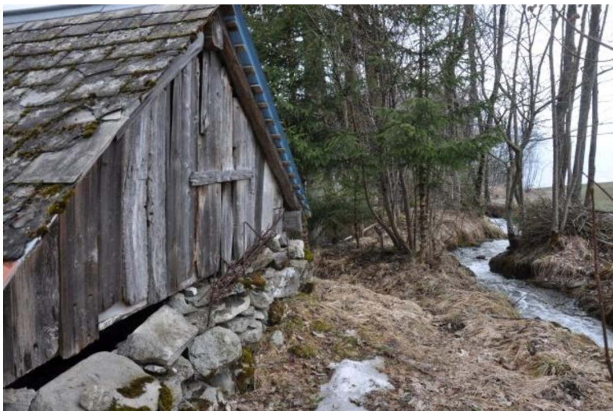
Pignon ouest du moulin.
