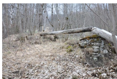
Canal d'amenée du moulin taillé dans un tronc soutenu par un muret de pierre. Phot. Clara Bérelle IVR84_20197300112NUCA
