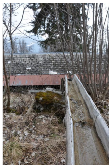
Au premier plan, le canal d'amenée. Au second plan, le moulin. Phot. Clara Bérelle IVR84_20197300110NUCA
