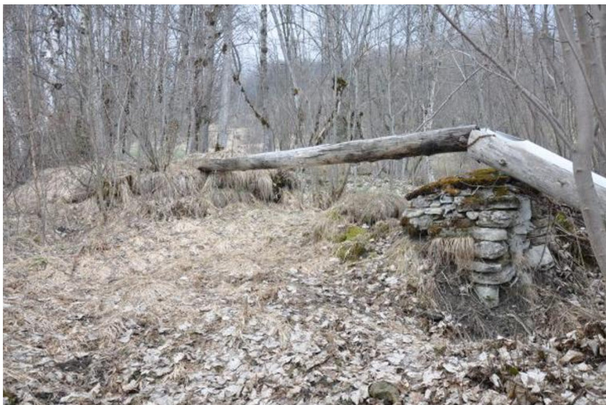
Canal d'amenée du moulin taillé dans un tronc soutenu par un muret de pierre.
