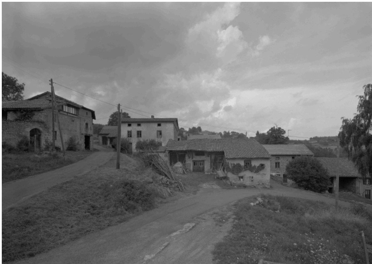
Vue générale du hameau de Chazelles-bas depuis le sud.
