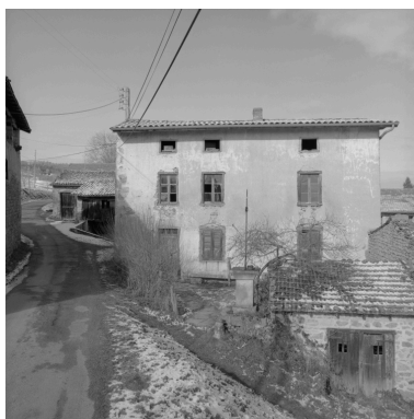
Vue d'ensemble depuis le sud. Phot. Eric Dessert IVR82_20014200585X
