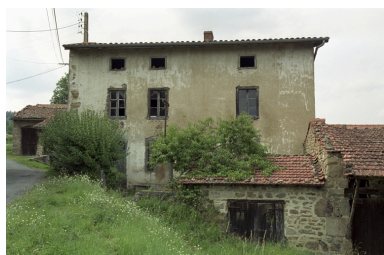
Vue d'ensemble depuis le sud. Phot. Caroline Guibaud IVR82_20044200744ZE
