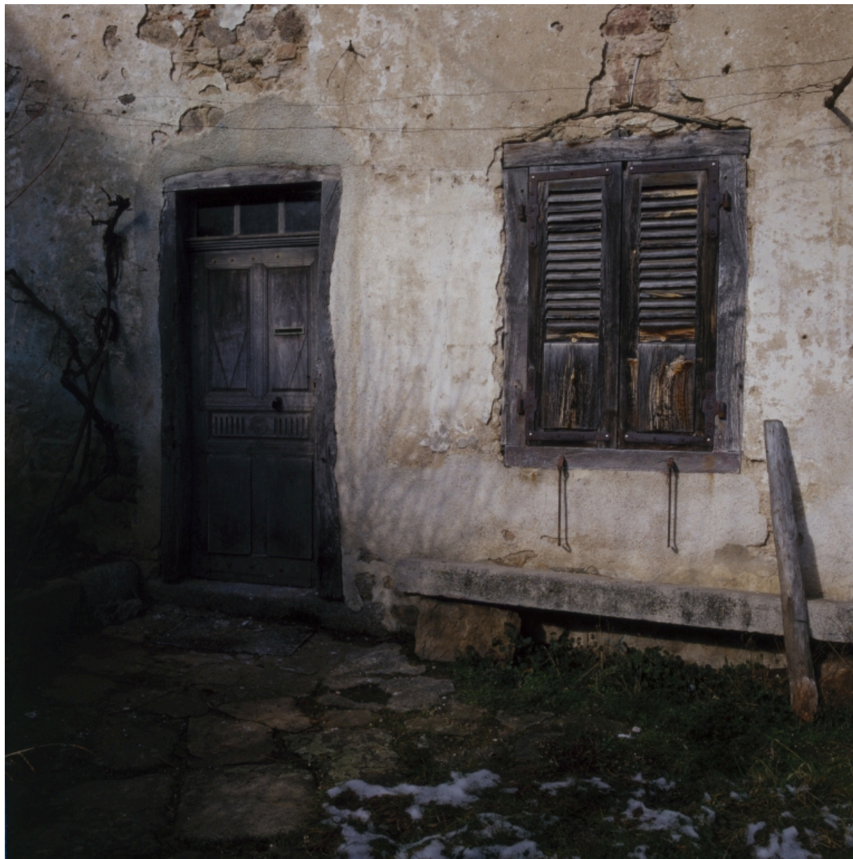
Détail de la porte et de la fenêtre du rez-de-chaussée.
