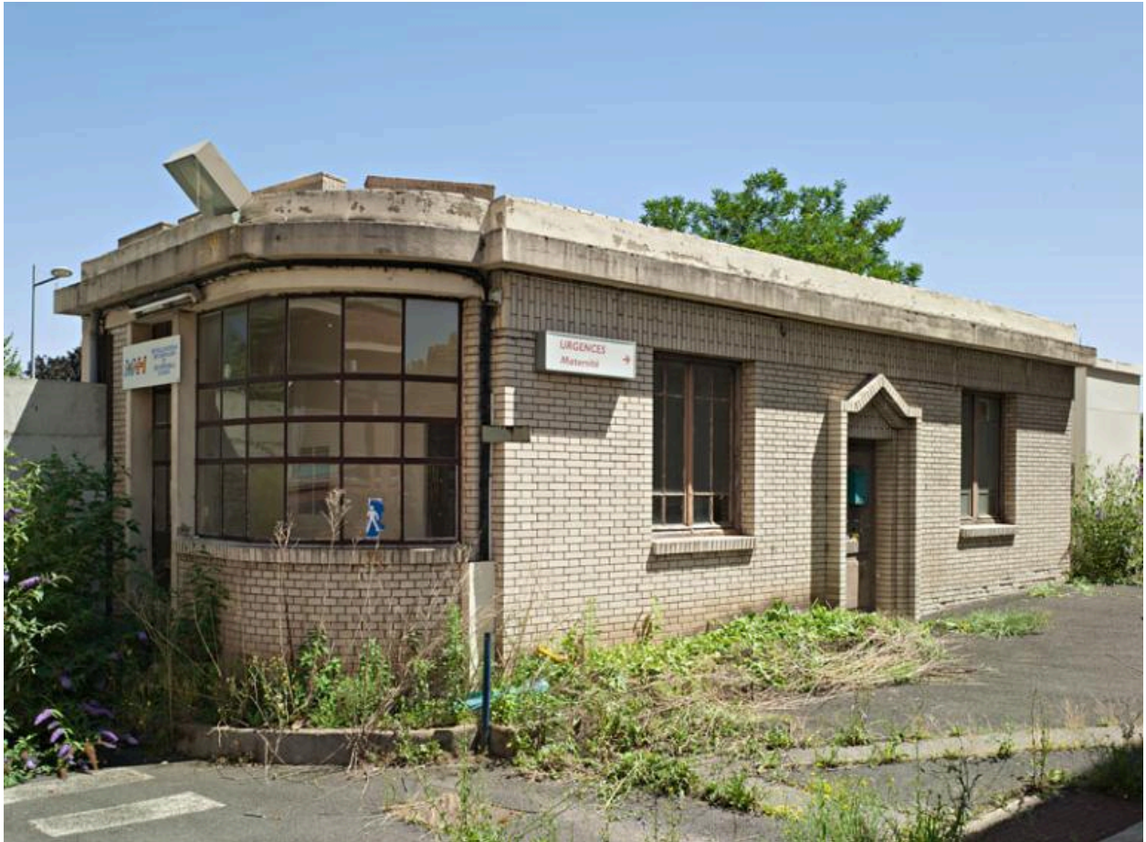
Hôtel-Dieu de Clermont-Ferrand. La conciergerie de l'entrée orientale (avenue Vercingétorix) vue du nord-ouest.
