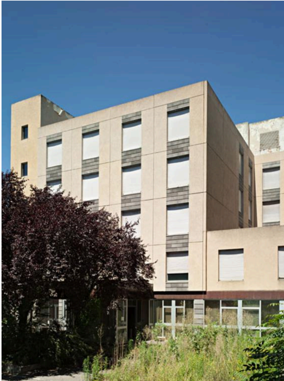
Hôtel-Dieu de Clermont-Ferrand. La partie gauche de la façade sud du service de gastro-entérologie.
