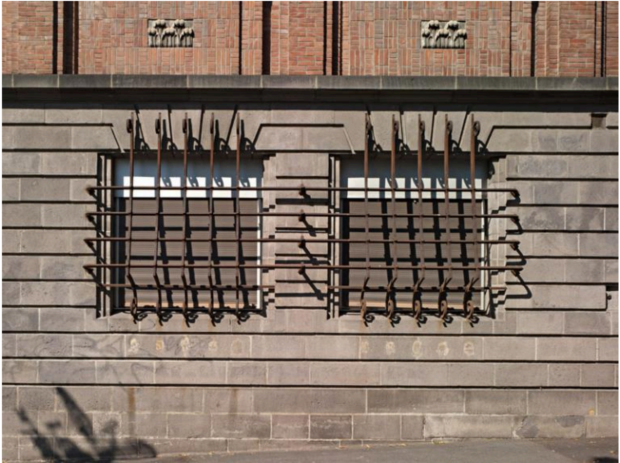
Hôtel-Dieu de Clermont-Ferrand. Le pavillon des maladies sociales, façade orientale, grilles de défense des fenêtres du rez-de-chaussée.
