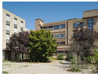
Hôtel-Dieu de Clermont- Ferrand. A l'arrière du pavillon des maladies sociales, la façade ouest des laboratoires et la partie droite de la façade sud du service de gastro-entérologie.
