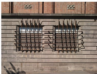
Hôtel-Dieu de Clermont-Ferrand. Le pavillon des maladies sociales, façade orientale, grilles de défense des fenêtres du rez-de-chaussée. Phot. Jean-Michel Périn IVR83_20146300640NUC4A
