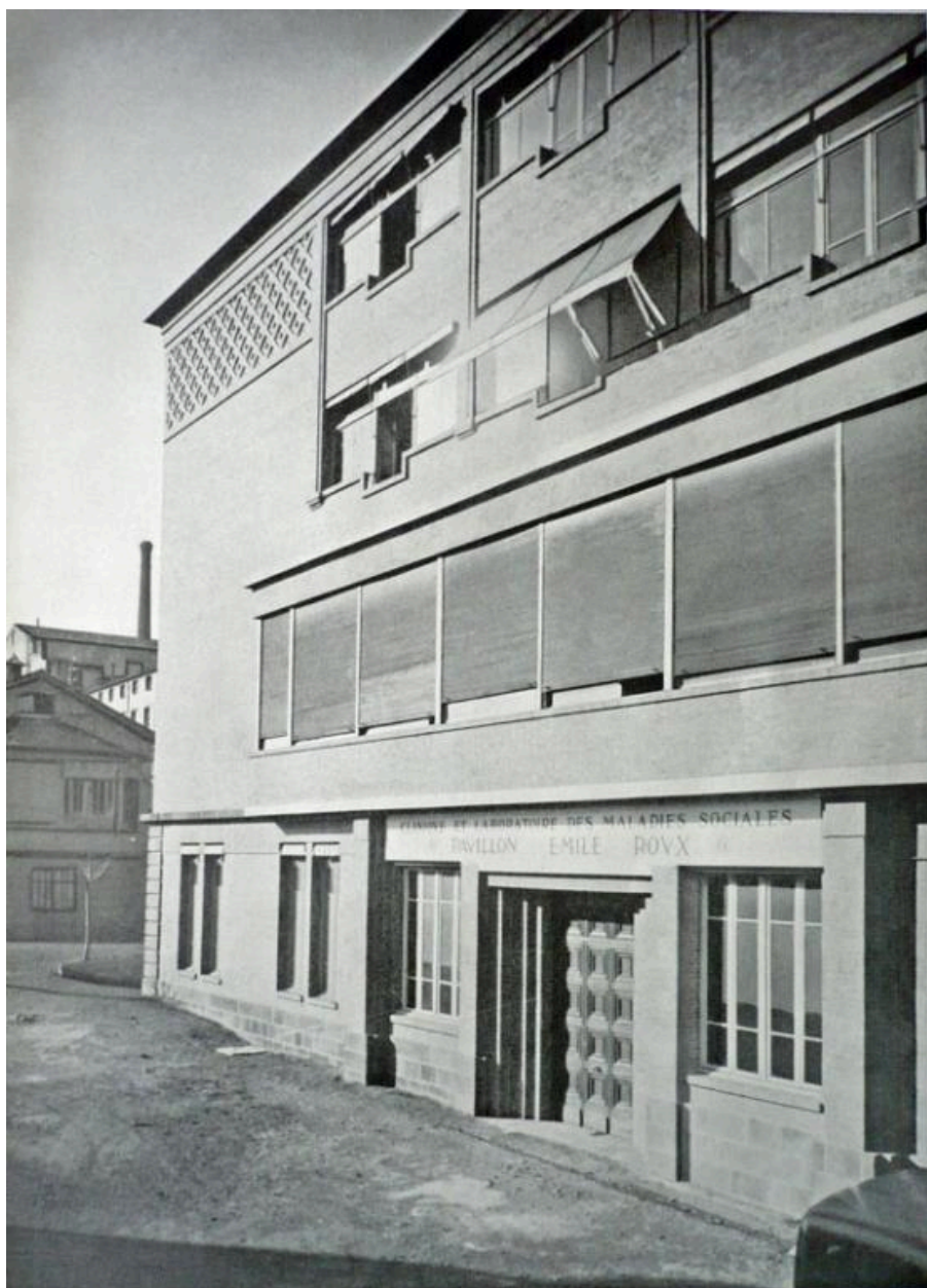
Hôtel-Dieu de Clermont-Ferrand. Le pavillon des maladies sociales, la façade principale vue du sud-est, vers 1936.
