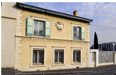
Vue générale Phot. Julien Defillon IVR82_20106900848NUCA
