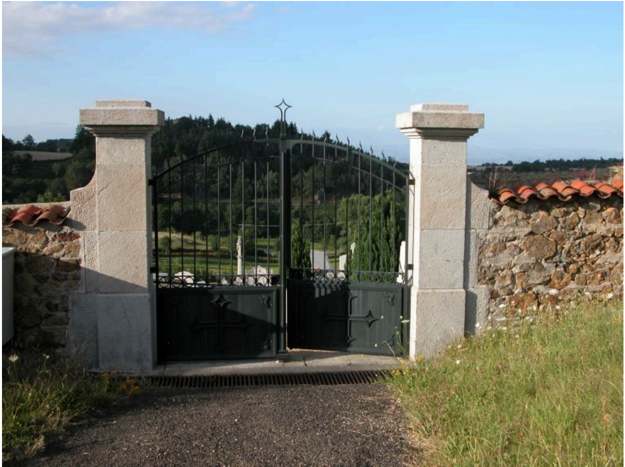
Vue d'ensemble du portail de l'agrandissement du cimetière.
