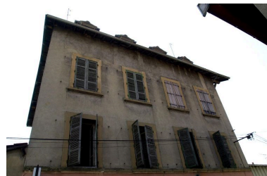
Elévation principale : détail des deux étages carrés Phot. François Blanchetière IVR82_20016902255NUCA
