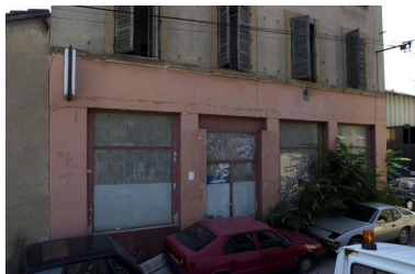
Elévation principale : détail du rez-de-chaussée Phot. François Blanchetière IVR82_20016902254NUCA
