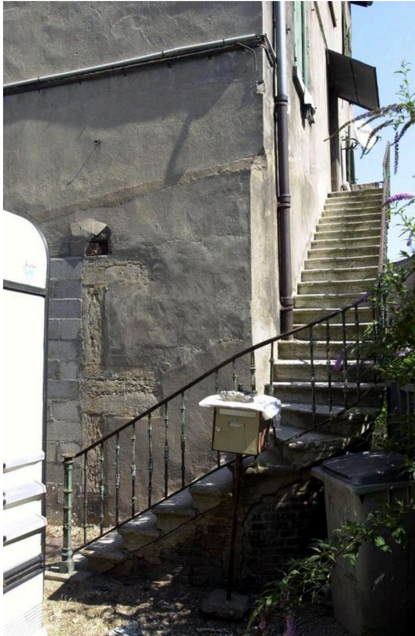
Détail de l'escalier extérieur situé sur les façades latérale et arrière donnant accès aux appartements
