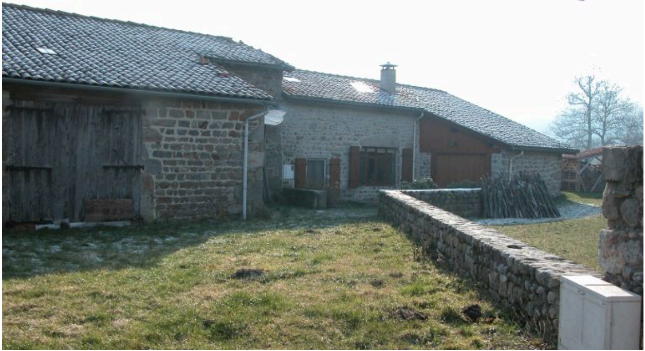
Vue d'ensemble arrière de la ferme.
