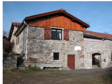
Vue d'ensemble de la façade sud de la grange-étable. Phot. Thierry Monnet IVR82_20124200146NUCA
