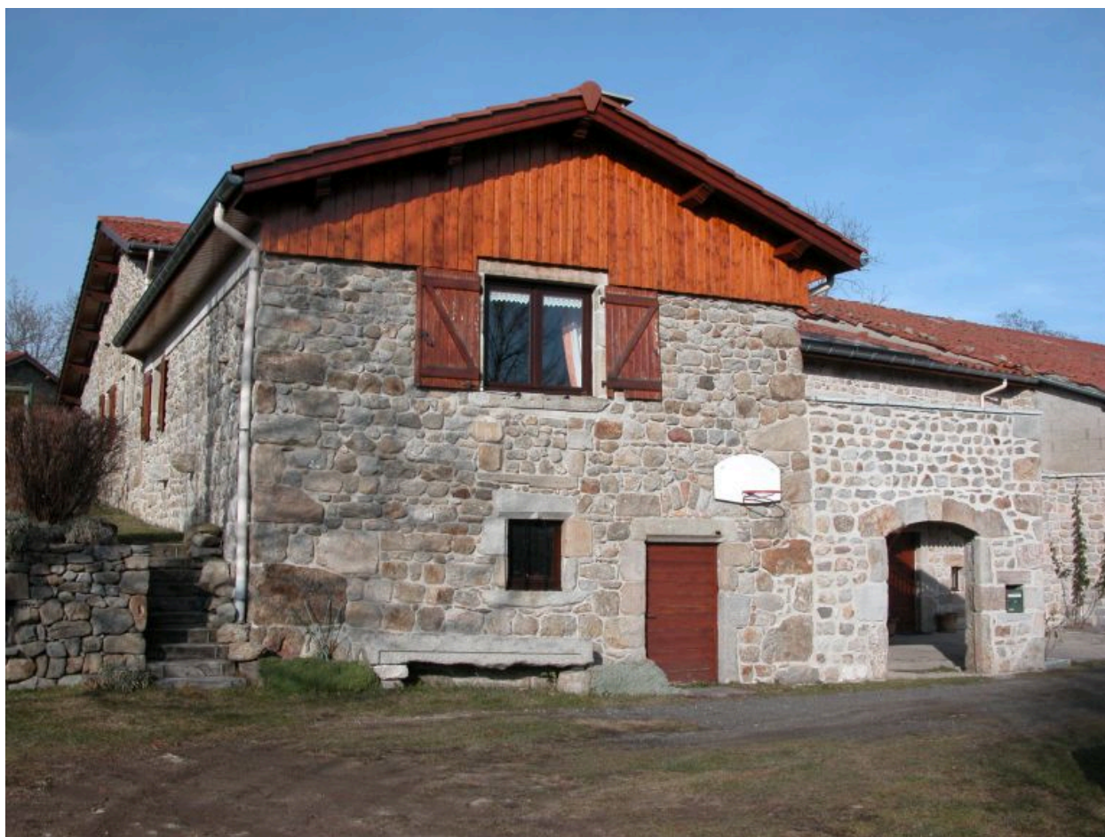
Vue d'ensemble de la façade sud de la grange-étable.
