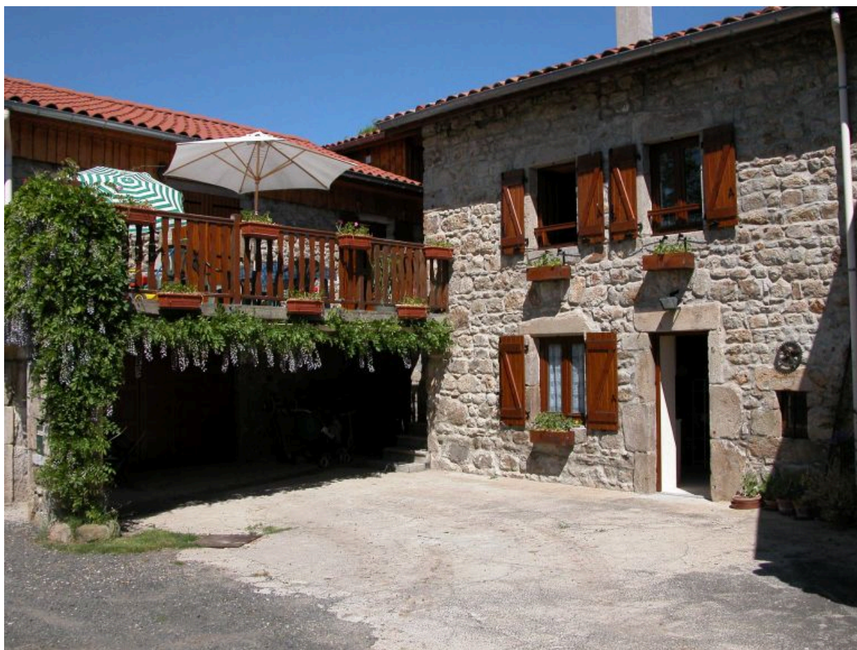
Vue d'ensemble de la façade du logis.
