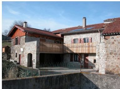
Vue générale. Phot. Thierry Monnet IVR82_20124200145NUCA
