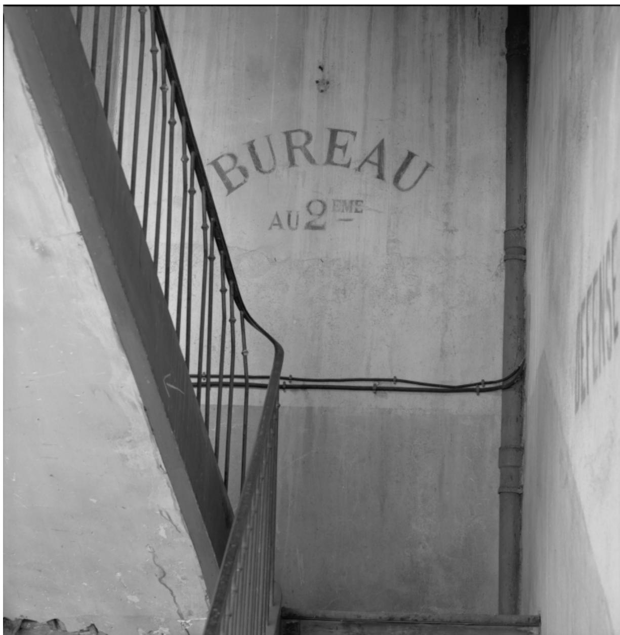
Caisserie vue intérieure, détail escalier.
