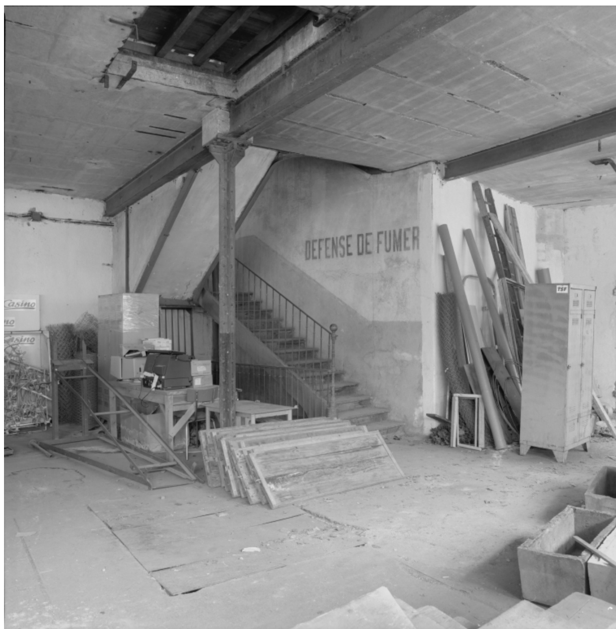
Caisserie vue intérieure du premier étage.
