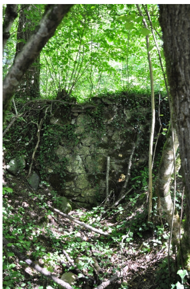
Vue du barrage Phot. Yannick Milleret IVR82_20117302161NUCA
