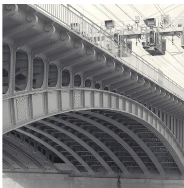
Détail d'une arche depuis le nord Phot. Eric Dessert IVR82_20026900194X
