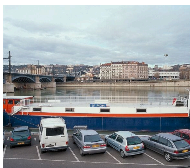
Vue d'ensemble du pont depuis le nord-est Phot. Eric Dessert IVR82_20026903026XA
