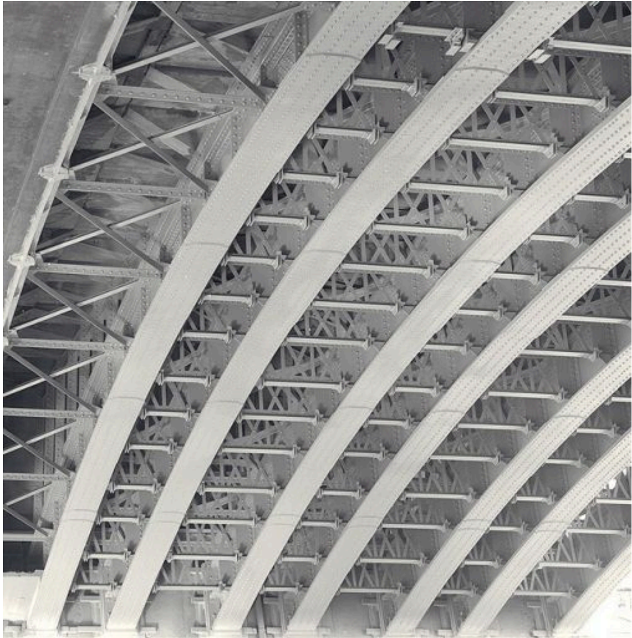
Détail du dessous des arches
