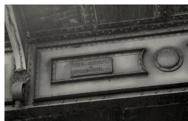
Travée de rive, quai Perrache : détail de la signature Phot. Jean-Marie Refflé IVR82_20016902865X
