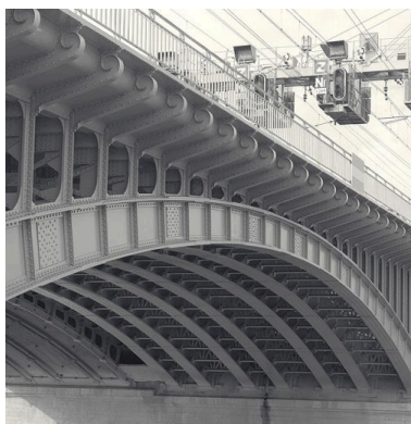
Détail d'une arche depuis le nord Phot. Eric Dessert IVR82_20026900194X
