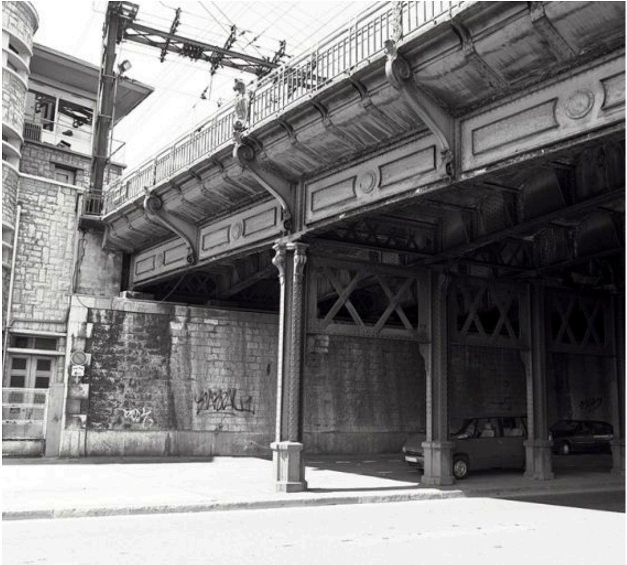
Vue de la travée de rive sur le quai Perrache, depuis le sud-est
