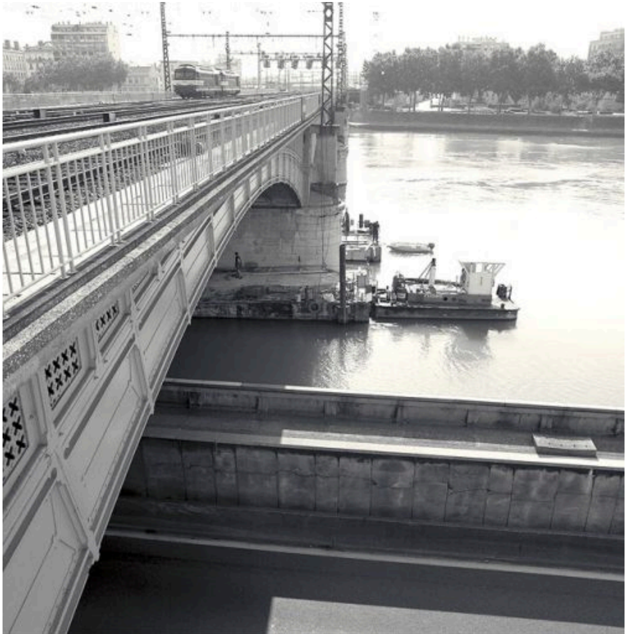
Vue des arches au-dessus du Rhône depuis l'ouest
