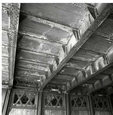
Travée de rive sur le quai Perrache : vue d'ensemble du dessous du tablier Phot. Eric Dessert IVR82_20026903819X
