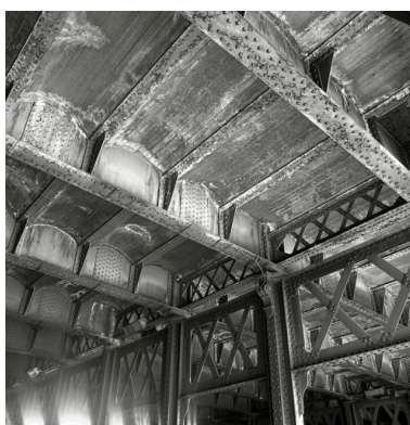
Travée de rive sur le quai Perrache : détail des voûtains du tablier Phot. Eric Dessert IVR82_20026903820X
