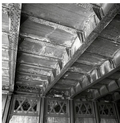
Travée de rive sur le quai Perrache : vue d'ensemble du dessous du tablier Phot. Eric Dessert IVR82_20026903819X
