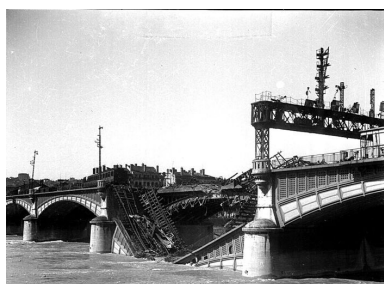
Vue du pont détruit par l'armée allemande les 1er et 2 septembre 1944 Phot. AM Lyon IVR82_20026900170NUCAB
