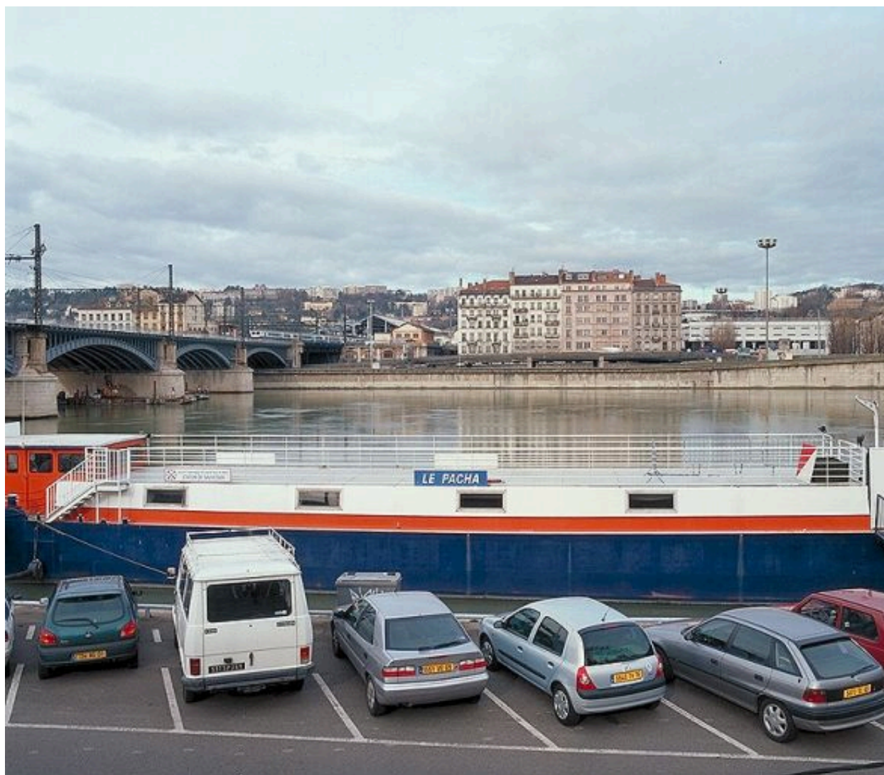
Vue d'ensemble du pont depuis le nord-est
