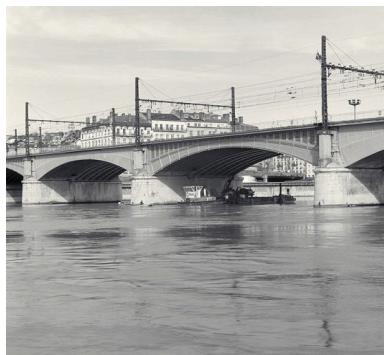
Vue rapprochée depuis le sud-est Phot. Eric Dessert IVR82_20026900192X
