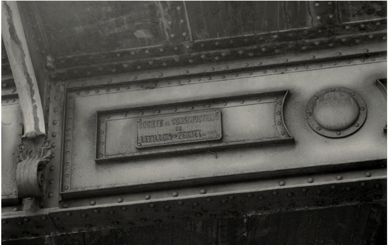
Travée de rive, quai Perrache : détail de la signature
