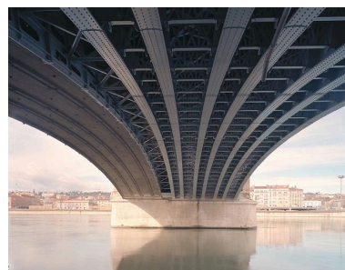
Une arche vue par dessous Phot. Eric Dessert IVR82_20026900196VE
