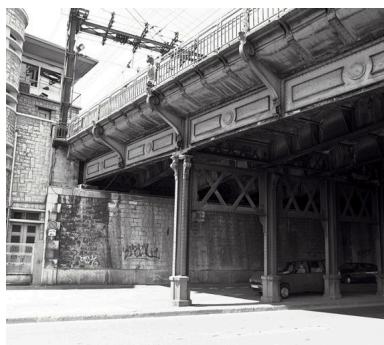
Vue de la travée de rive sur le quai Perrache, depuis le sud-est Phot. Eric Dessert IVR82_20026903817X
