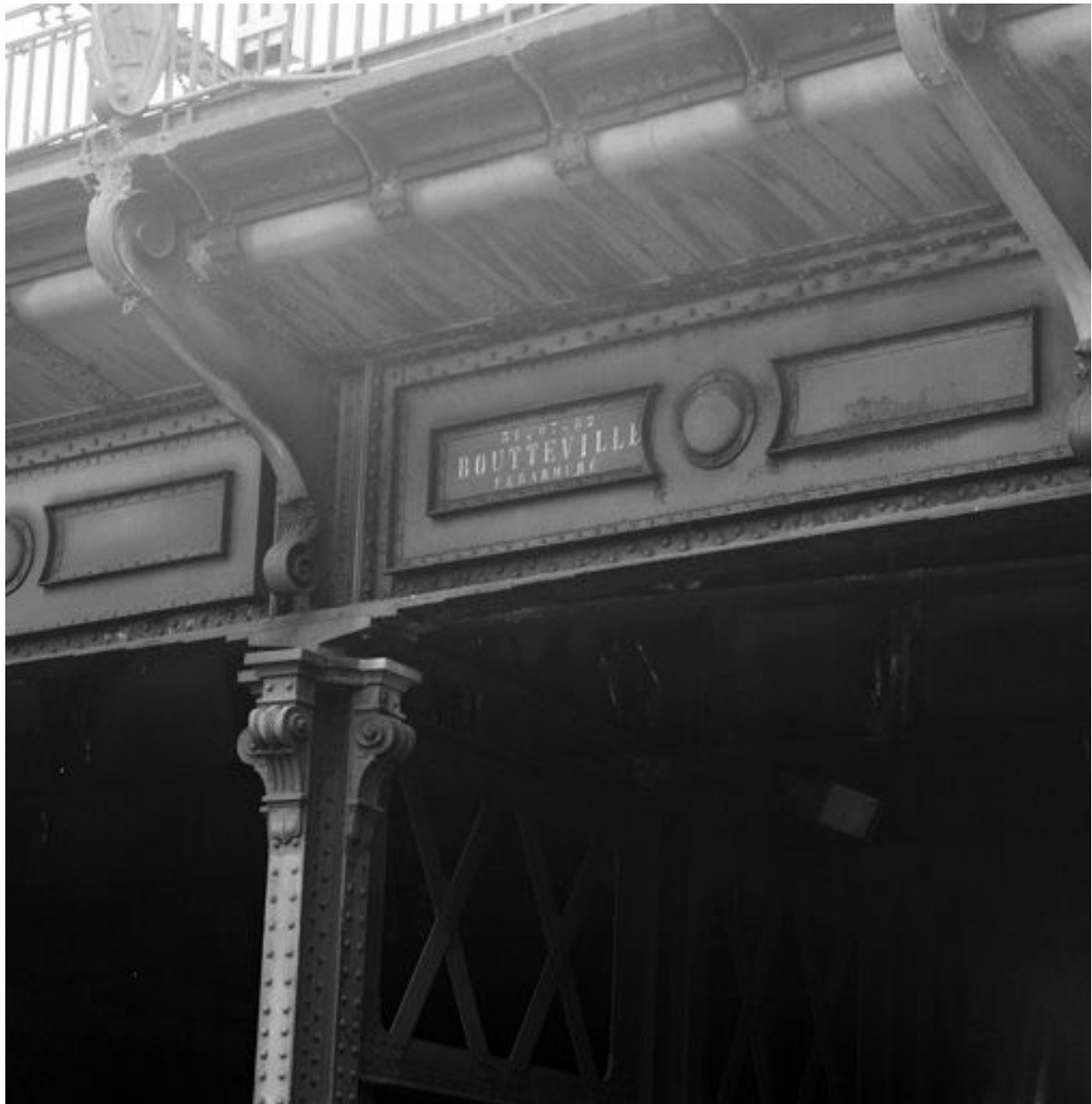
Travée de rive, quai Perrache : détail d'un pilier
