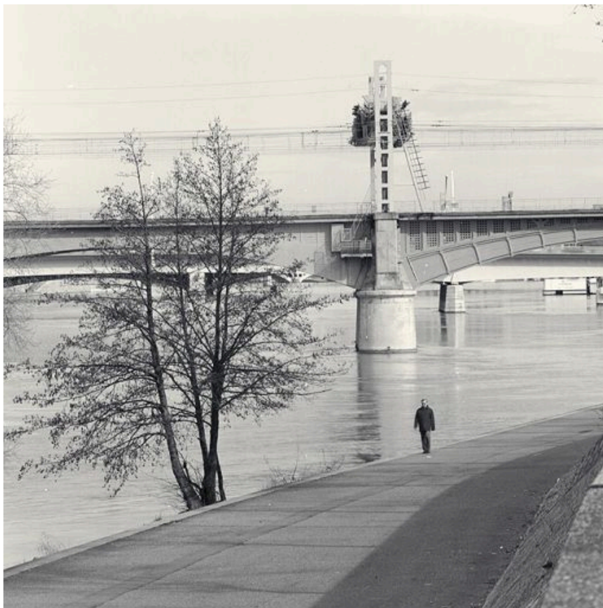
Détail d'une pile depuis le sud
