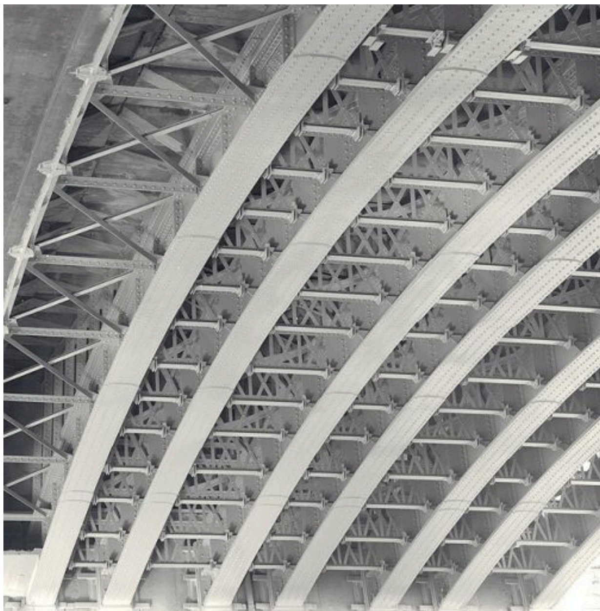
Détail du dessous des arches
