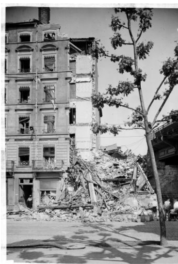
Destruction de la culée du pont après les bombardements du 26 mai 1944. Photogr. IVR82_20026903085NUCB
