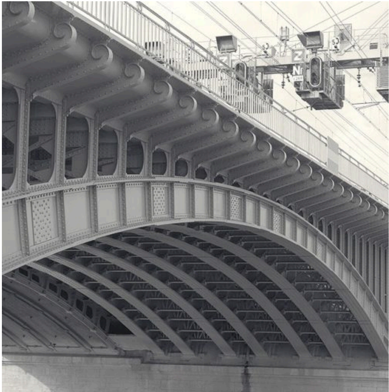
Détail d'une arche depuis le nord
