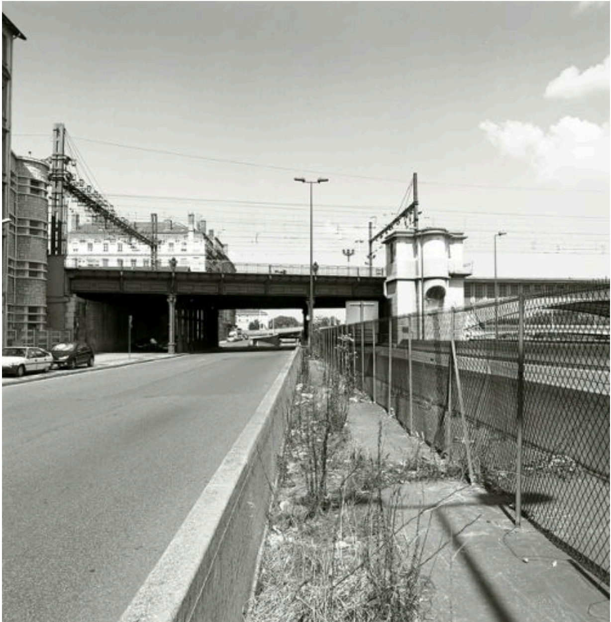
Vue de la travée de rive sur le quai Perrache, depuis le sud
