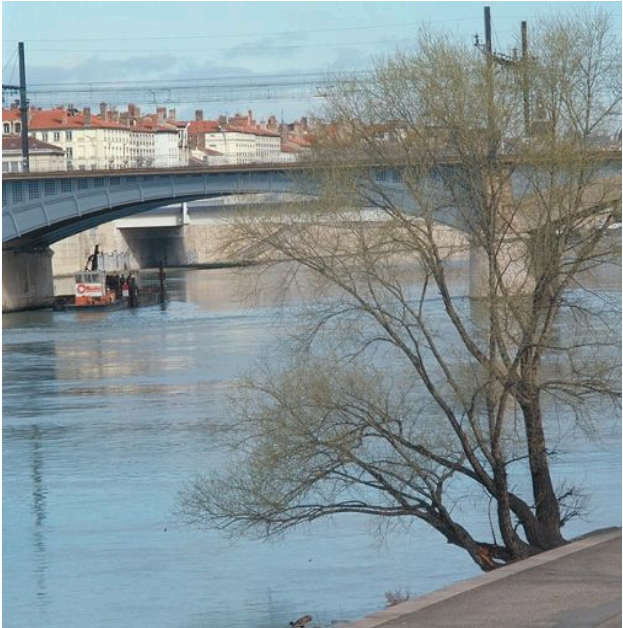
Vue de la travée centrale
