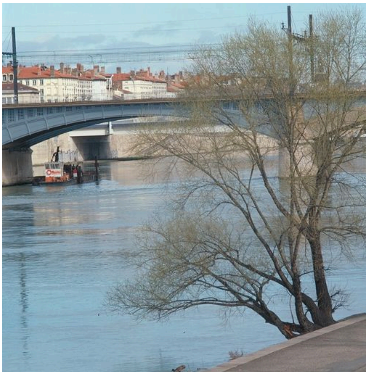
Vue de la travée centrale
