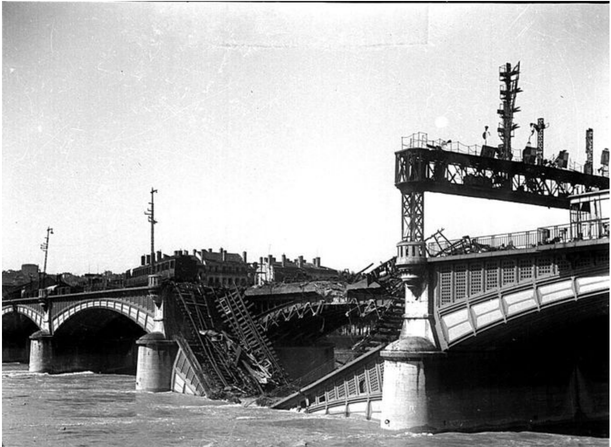
Vue du pont détruit par l'armée allemande les 1er et 2 septembre 1944
