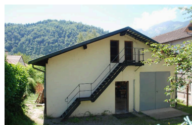
Élévation façade principale, depuis le nord Phot. Catherine Guégan IVR84_20167308904NUCAQ
