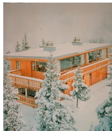
Vue depuis le sud-ouest Phot. Jean-François Lyon-Caen IVR82_19987300083ZA
