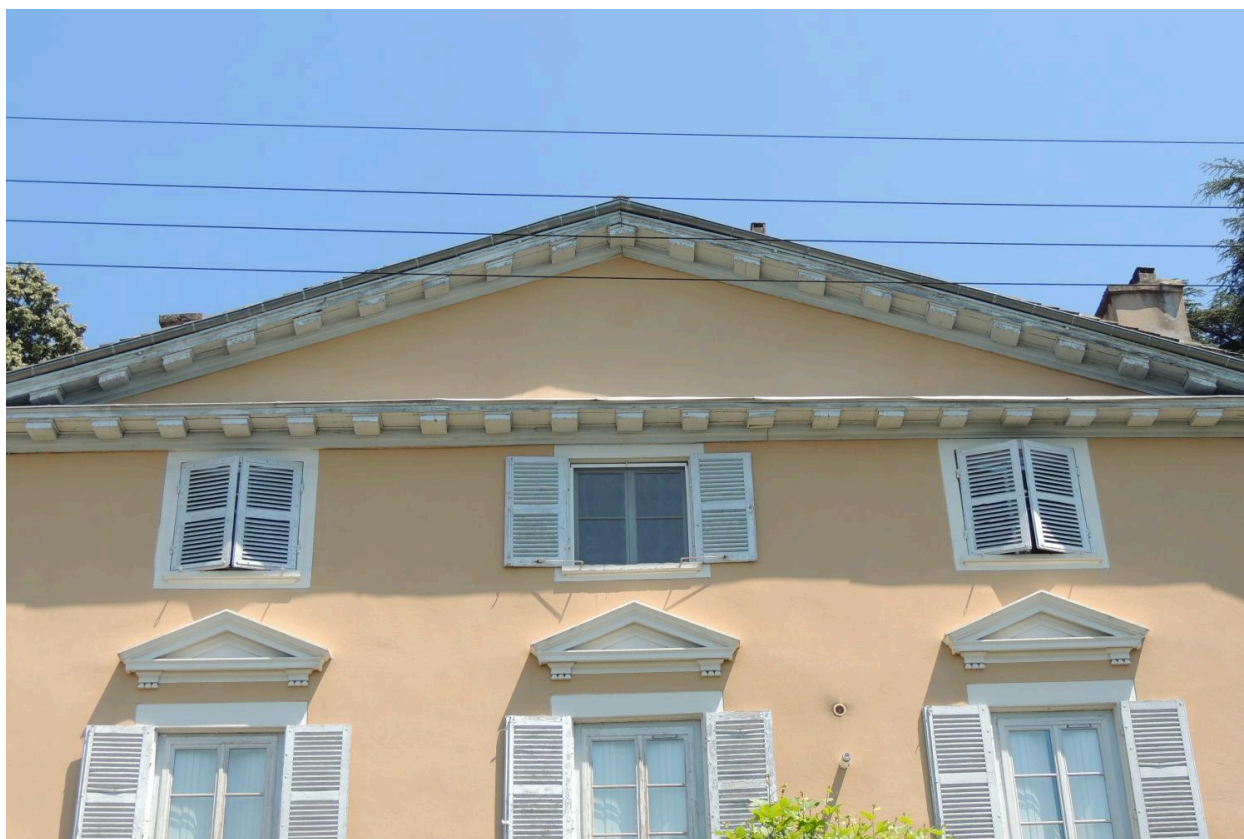
Façade : vue rapprochée du fronton.
