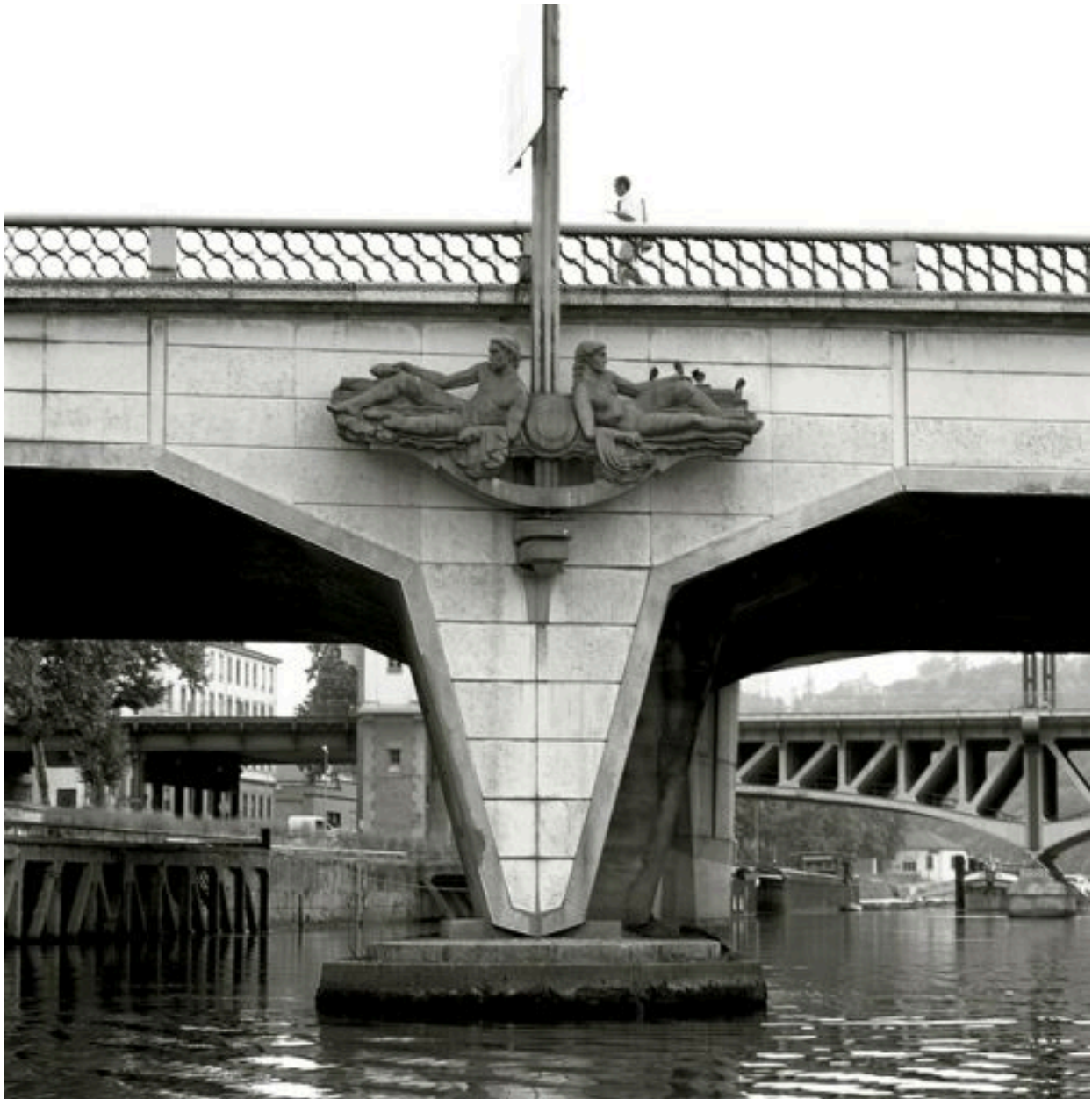
Vue d'ensemble de la pile est, côté nord, depuis la rivière
