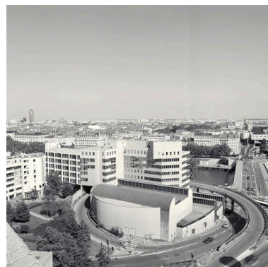
Vue du pont depuis la tour du tunnel de Fourvière à l'ouest Phot. Eric Dessert IVR82_20026903655X
