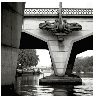
La pile ouest, côté sud, depuis la rivière Phot. Eric Dessert IVR82_20026903830X
