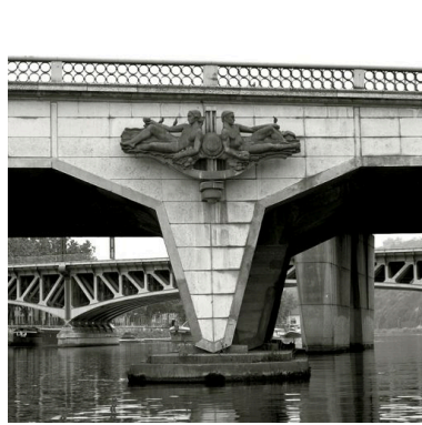
La pile ouest, côté nord, depuis la rivière Phot. Eric Dessert IVR82_20026903838X
