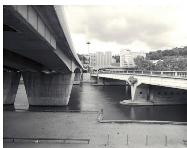
Le pont Kitchener-Marchand et le pont autoroutier au sud Phot. Eric Dessert IVR82_20026903641V
