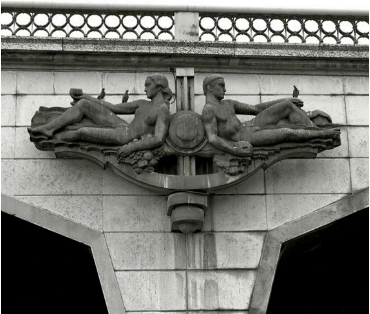
Vue rapprochée de la pile ouest, côté nord, depuis la rivière
