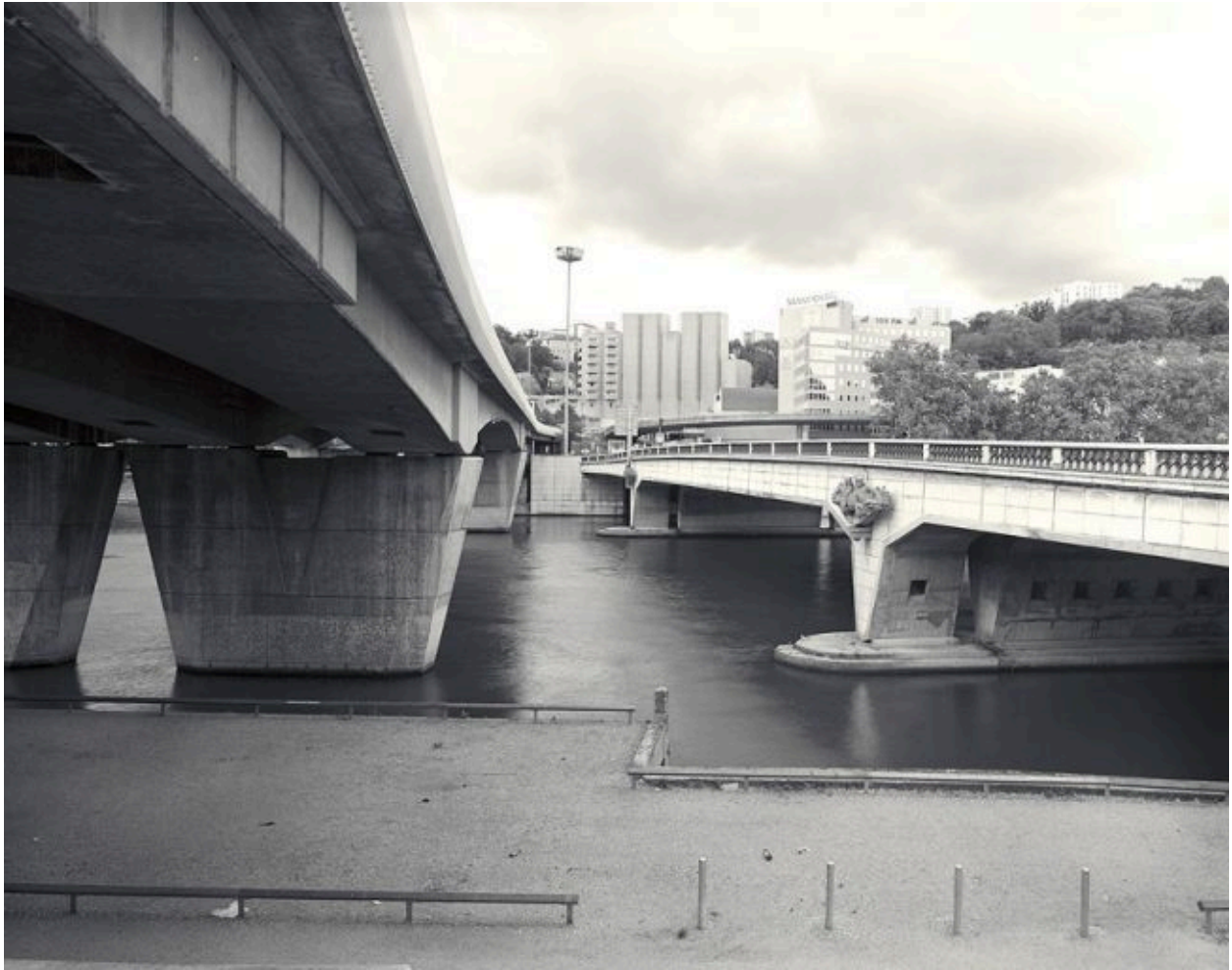
Le pont Kitchener-Marchand et le pont autoroutier au sud
