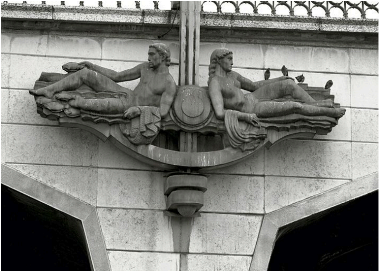
Vue rapprochée de la pile est, côté nord, depuis la rivière
