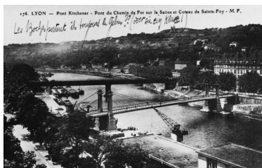
Vue du pont au début du 20e siècle, carte postale IVR82_20026900162NUCB
