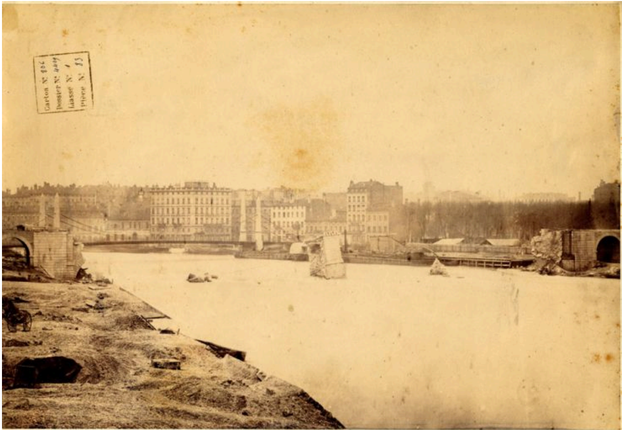
Vue du pont à l'arrière du viaduc ferroviaire effondré. Photogr. 1854
