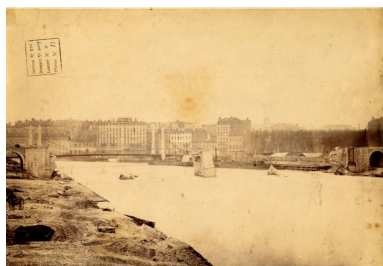
Vue du pont à l'arrière du viaduc ferroviaire effondré. Photogr. 1854 Repro. Jacques Gastineau IVR82_20036900344NUC
