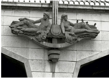
Vue rapprochée de la pile est, côté nord, depuis la rivière Phot. Eric Dessert IVR82_20026903834X
