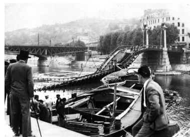
Pont Kitchener et Viaduc Quarante Le pont en 1944. Photogr. Repro. Jean-Marie Refflé IVR82_19826900232XB
