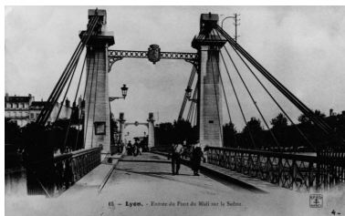
Entrée du pont suspendu, carte postale, [1er quart 20e siècle] IVR82_20026900165NUCB
