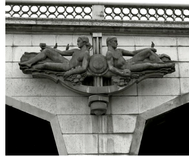
Vue rapprochée de la pile ouest, côté nord, depuis la rivière Phot. Eric Dessert IVR82_20026903839X
