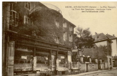
Façade postérieure Repro. François Fouger IVR82_20057300204NUCB
