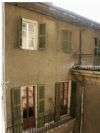
Détail de la façade sur rue Phot. François Fouger IVR82_20047300214NUCA
