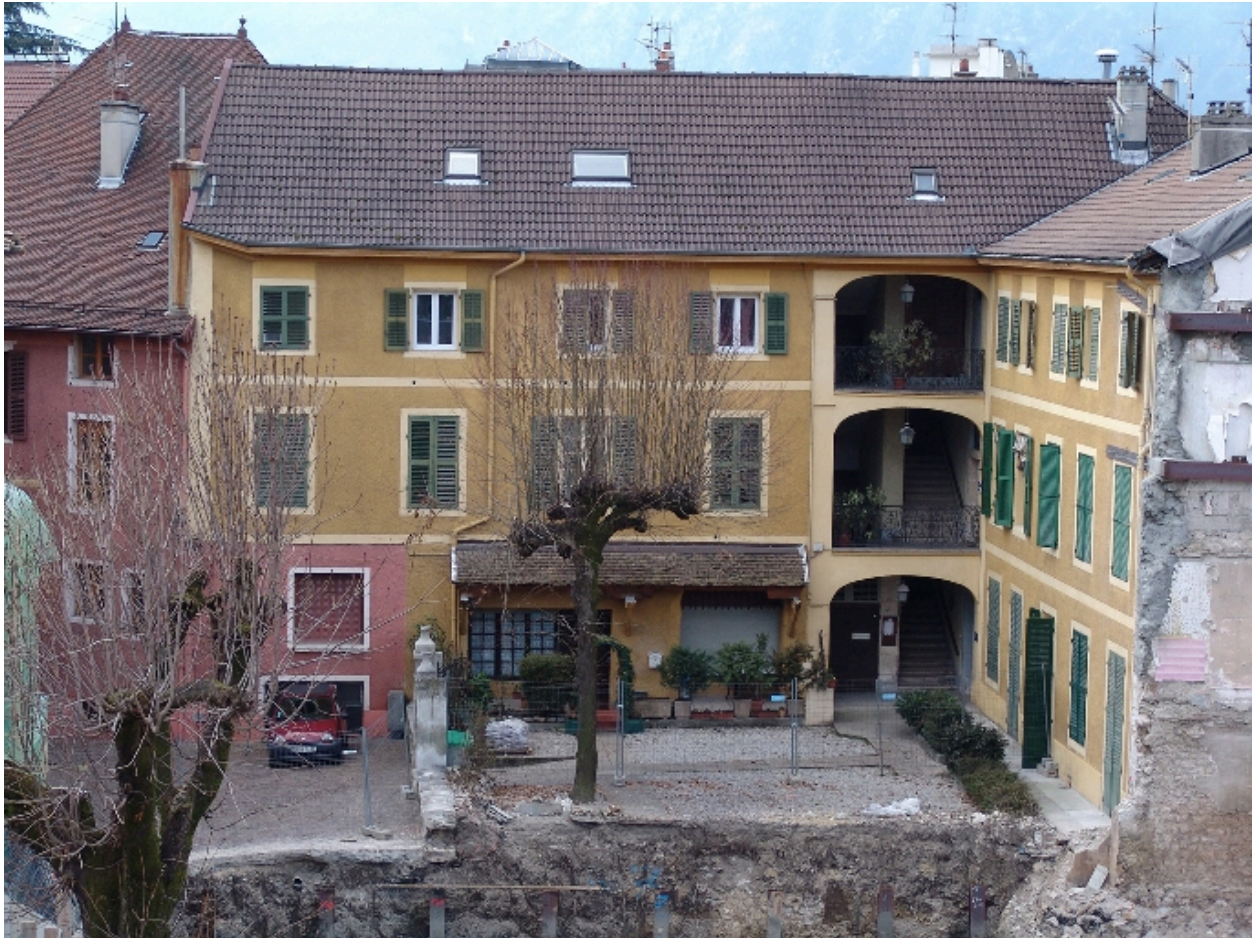
Vue des façades sur cour
