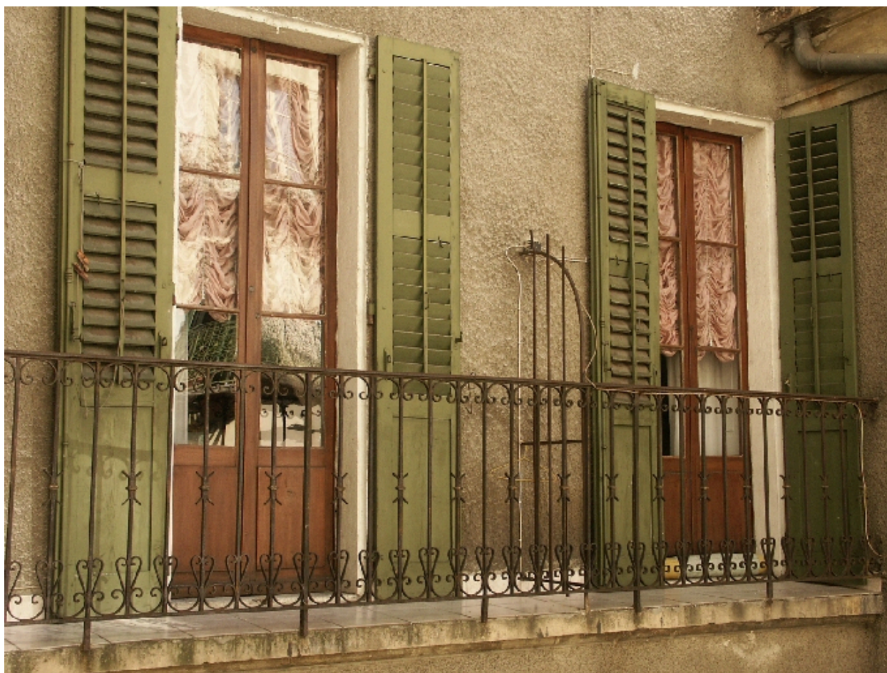
Balcon de la façade sur rue
