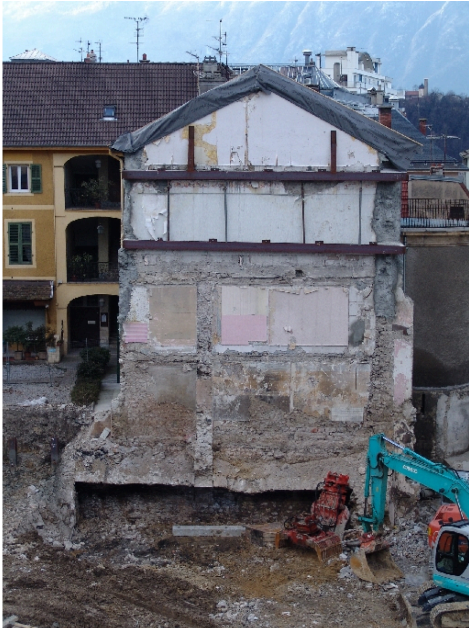
Pignon après destruction de l'hôtel mitoyen
