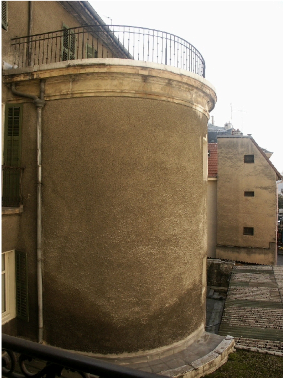
Ancienne tour des fortifications de la ville
