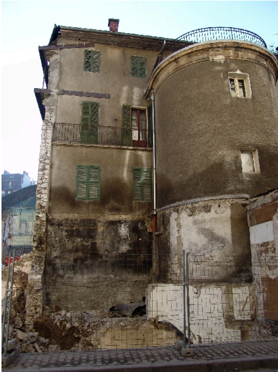
Détail de la façade sur la rue Daquin
