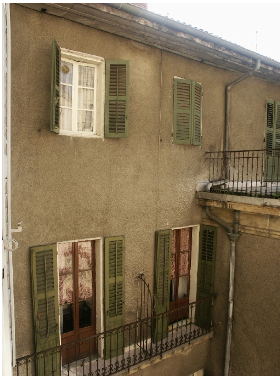
Détail de la façade sur rue
