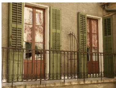
Balcon de la façade sur rue Phot. François Fouger IVR82_20047300215NUCA
