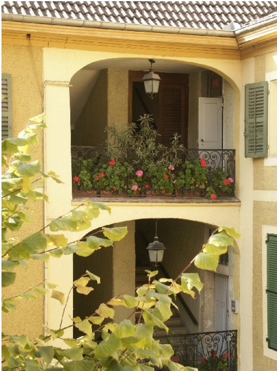
Détail de l'escalier ouvert sur la cour
