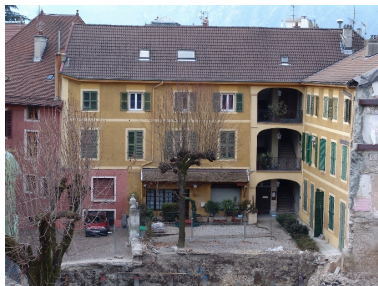
Vue des façades sur cour Phot. François Fouger IVR82_20057300738NUCA
