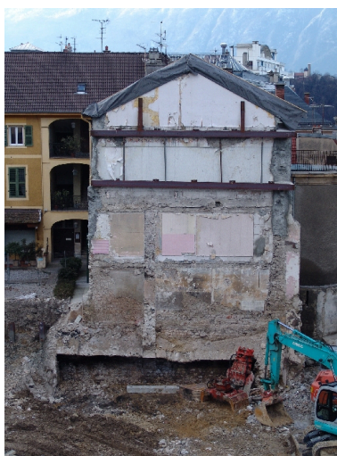
Pignon après destruction de l'hôtel mitoyen Phot. François Fouger IVR82_20057300737NUCA
