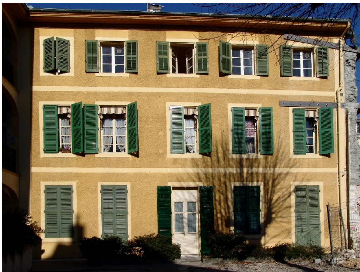
Façade sur cour de l'aile droite
