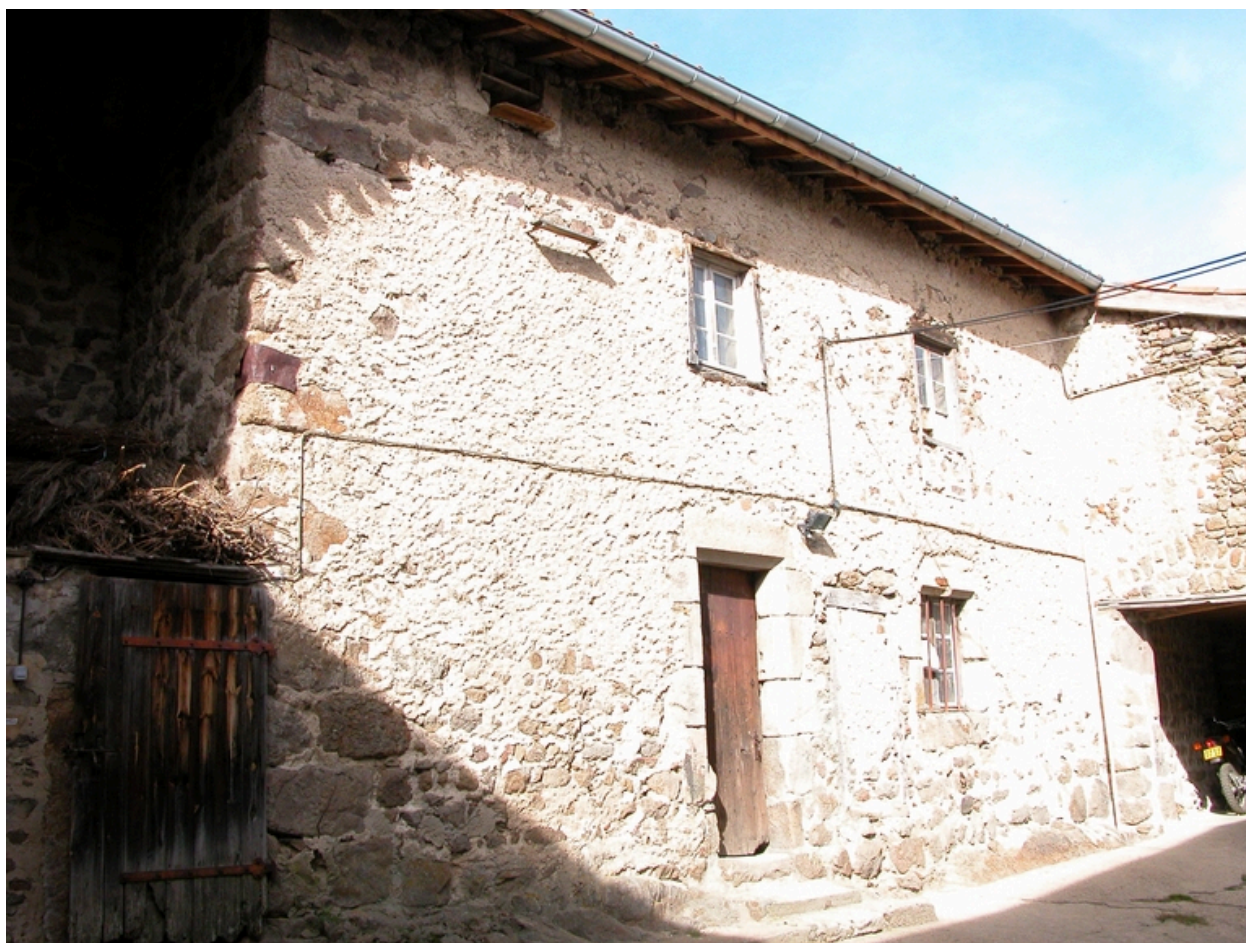
Vue d'ensemble du 1er logis.
