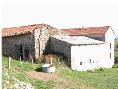
Vue arrière depuis le nord-ouest. Phot. Thierry Monnet IVR82_20124202165NUCA
