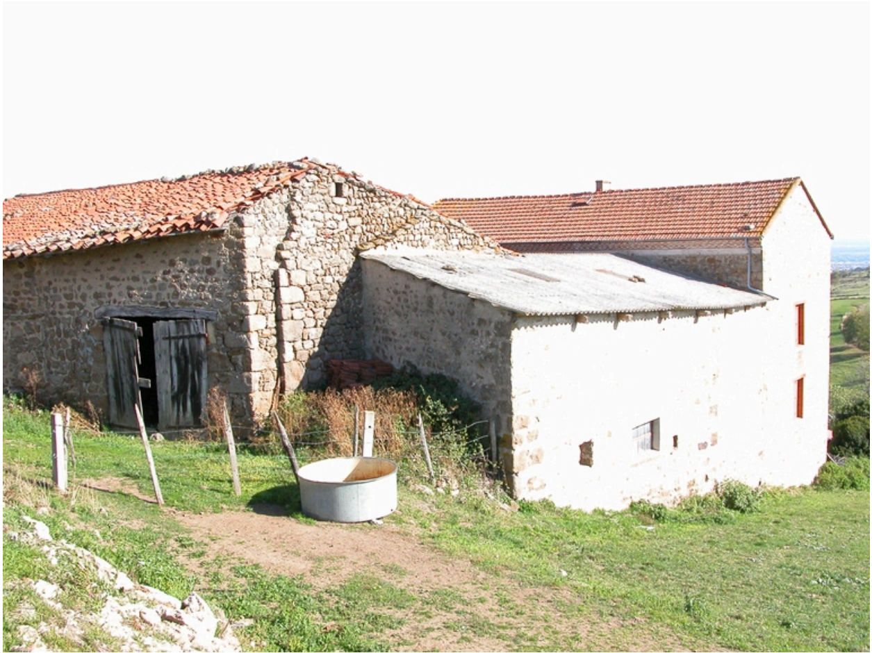
Vue arrière depuis le nord-ouest.
