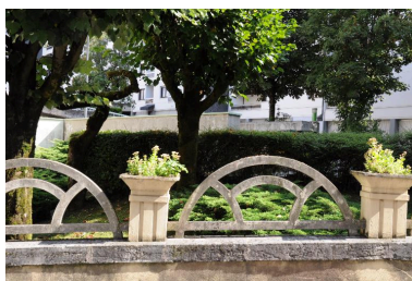
Détail de la barrière en ciment Phot. Denys Harreau IVR82_20147301154NUCA
