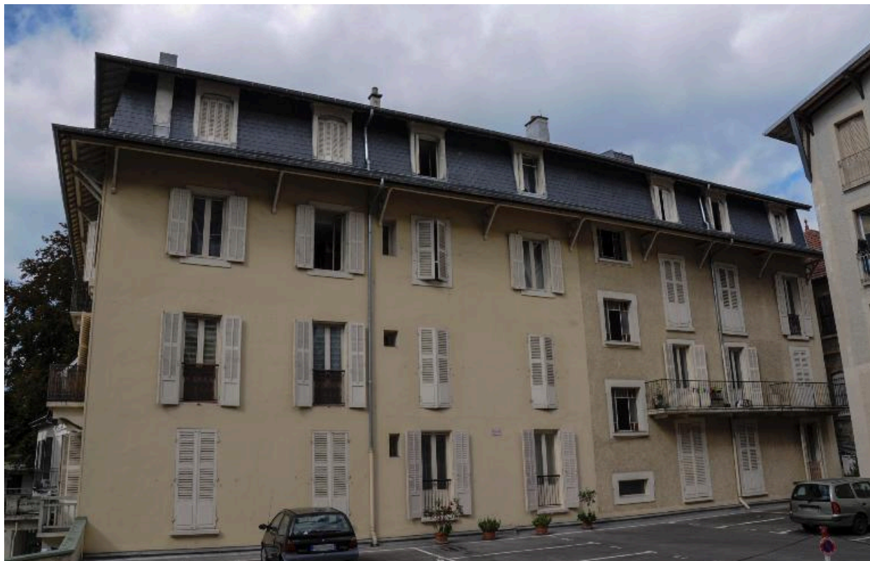
Façade postérieure (est)
