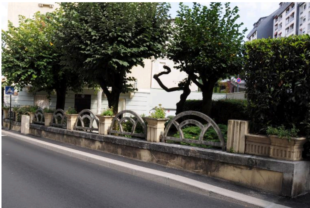
Barrière en ciment, rue Lamartine
