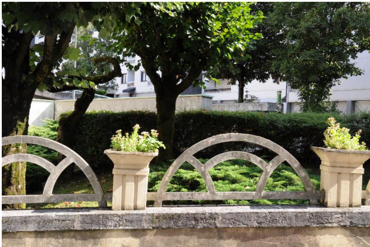
Détail de la barrière en ciment
