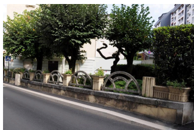
Barrière en ciment, rue Lamartine Phot. Denys Harreau IVR82_20147301153NUCA
