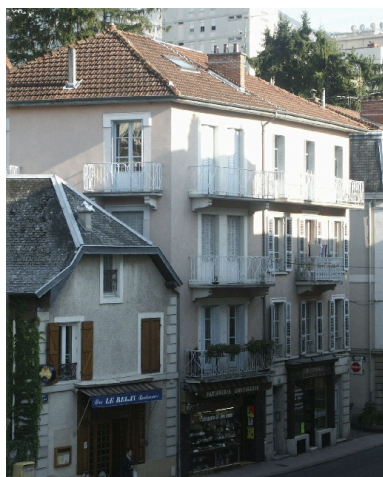
Façade sur la rue Davat Phot. François Fouger
