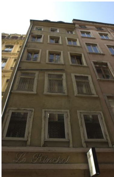
Façade, vue générale par-dessous Phot. Bernard Ducouret IVR82_20046900823NUCA
