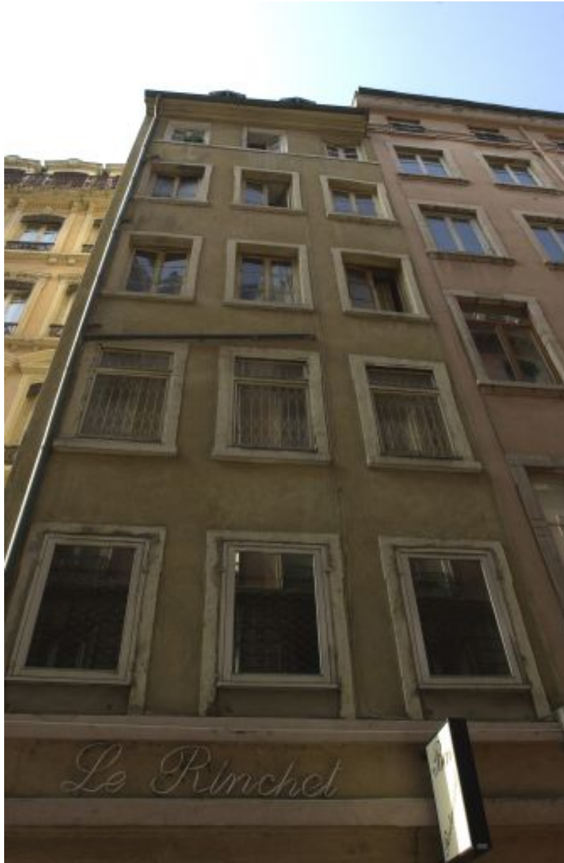
Façade, vue générale par-dessous
