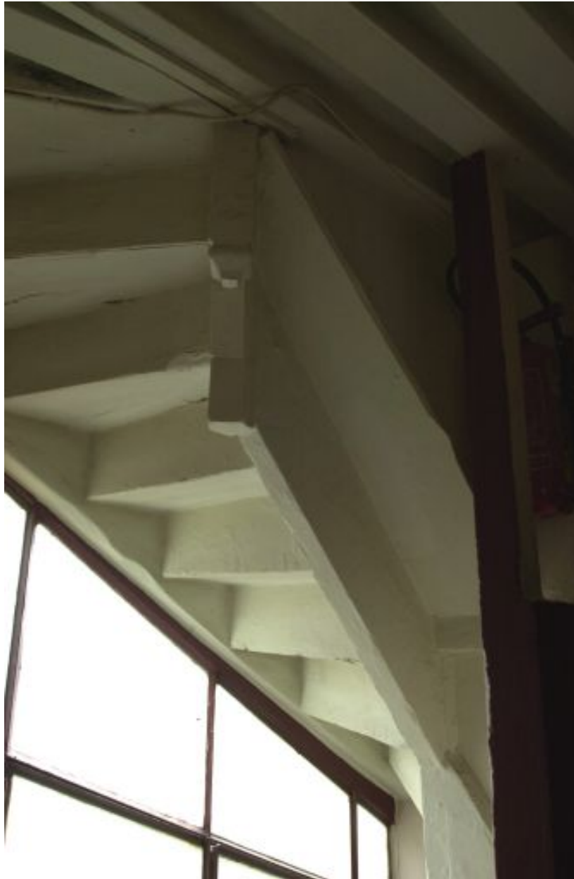
Petit escalier desservant l'étage de comble, vue par-dessous
