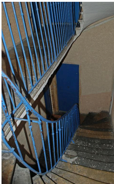
Vue intérieure : la cage d'escalier Phot. Magali Delavenne IVR84_20166901895NUCA
