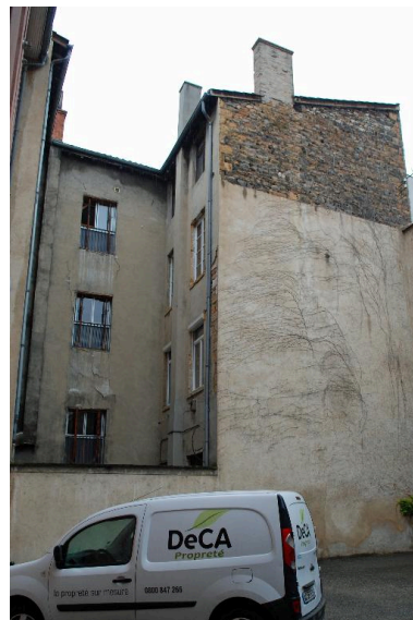
Elévations sur cour Phot. Magali Delavenne IVR84_20166901893NUCA
