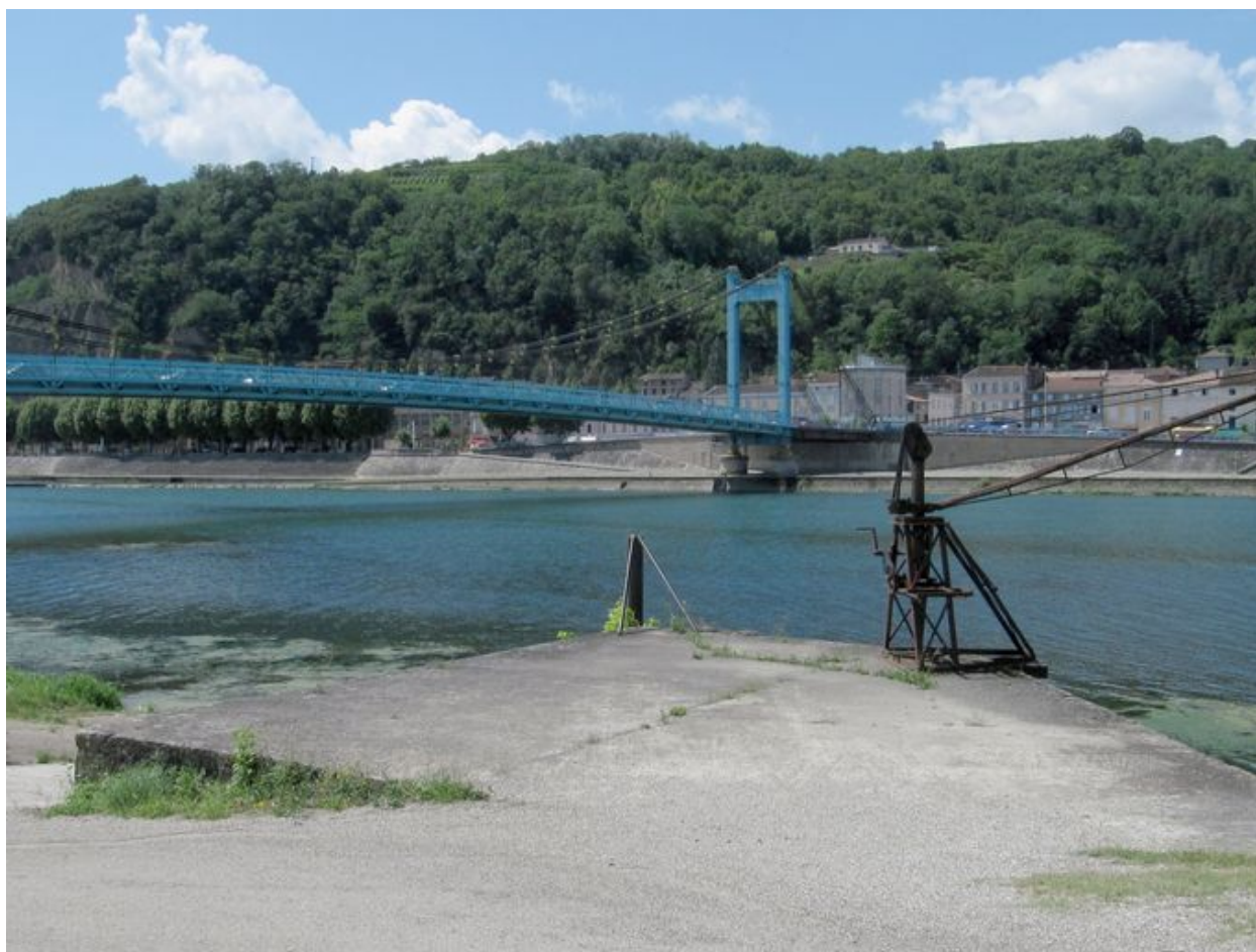
Vue du site supposé de l'ancienne traile de Serrières, à l'amont du pont suspendu
