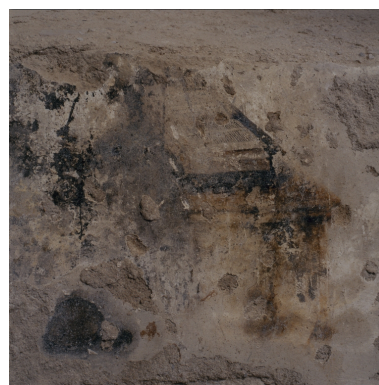
Détail de faux-appareil autour d'une fenêtre de l'abside. Phot. Eric Dessert IVR82_20034200098XA
